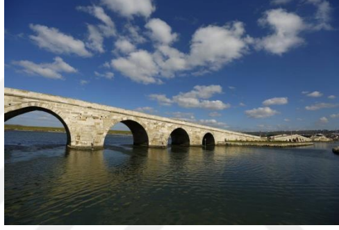
Şekil 1.6. Tarihi Kanuni Sultan Süleyman köprüsü (Anonim 4)
