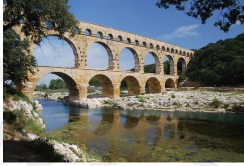
Şekil 1.4. Fransa da bulunan Pont du Gard su kemeri (Anonim 2)
