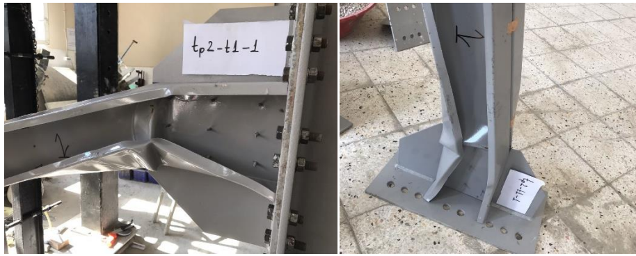
Şekil 4.23. Göçme modu deney Tp2-t1-1 (No: 1)
