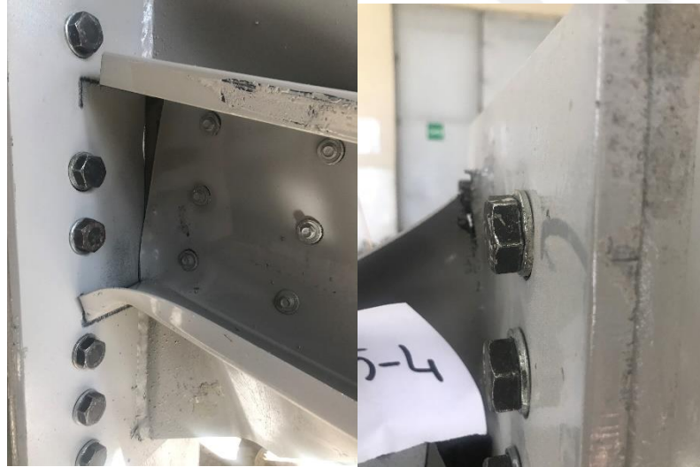
Şekil 4.26. Göçme modu deney Tp2-t2,5-4 (No: 4)
