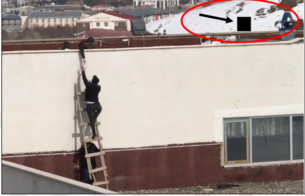
Şekil 3.18 İvmeölçerlerin teras kuleleri üzerinde konumlandırılması
