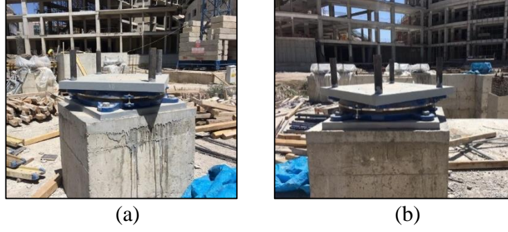
Şekil 3.8 (a) ve (b) Sürtünme esaslı izolatör
