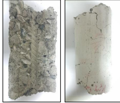
Şekil 4.97 KA2 grubu numunesi içi çatlak detayı
