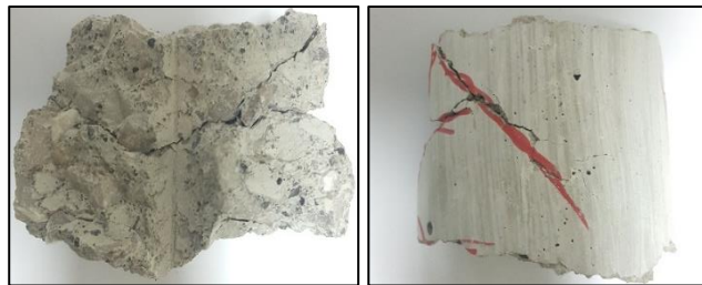
Şekil 4.51 Yaz grubu aderans numunesi çatlak detayı
