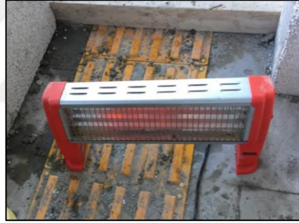
Şekil 3.38 Muhafaza alanında kullanılan ısıtıcı
