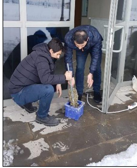
Şekil 3. 10 Atmosferik kış şartlarında yapılan döküm
