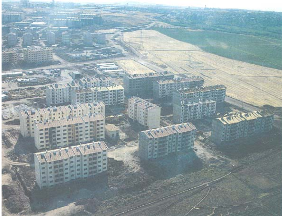
Diyarbakır Şilbe I. etap toplu yerleşmesi inşaatından görünüm
