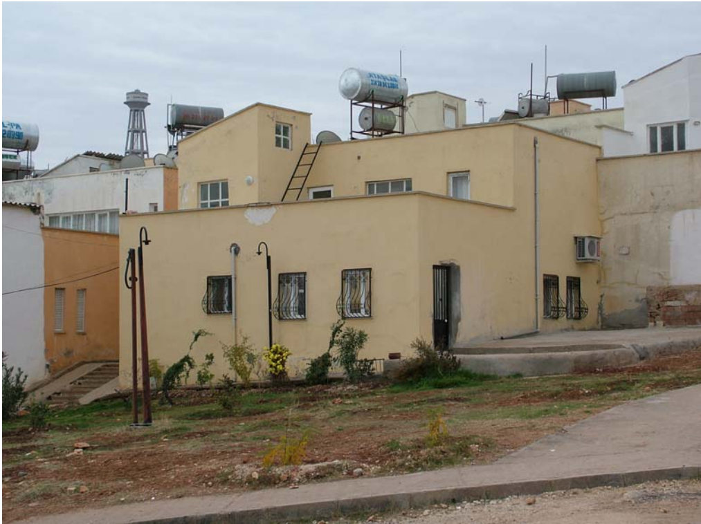
Şanlıurfa Akabe Geleneksel etap toplu konutlarından tadilata uğramış bir konut
