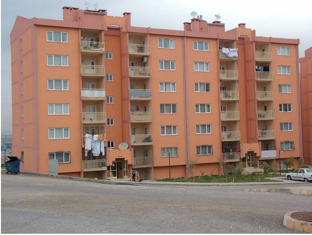
Şanlıurfa Akabe I. etap toplu konut yerleşmesi 128 m 2 'lik konut
