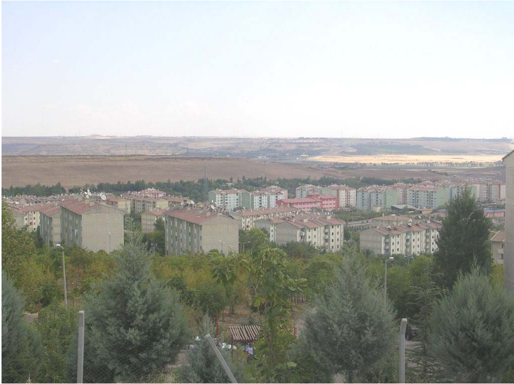
Şekil 5 Diyarbakir Şilbe I. etap toplu konutlarından görünüm
