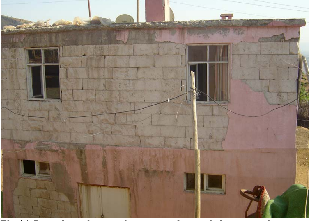
Ek: 4.1. Duvarda gaz beton malzeme ve üst döşemenin betonarme döşeme olarak bırakılması
