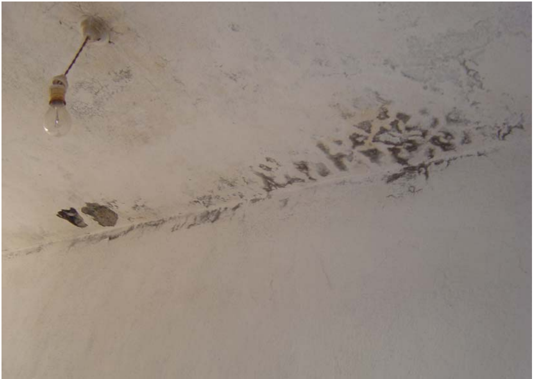
Ek: 4.16. Üst döşemede su sızıntısı
