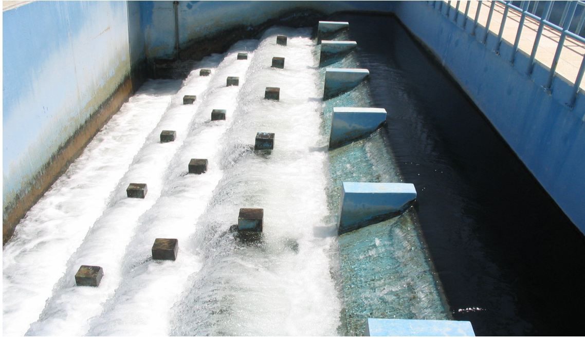
Resim 1. Dengeleme ve Havalandırma Yapısı
