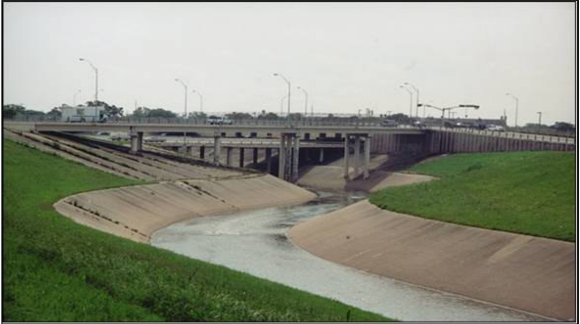
Şekil 2.1 Yapay açık kanallara bir örnek
