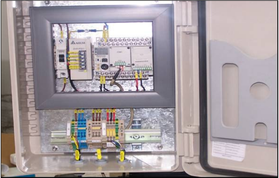
Şekil 3.4 Veri dönüştürücü ve kaydedici
