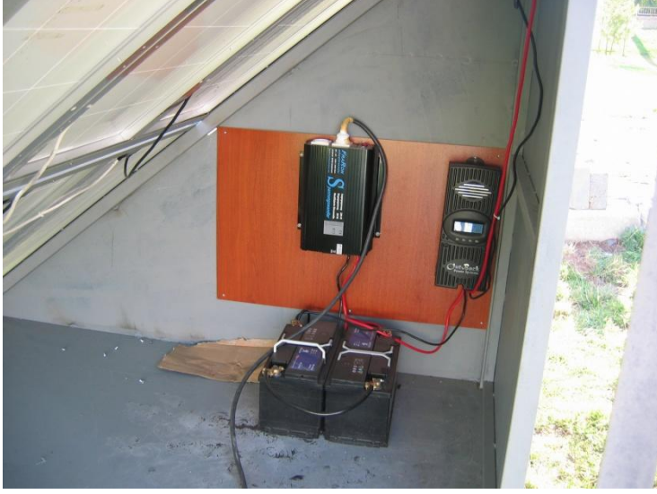
Şekil 4.8. Uygulama Sitemindeki bataryalar, evirici ve MPPT
