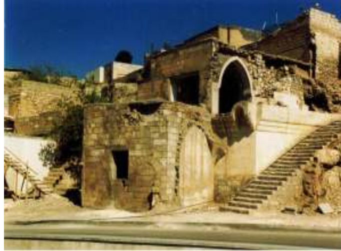
Resim 6.4. Çardaklı Köşk'ün Restorasyon Sırasındaki Fotoğrafi 6 .
