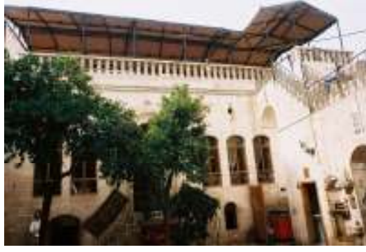
Resim 6.99. Pergola ile Örtülü Bölüm.
