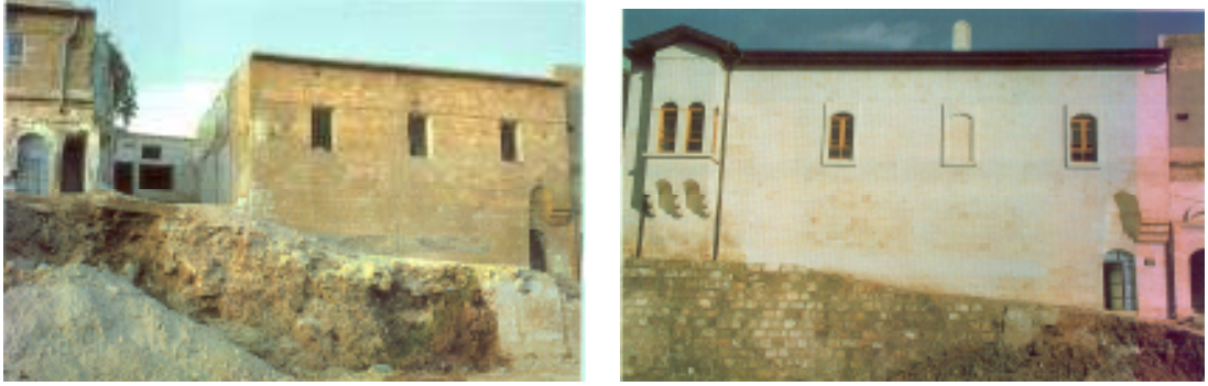
Resim 6.61. Şurkav Kültür Merkezine Katılan Parsel ve Restorasyon Sonrası.
