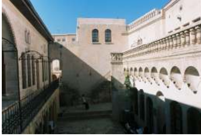
Resim 6.31. Dikdörtgen Avlunun Batı Cephesi.
