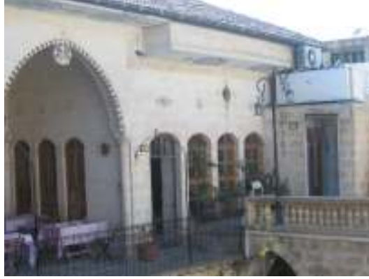
Resim 6.77. Döşemenin Saçak Olarak Çıkma Yapması.
