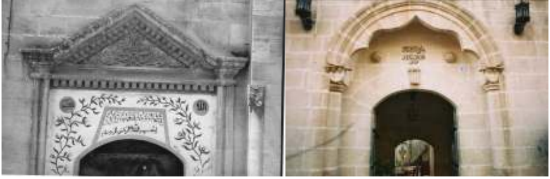
Resim 6.91. Pınarbaşı Konağı'nın Yıkılan Selamlık Bölümünün Giriş Kapısı ve Restorasyon Sırasında Yenilenen Giriş Kapısı
