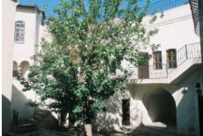
Resim 6.27. Tenekeçiler Evi Restorasyon Sonrası Durumu.
