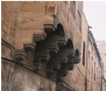
Resim 4.5. Düz Çıkma Altı Konsolu.
