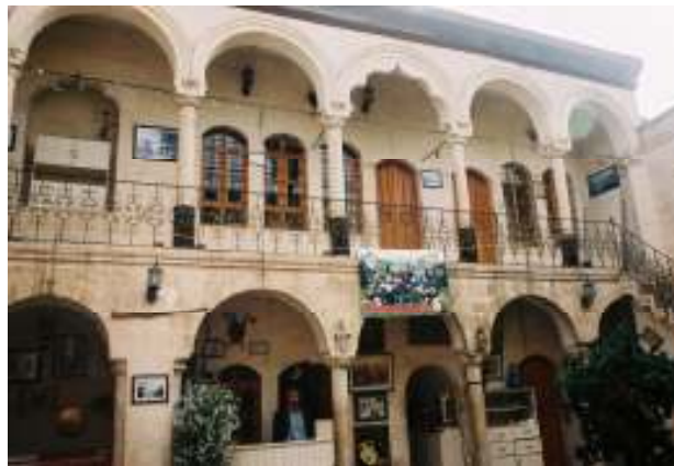
Resim 6.47. Pınarbaşı Konağı Avlunun Güney Cephesinin Tescil Tarihindeki ve Bugünkü Durumu .
