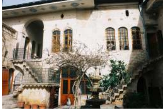
Resim 6.41. Avlunun Doğu Cephesi.
