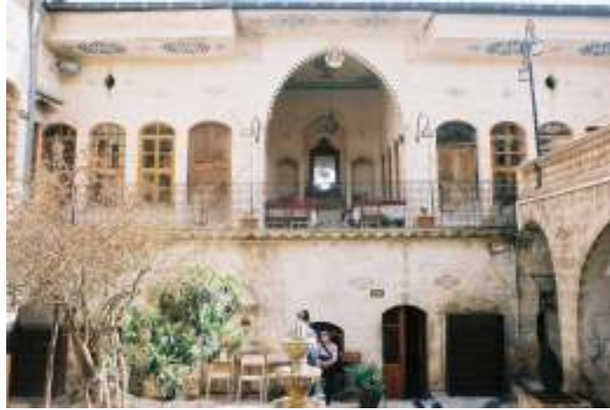
Resim 6.40. Avlunun Güney Cephesindeki Eyvan.
