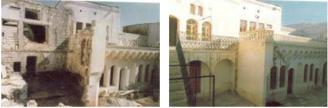
Resim 6.94. Eklenen Revak ve Gezeneėin Restorasyon  ncesi ve Sonrası Durumu.
