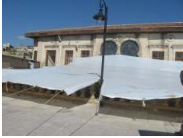
Resim 6.97. Cevahir Konuk Evi Kırma Çatı ve Avlunun Naylon Örtüsü (2008).
