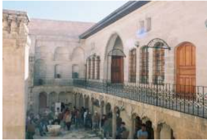
Resim 6.30. Dikdörtgen Avlunun Güney ve Doğu Cephesi.
