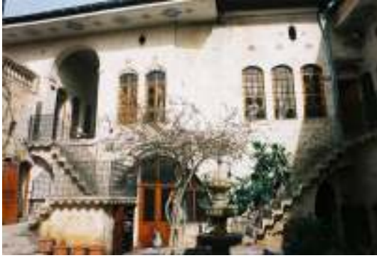
Resim 6.71. Avlunun Doğu Cephesi.
