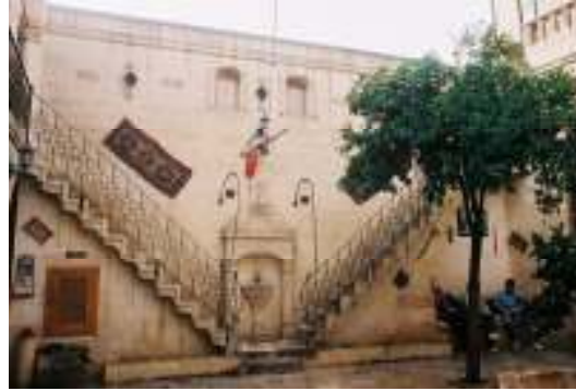
Resim 6.92. Avlunun Batı Cephesindeki Duvara Eklenti Yapılan Taş Çeşme.
