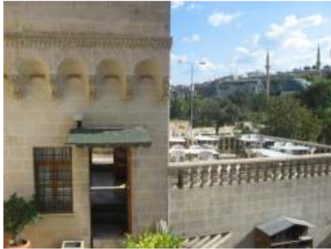
Resim 6.5. Çardak 2 ve Önündeki Küçük Teras.
