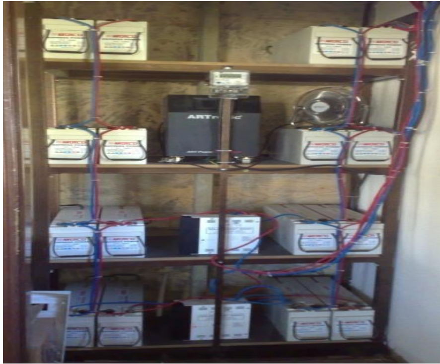
Şekil 4.3. Güneş Evi'nde kullanılan bataryalar, inverter ve şarj regülatörü
