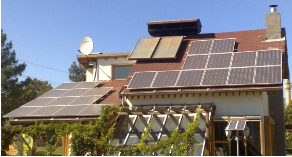
Şekil 4.2. Güneş gözelerinin çatıya monte şekli
