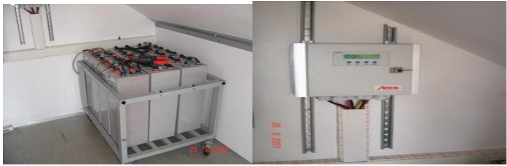
Şekil 4.7. Bataryalar ve Şarj Regülatörü
