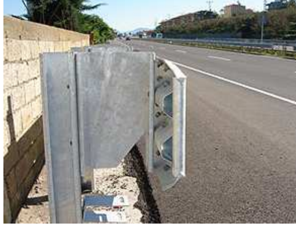
Şekil 1.6 Ağır hizmet tipi otokorkuluk [7]
