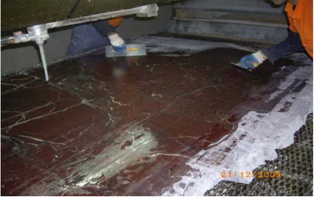
Şekil 3.18. Plakalara Epoksi + Elyaf File Uygulaması
