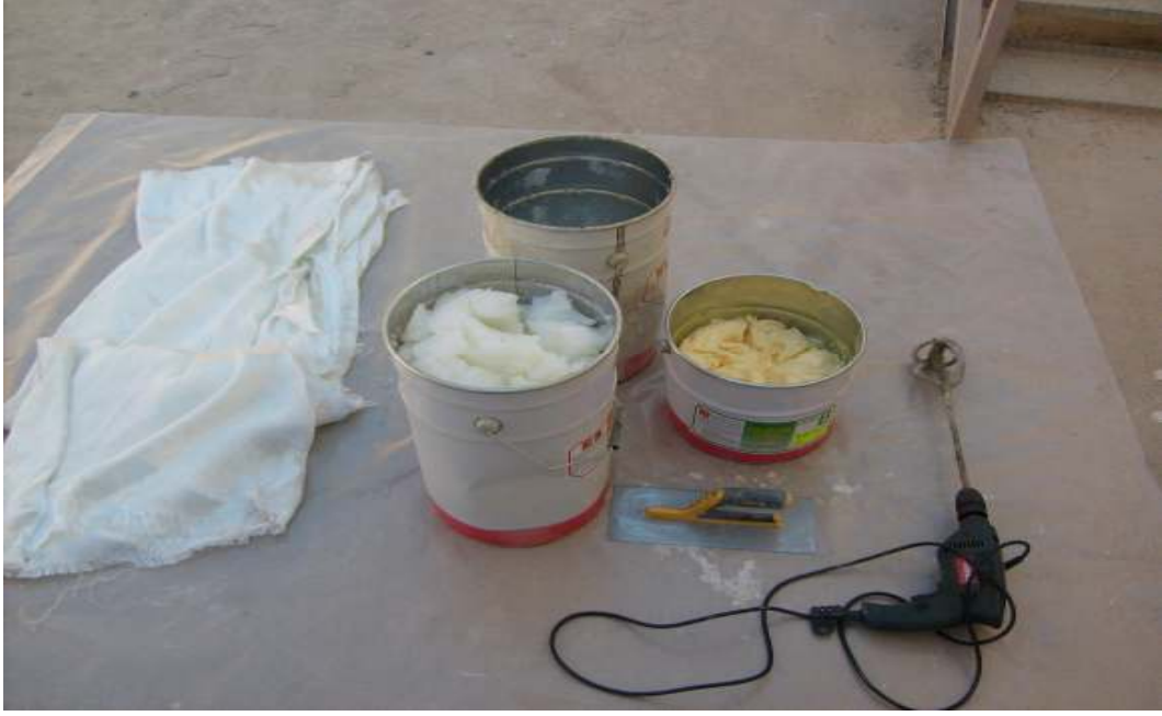
Şekil 3.8. Blok Güçlendirme işleminde Kullanılan Malzeme ve Ekipmanlar
