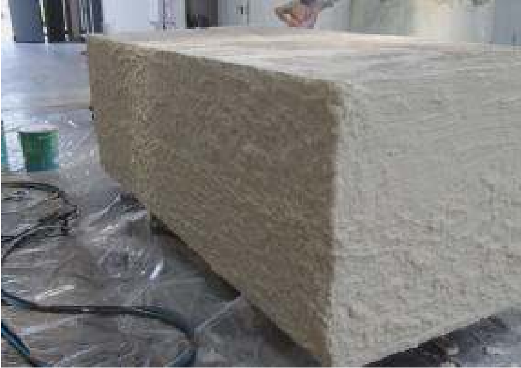
Şekil 2.5. Epoksi Püskürtmesiyle Yapılmış Blok Güçlendirme Uygulaması
