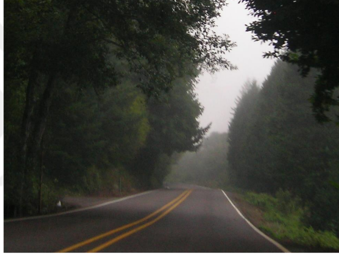
Şekil 1.19 Asfalt kaplama yol görüntüsü
