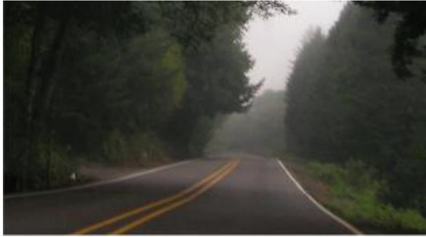
Şekil 1.7 Asfalt kaplama yol görüntüsü
