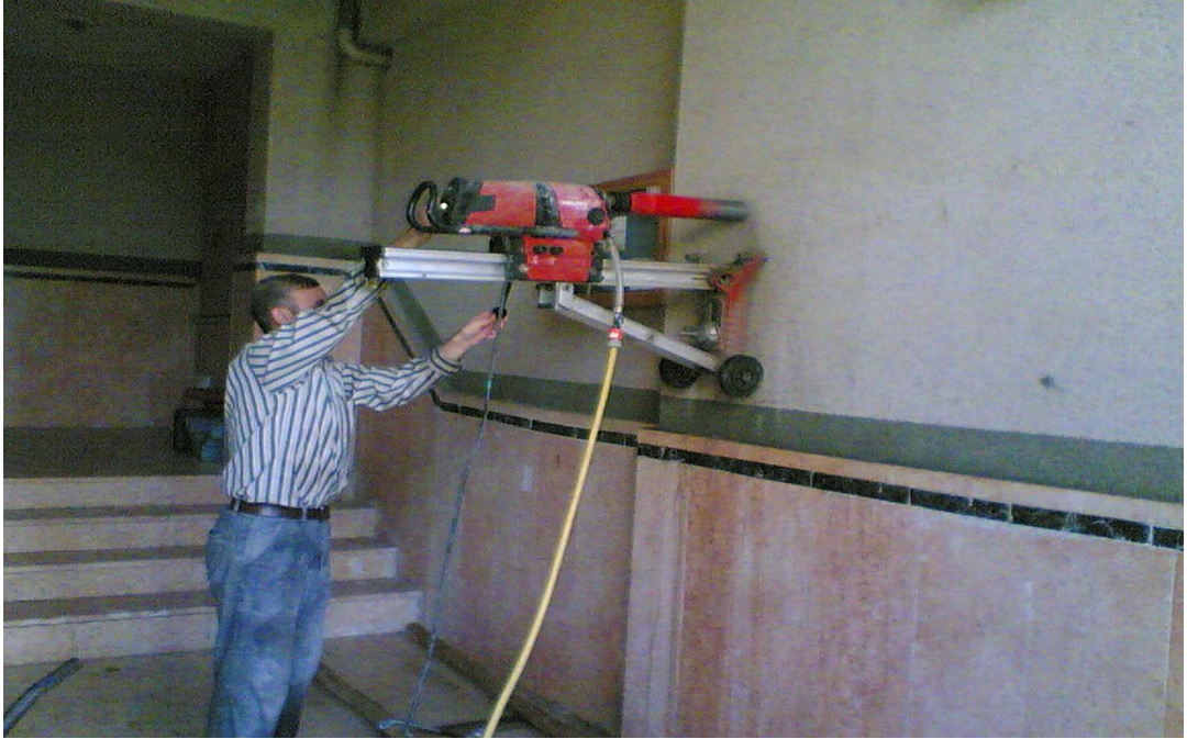
Şekil 7.2 Karot Alma Makinası İle Kolondan Silindir Beton Numunesi Alınması
