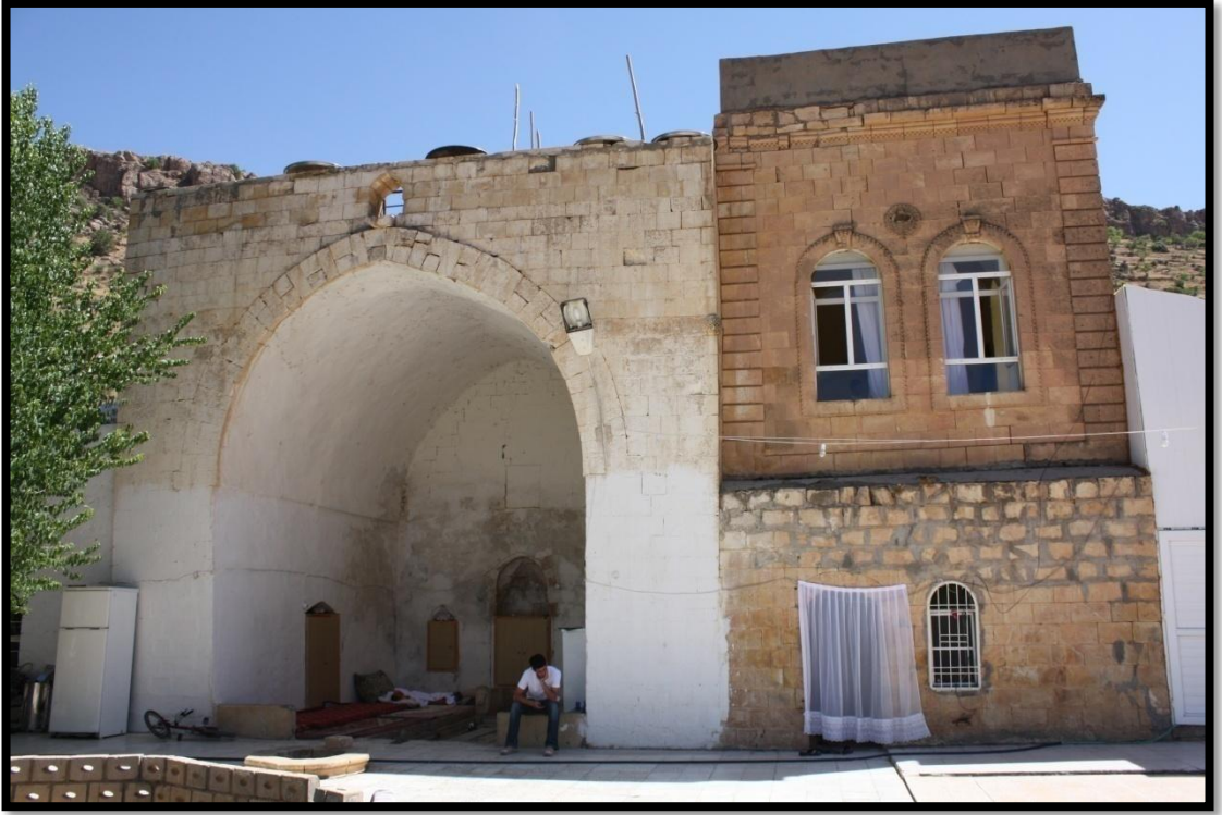
Resim 7.1.4.b: Pvc Pencereli, Tas Yüzeyleri Boyalı Aybar Kasrı Cephesi
