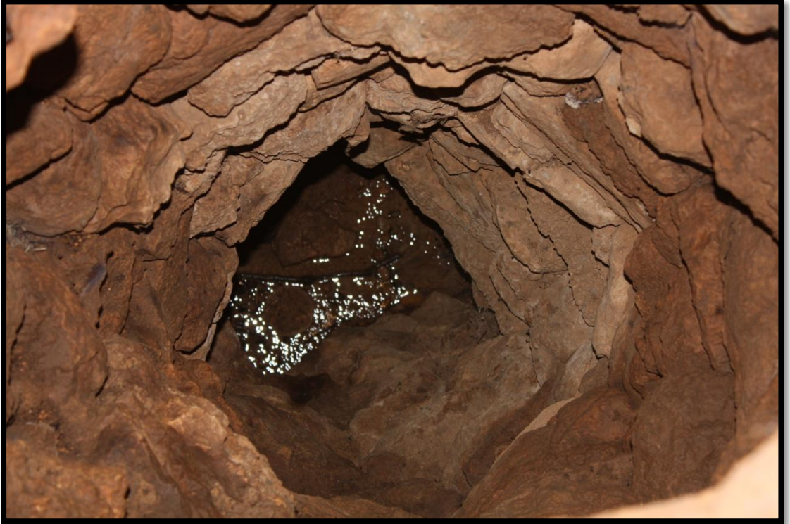
Resim 6.1.b: Kuyunun İ Grnm, Altta Serap Kanalından Akan Su
