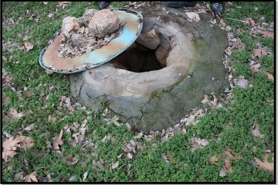
Resim 6.1.a : Mdahale Kuyularından Birinin Dıřtan Grnm
