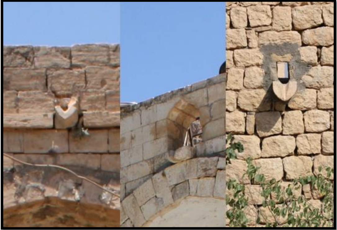
Resim 6.3.1.4 a : Kasır Damlarında Kullanılan Çörtenler
