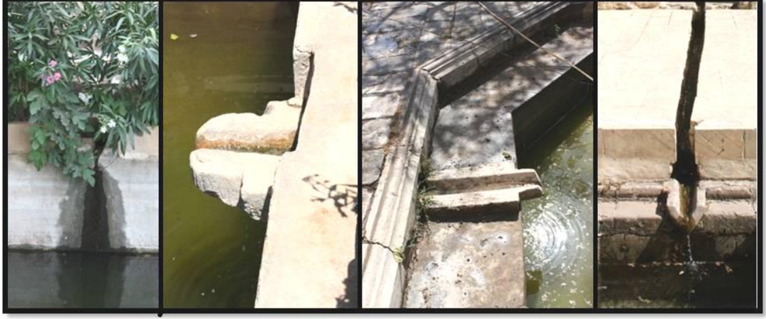
Resim 6.3.1.4 b : Kasır Havuzlarında Kullanılan Çörtenler (mezripler)
