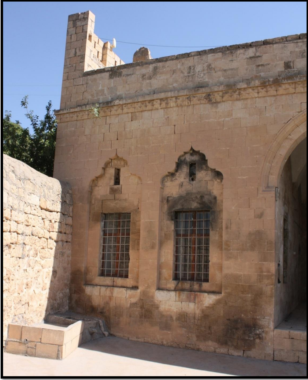
Resim 6.3.1.2.a : Bahrıltor Konağının Üst Kattaki Pencere Cephesi
