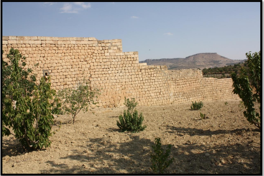
Resim 6.4.2.a: İskender Kasrının Kaba Yonu Taşlı Arka Cephesi
