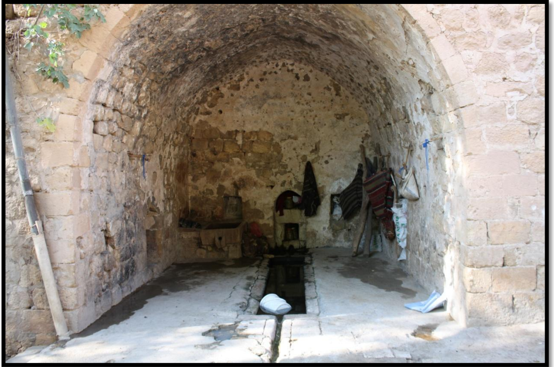
Resim 6.4.2.c: Üstü Sıvalı Kaba Yonu Taş Saraçoğlu Kasrı
