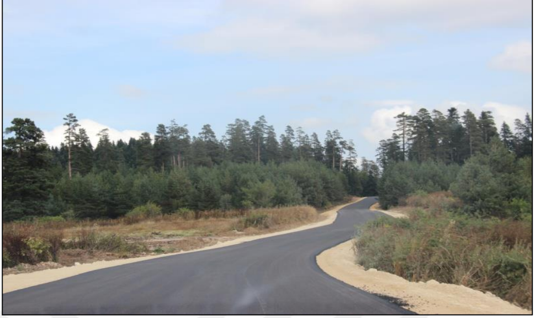
Şekil 1.10 : Asfalt kaplama yol görüntüsü
