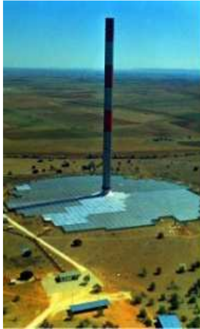
Şekil 2. 3. İspanya Manzanares Güneş bacası sistemi görüntüsü (Schlaich ve ark 2004).
