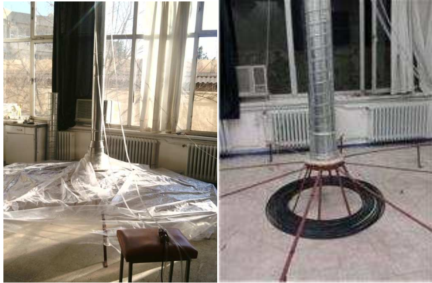
Şekil 3.12. Sağda siyah boru uygulaması solda önceki halde alınan ölçüm görüntüsü.
