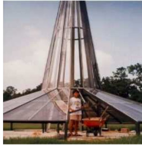
Şekil 2. 1. Florida Üniversitesi güneş bacası uygulama prototipi kesit şekli ve görüntüsü (Florida University, 2005).
