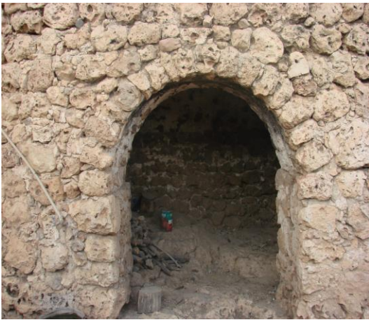
Zemin kattaki kemerli geçit
