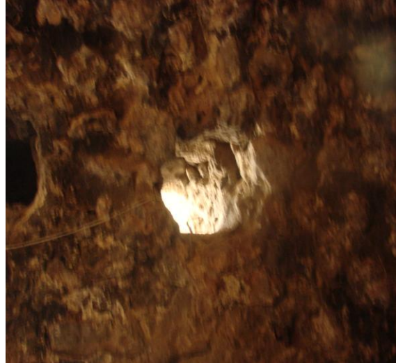
Zemin kattaki havalandırma boŐluđu
