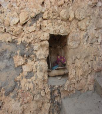
Avlu duvarındaki niş
