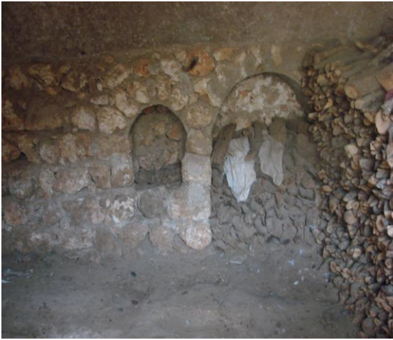
Yapının odunluk olarak kullanılan zemin katı
