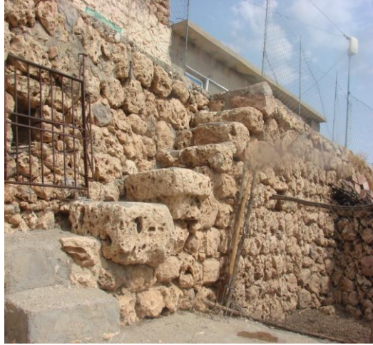
Üst kata geçişi sağlayan merdiven
