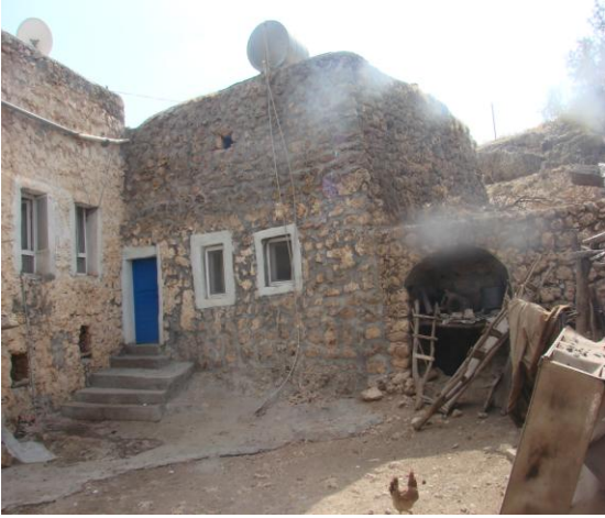
Yapının kapatılan kapı-pencere boşlukları
