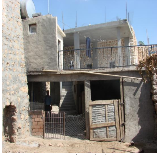
Yapının avlu cephesi
