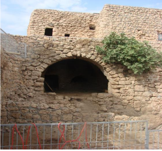
Yapının ahır kapısının yanındaki kemerli giriş
