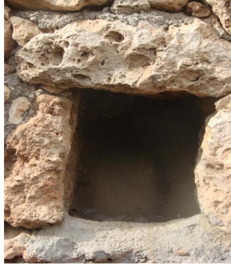
Avlu duvarındaki küçük niş
