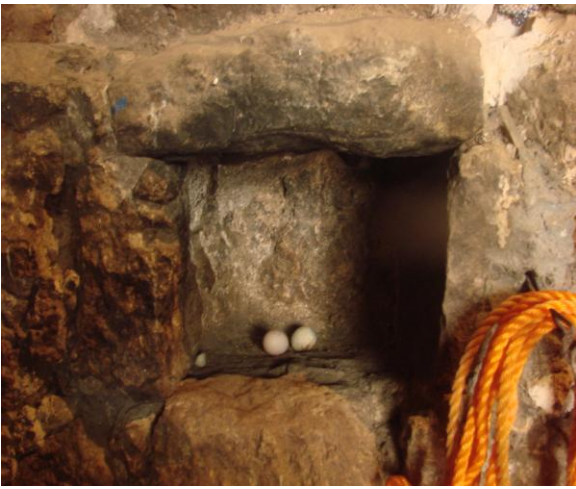
Zemin kat duvarındaki niŐ ve duvardaki bozulmalar
