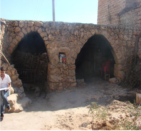
Avlu girişinin üstünü kapatan kemerler
