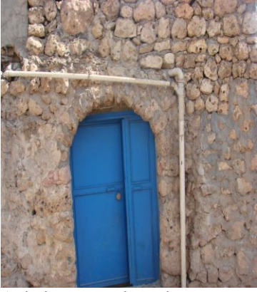
Avlu kapısının dıŐarından g r nt m 
