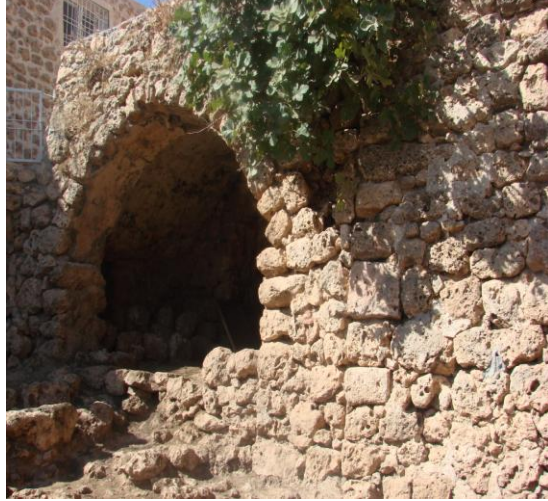
Giriş kısmındaki kemer ve avlu duvarı
