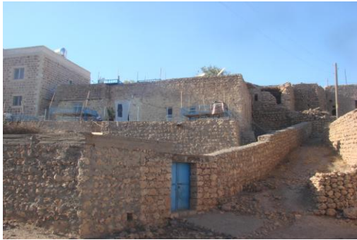
Fotoğraf 4.48. Bir evin sokak cephesi (Sami AKGÜL Evi)
