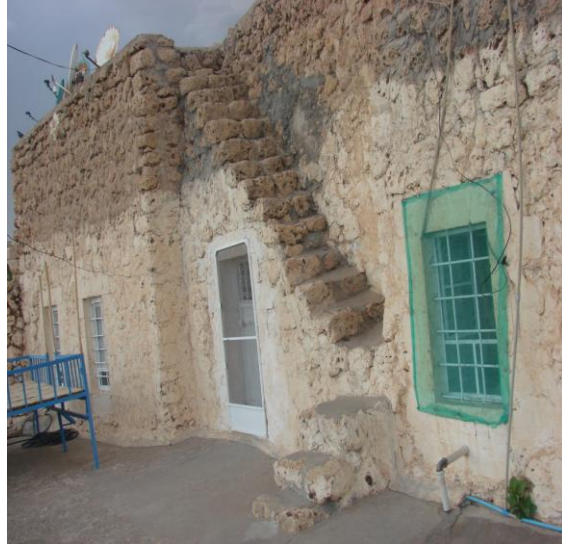
Yapının üst katı ve dama çıkışı sağlayan merdiven
