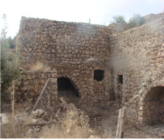
Yapının kapatılan kapı-pencere boşlukları
