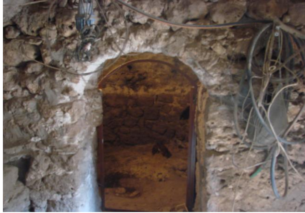
Zemin katta hayvan barınağı olarak kullanılan bölümler
