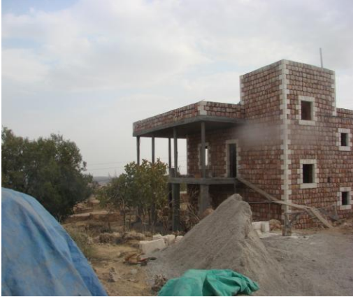
Fotoğraf Ek 12. Henüz inşaat halindeki bir yapı
