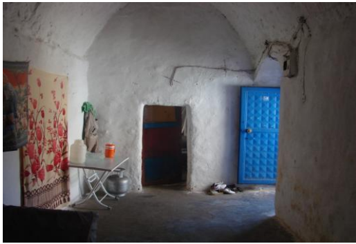
Yapının üst katındaki kapalı eyvan
