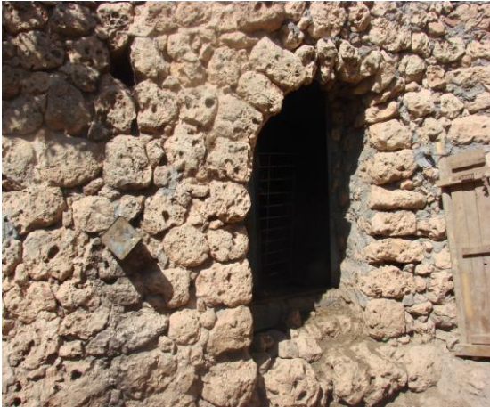
Hayvan barınağı olarak kull. zemin kat giriş kapısı
