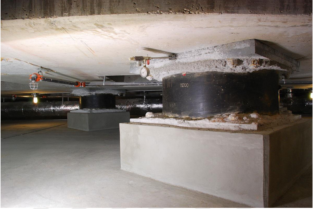
Şekil 1.4 : Yapı temeline yerleştirilen sismik izolatör örneği (pbs.org, Temmuz 2018)
