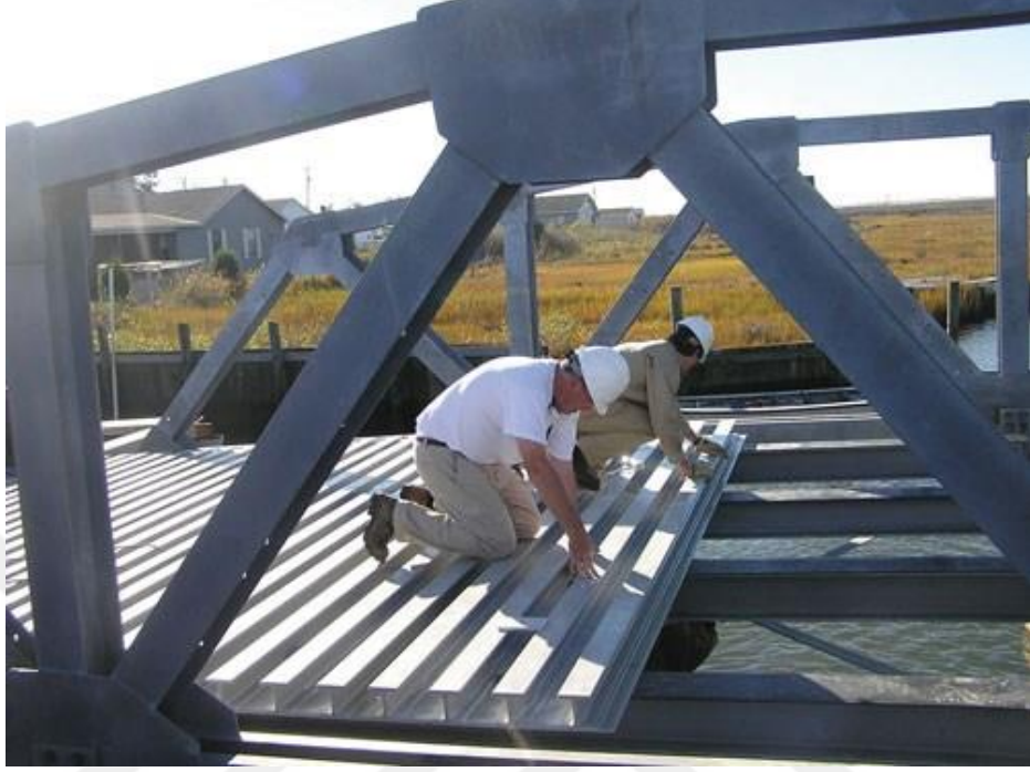
Şekil 1.2 : FRP döşemesi yapılan köprü örneği (compositesworld.com, Haziran 2018)
