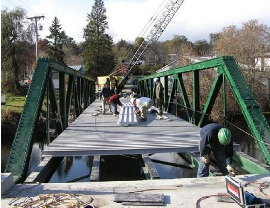
Şekil 1.3 : FRP döşemesi yapılan köprü örneği (compositesworld.com, Haziran 2018)
