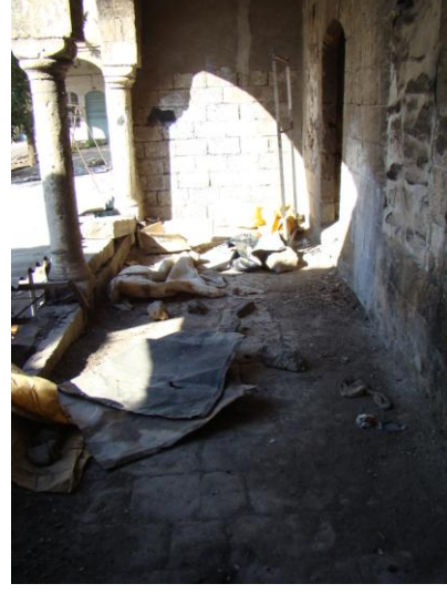
Resim 4.56. Birinci Kat Revak
