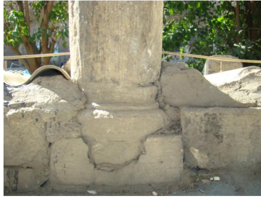
Resim 4.54. Birinci Kat Revak
