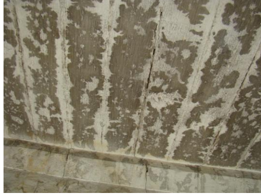
Resim 4.60. Birinci Kat Revak
