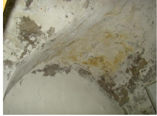
Resim 4.70. Kuzey Cephe Dükkan
