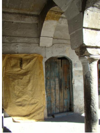
Resim 4.40. Birinci Kat Revak
