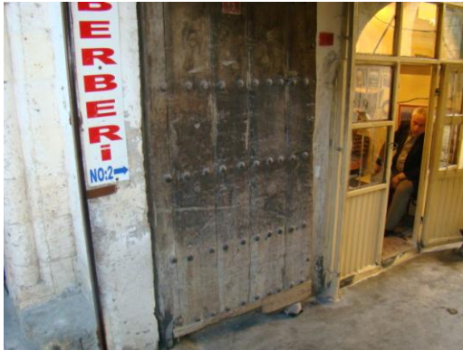
Resim 4.13. Barutçu Hanı Kapı Detayı
