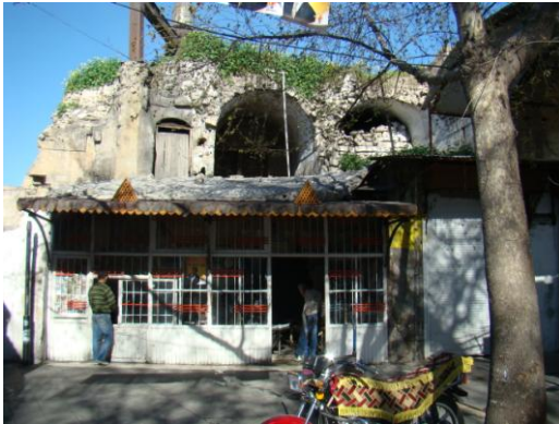
Resim 4.27. Güney doğu köşesi
