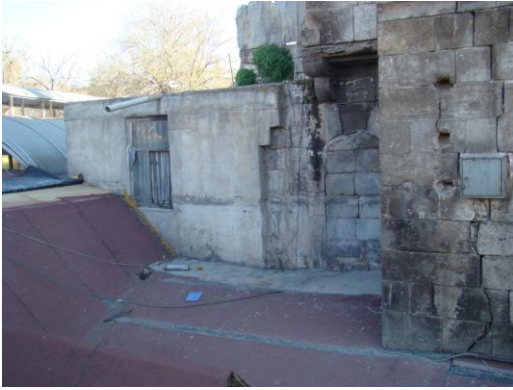
Resim 4.53. Kuzey Cephe Merdiven Boşluğu
