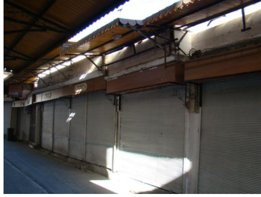
Resim 4.8. Barutçu Hanı Güney Cephesi
