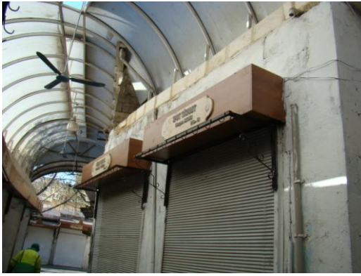
Resim 4.41. Doğu Cephesi Sokak Saçak
