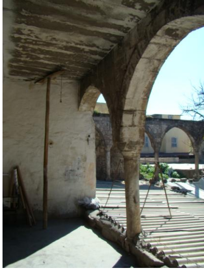
Resim 4.55. Birinci kat revak
