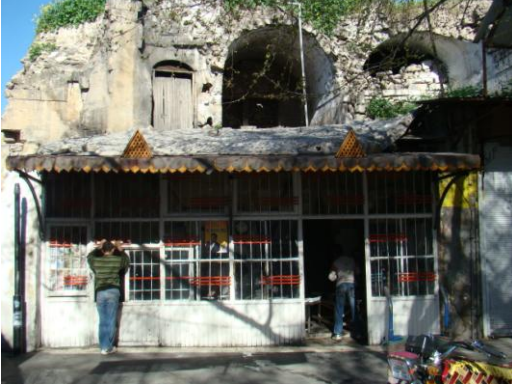
Resim 4.7. Barutçu Hanı Güneydoğu Köşesi
