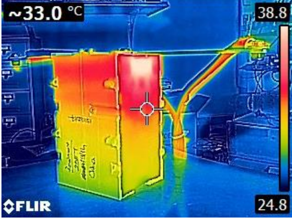
Şekil 4.17 : Kaplama sonrası termal kamera ile sıcaklık ölçüm sonuçları.
