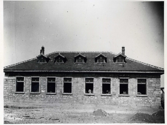
Dicle K y Enstit s  binası
