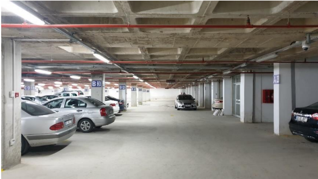
Şekil 3.12 : Kapalı otoparkın yağmurlama sistemi.
