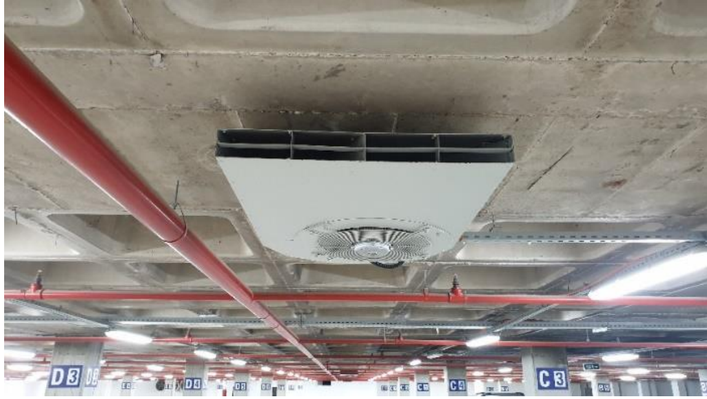
Şekil 3.3 : AIR CI 50-4/8T-F-300 model radyal jet fanın ön görünüşü.
