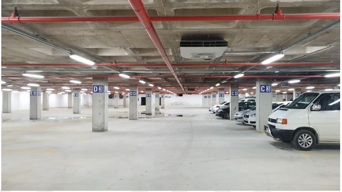
Şekil 3.2 : Örnek bir kurum binası kapalı otoparkı ve radyal jet fanı.
