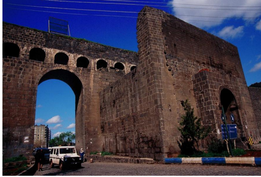
a.Urfa Kapısı (Diyarbakır Büyükşehir Bel. Fot. Arv. 2005)
