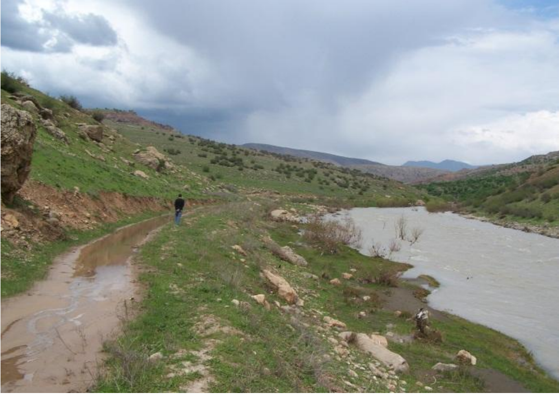
Foto 3. Kezer regülatörü ve HES iletim kanalı başlangıç yeri görünütüsü (Foto : M.Eminođlu 2012)
