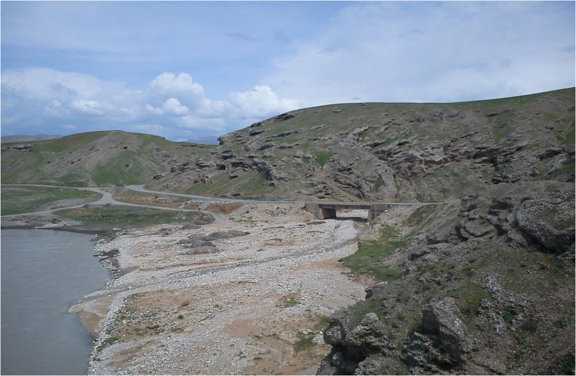
Foto 8. Kezer regülatörü ve HES iletim kanalı güzergahı sonu , yükleme havuzu, cebri boru ve santral yeri (Foto : M.Eminođlu, 2012)
