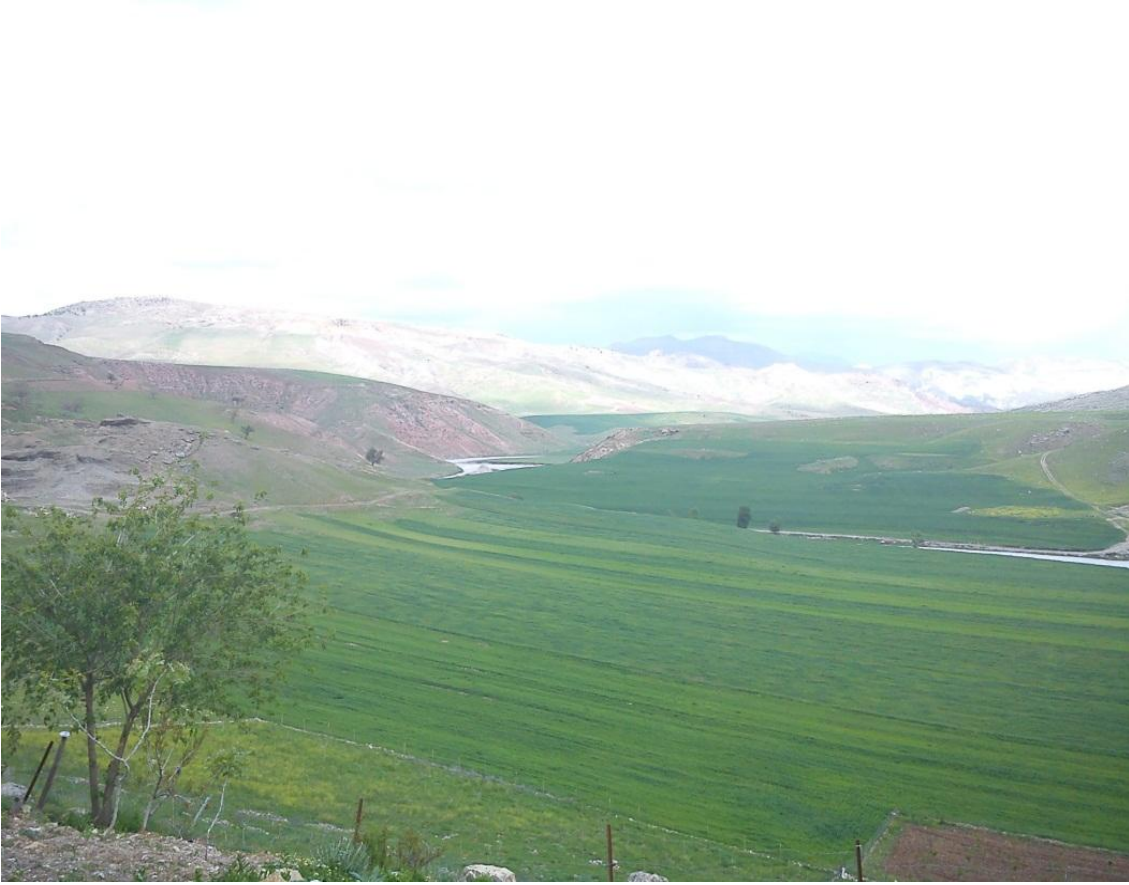
Foto 5. Kezer regülatörü ve HES iletim kanalı güzergahı devamı (Foto : M.Eminođlu, 2012)
