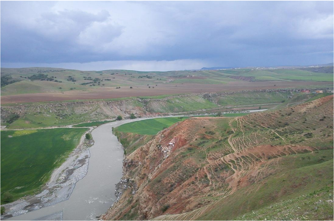
Foto 6. Kezer regülatörü ve HES iletim kanalı güzergahı devamı (Foto : M.Eminođlu, 2012)
