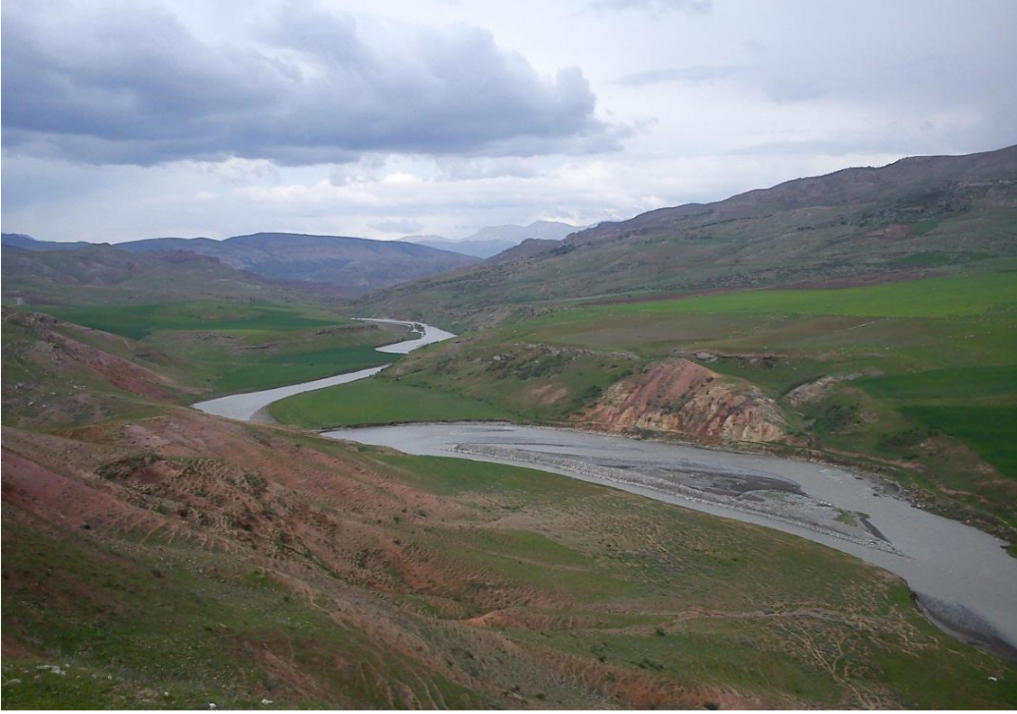
Foto 7. Kezer regülatörü ve HES iletim kanalı güzergahı devamı (Foto : M.Eminođlu, 2012)
