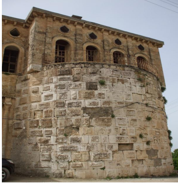
Resim 1: Yüksek yerlere yapılan evlere bir örnek
