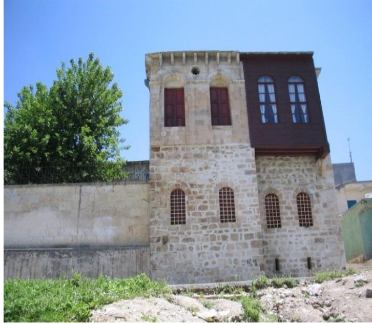
Resim 22: Silvan'daki Atatürk evi, onarımdan sonra ziyaretçilere açık durumdadır
