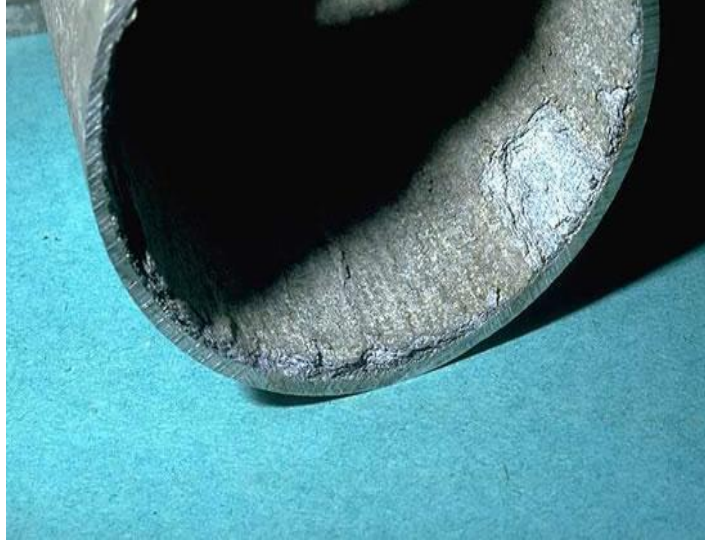
Şekil 1.9 : Taneler arası korozyon örneği [8].
