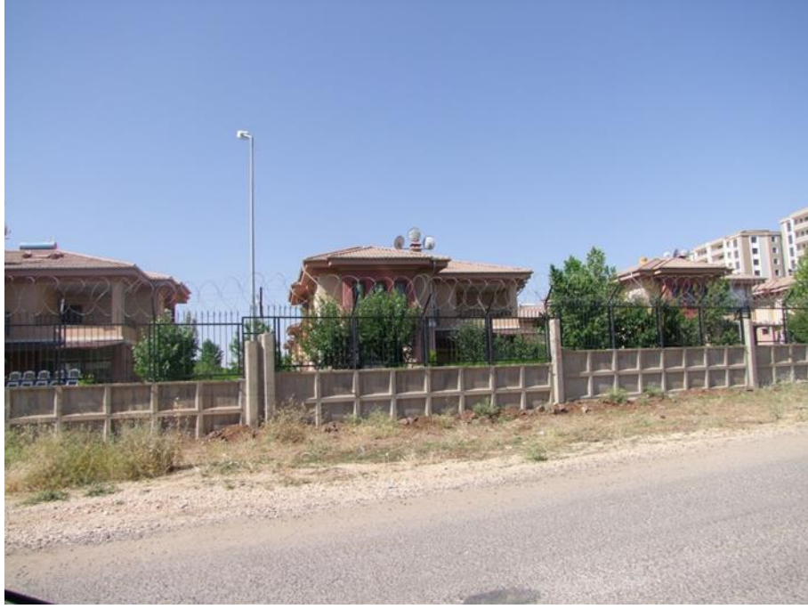
Şekil 3.35. Gökkuşuğu yerleşmesi sınır duvarları
