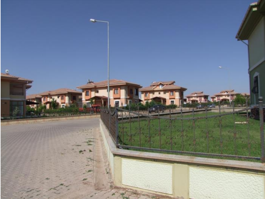
Şekil 3.34. Gökkuşuğu yerleşmesi görünüş
