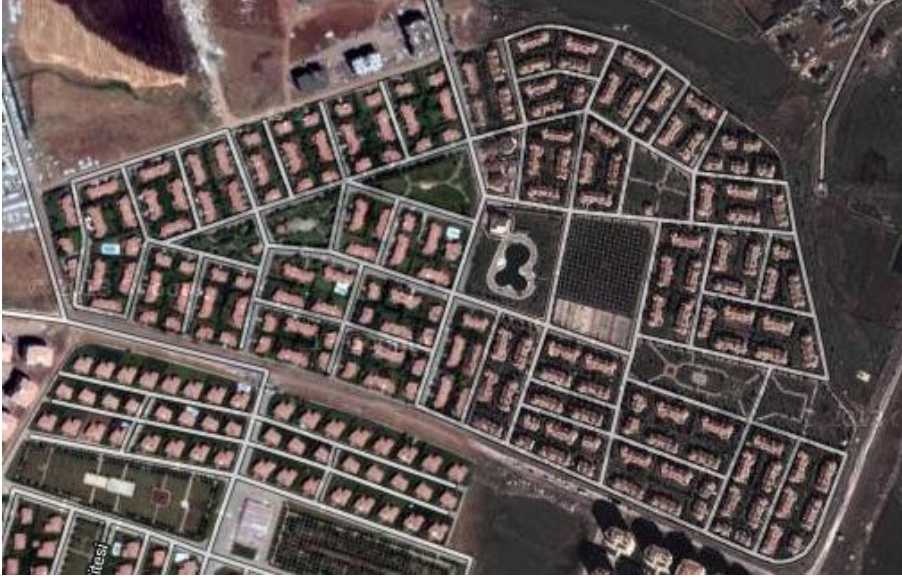
Şekil 3.2. Hamravat yerleşme alanı
