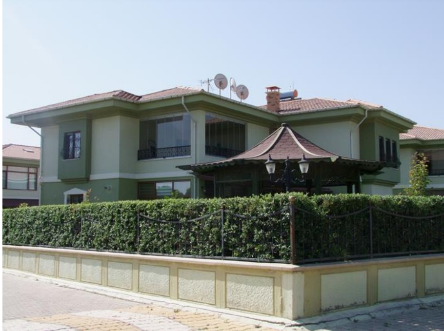
Şekil 3.28. Gökkuşığı yerleşmesi konut dokusu
