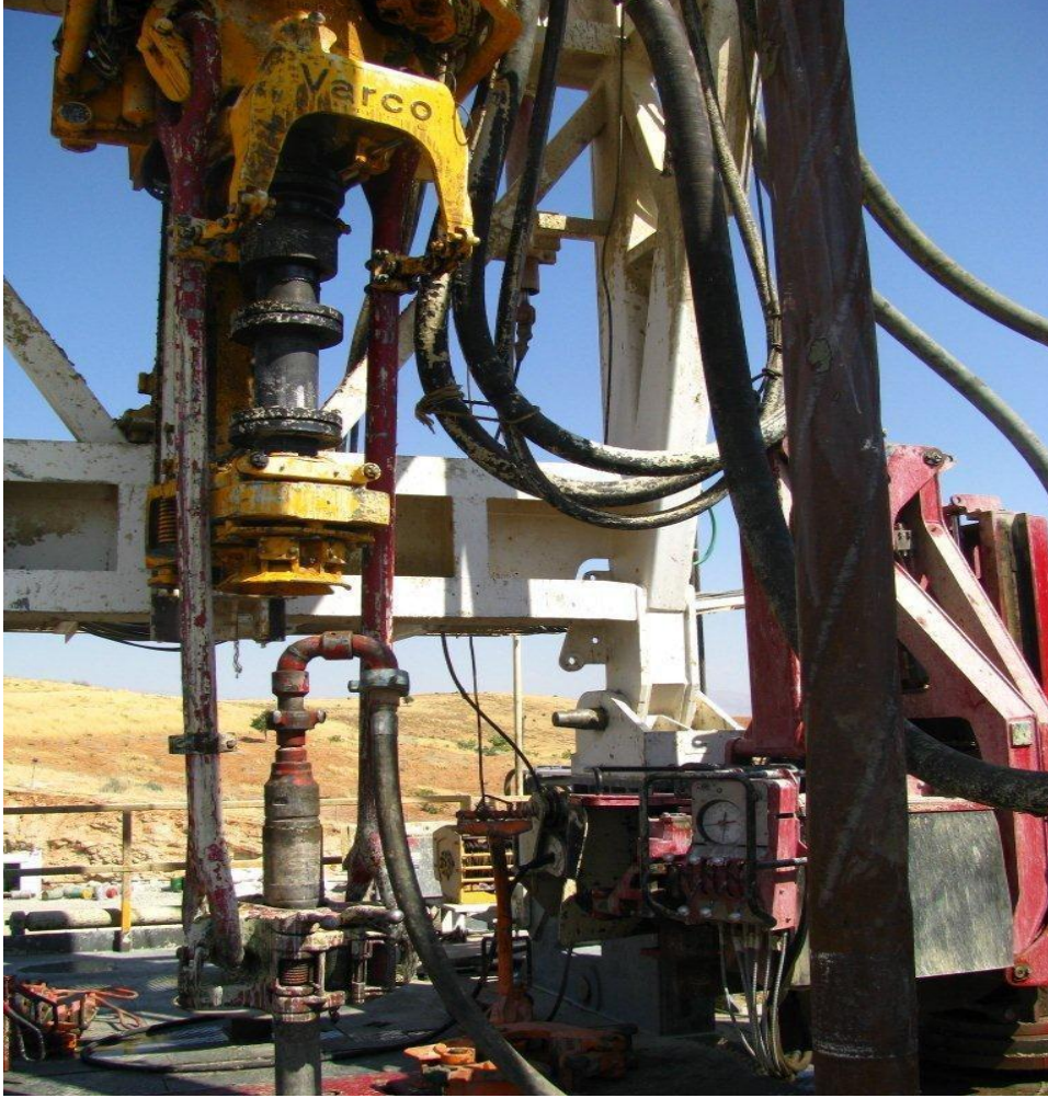
Şekil 3.9. Tapu çimentolaması sırasında çimento hattının sondaj dizisine bağlanması
