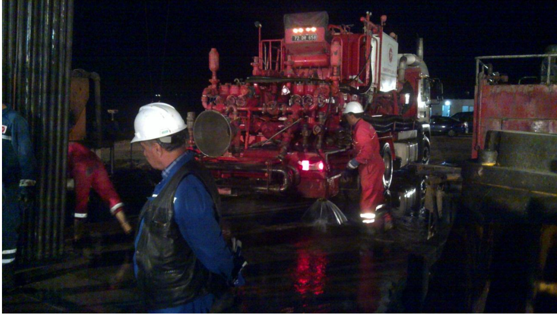
Şekil 3.8. Tapa çimentolaması sırasında unite ve ekipman yerleşimi
