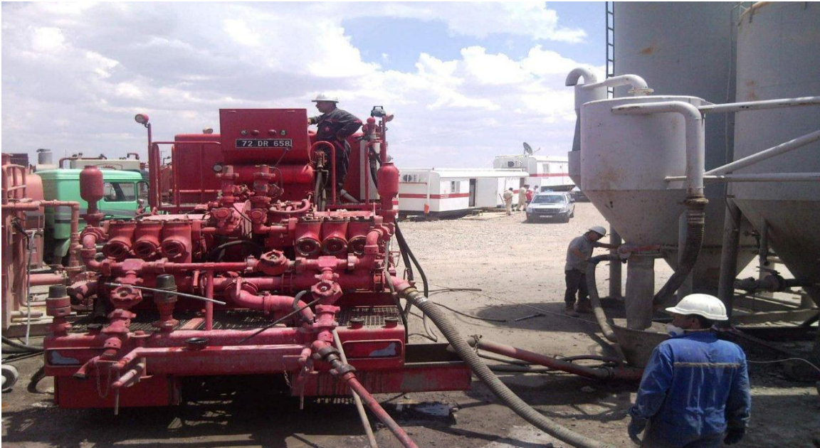
Şekil 4.6. Çimentolama operasyonu sırasında çimento silosundan çimento alımı
