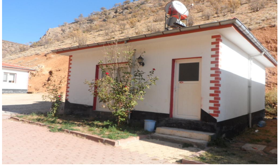
Şekil 4.32 Golan termal tesis konaklama birimi çatısındaki güneş pili
