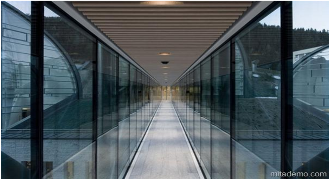
Şekil 2.152 Otelden termal tesise kapalı geçiş (www.mitademo.com)
