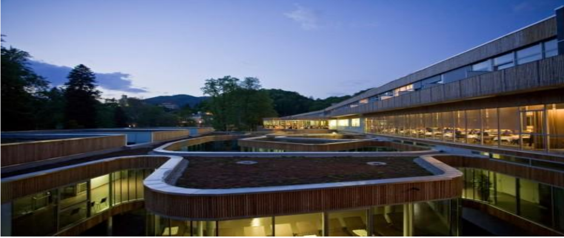
Şekil 2.139 Tesis yeşil çatı uygulaması (www.archdaily.com)
