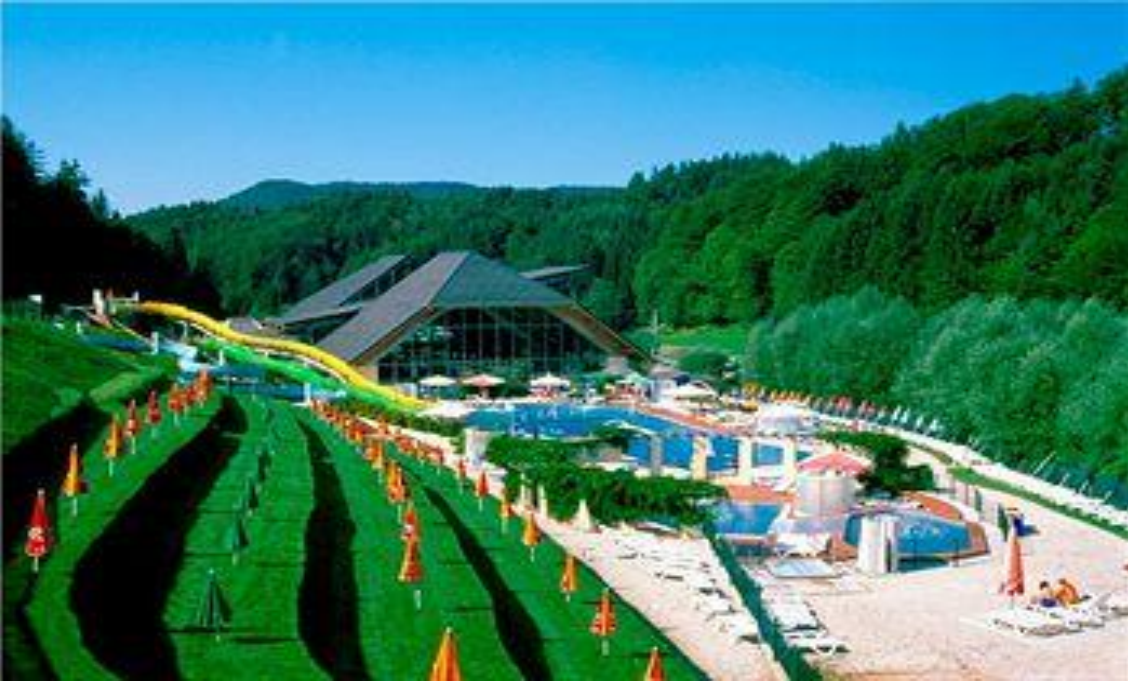
Şekil 2.99 Tesisin termal birimleri dış görünüşü ( www.web.rra.mura.com )
