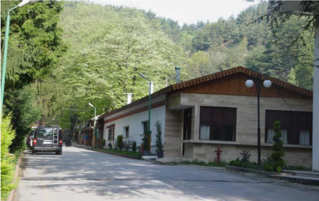
Şekil 2.122 Tesisin dış görünüşü (Başođlan 2010)
