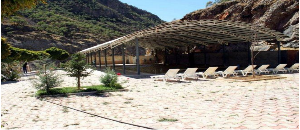
Şekil 4.10. Bağın termal tesisinden bir görünüm
