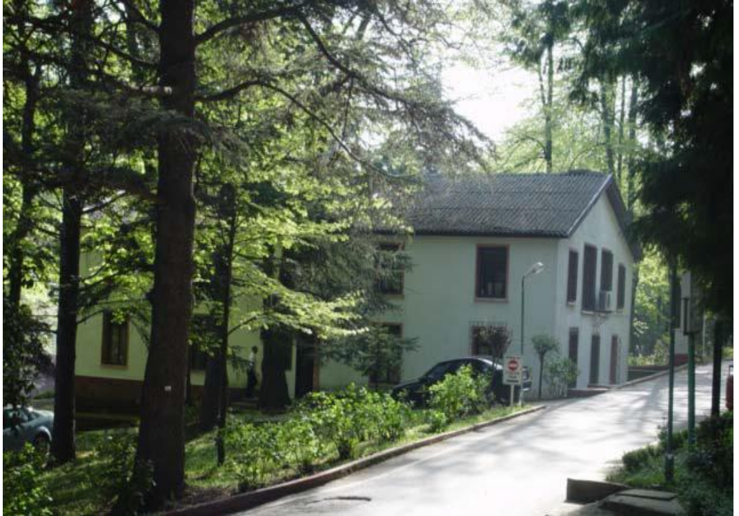
Şekil 2.124 Taş otel dış görünüşü (Başoğlan 2010)
