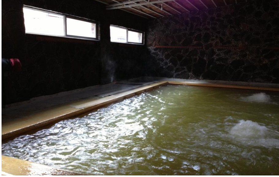
Şekil 4.57 Bağın sıcak su havuzu duvarlarında bulunan pencereler
