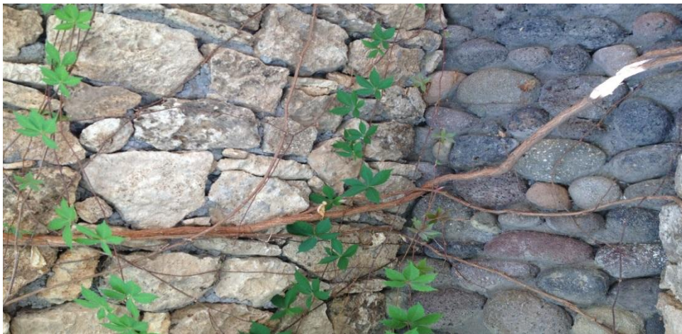
Şekil 4.71 Bin-Kap kür birimi dış cephesi taş kullanımı
