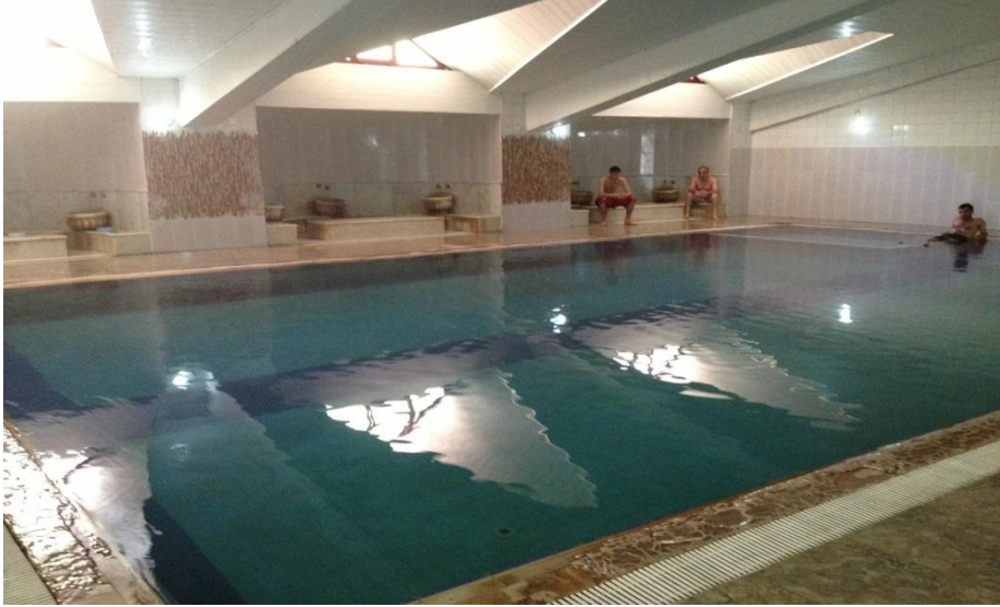
Şekil 4.51 Bin-Kap termal tesisleri sıcak su havuzları
