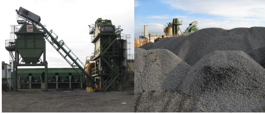
Şekil 2.2 Konkasör şantiyesi ve kırılmış bazalt agregası
