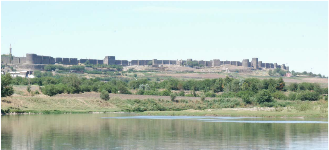
Şekil 2.19. Dicle Vadisinden görünüş Dış Kale
