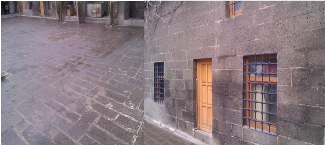
Şekil 2.13 Gözenekli duvar kaplaması ve zemin döşemesi
