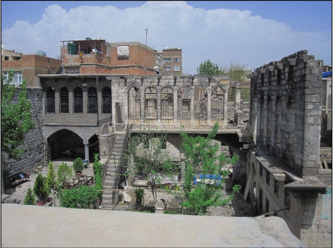
Şekil 8. 58. Konut bölümü kuzey kanat görünüşü
