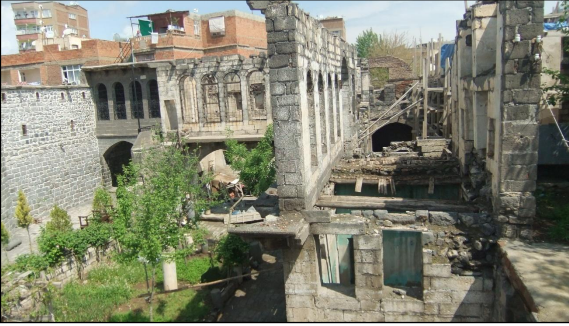
Şekil 8. 63. Konut bölümü genel görünüşü
