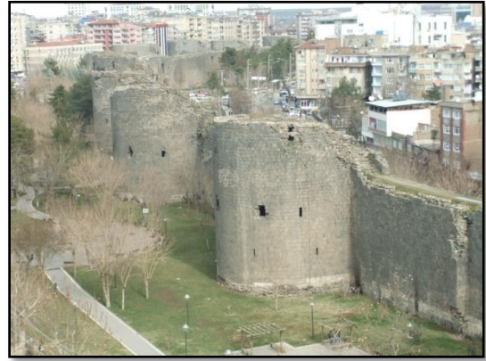
Şekil 3. 2. Diyarbakir Surlari'ndan görünüm (2012)
