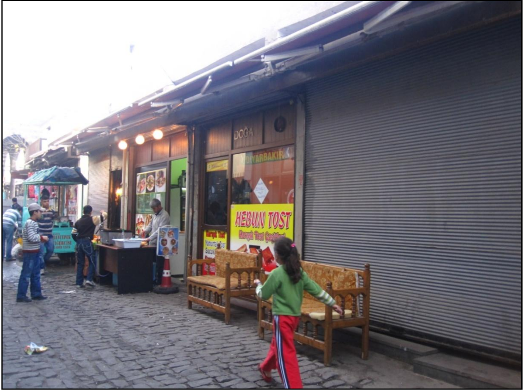
Şekil 8. 43. Yapının Yeni Kapı Sokak'tan görünümü
