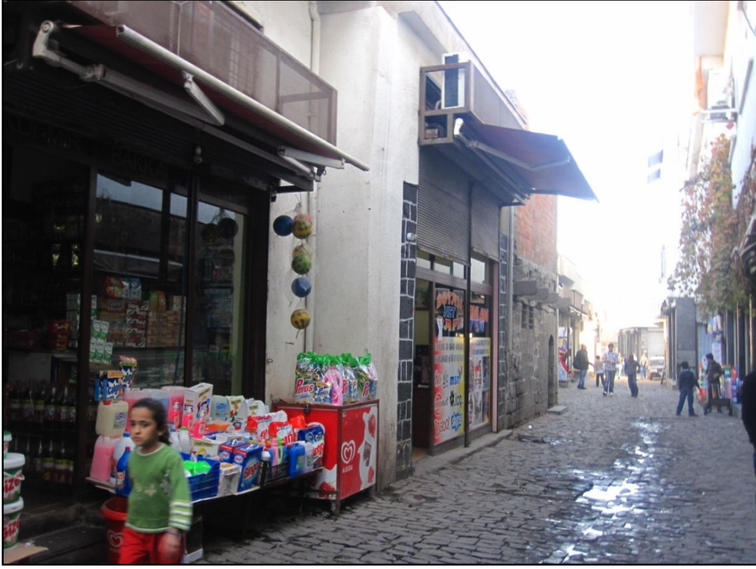
Şekil 8. 44. Yapının Yeni Kapı Sokak'tan görünümü
