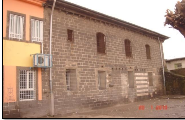
Şekil 3. 19. Kilise Kuzey Cephesi (2012)
