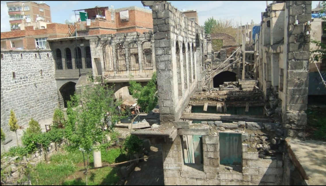
Şekil 8. 60. Konut bölümü doğu kanat iç görünüşü
