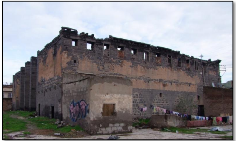
Şekil 3. 13. Yapının kuzey batı cephesi (2010)
