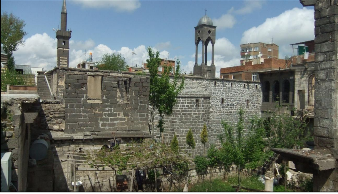
Şekil 8. 55. Kilise doğu cephesi
