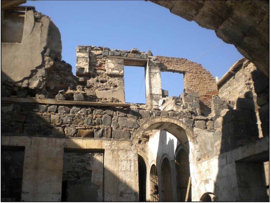
Şekil 5. 4. Kerpiç malzemenin kaybı (2012)
