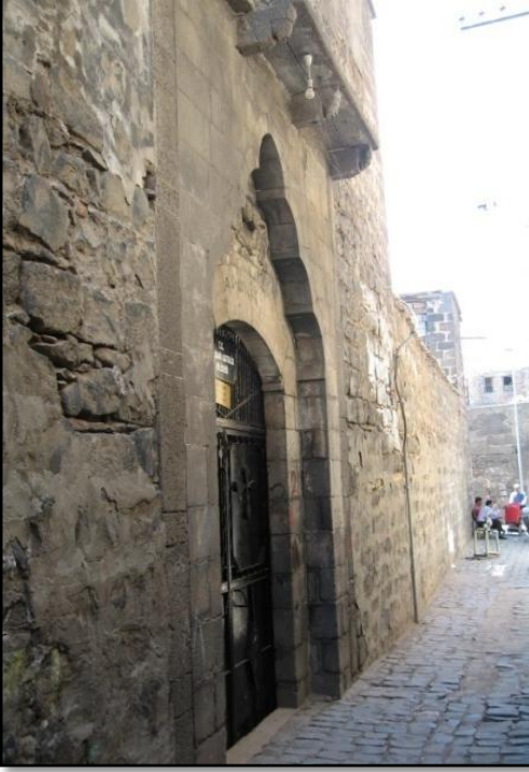
Şekil 4. 4. Kuzey giriş kapısı
