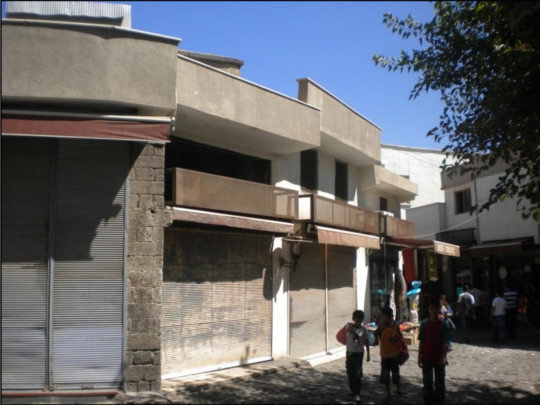
Şekil 8. 41. Yapının Yeni Kapı Sokak'tan görünümü
