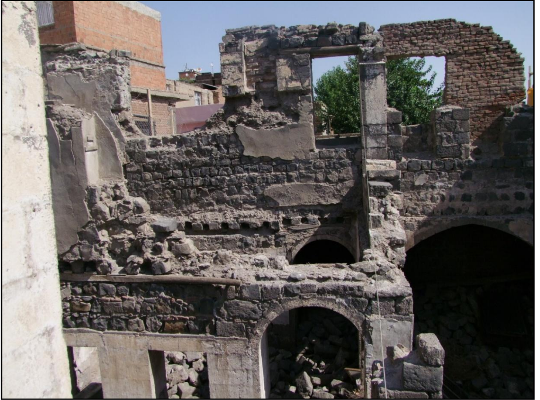
Şekil 8. 66. Konut bölümü üstten doğu kanat iç mekan görünüşü
