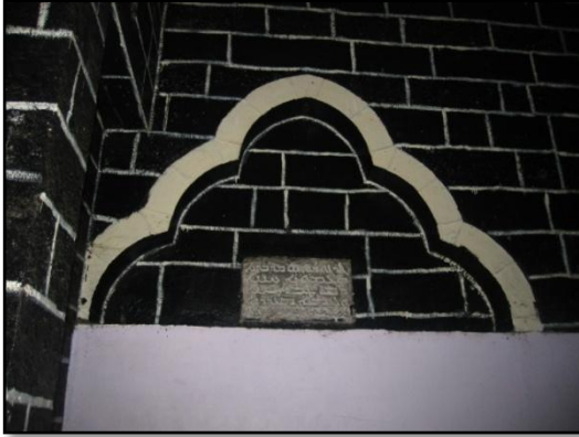
Şekil 4. 6. Dükkan içinde kalan beş dilimli kemerli kapı
