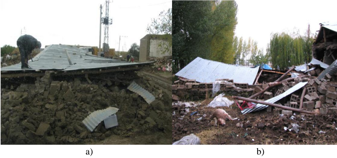
Şekil 3.12. a, b) Van-Merkez Alaköy’de yıkılan yığma yapılar [2]
