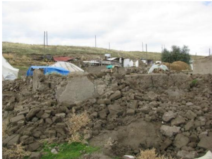
Şekil 3.8. Dibekdüzü Köyü'nde yıkılmış bir yapı [2]
