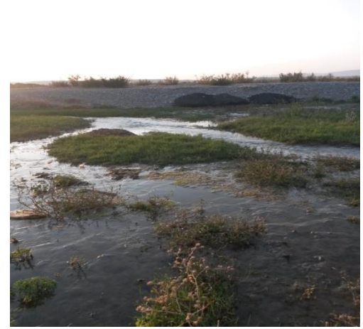
Resim 102: Alan Saha Araştırması (İluh Barajı)
