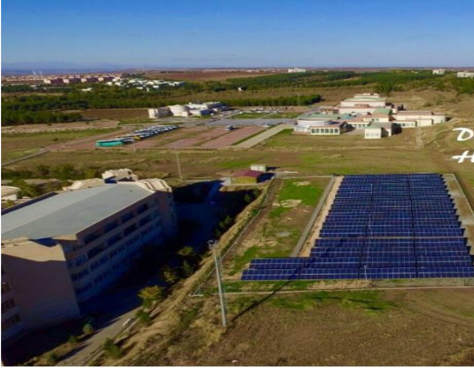
Şekil 1.15. Dicle Üniversitesi Güneş Enerji Santrali
