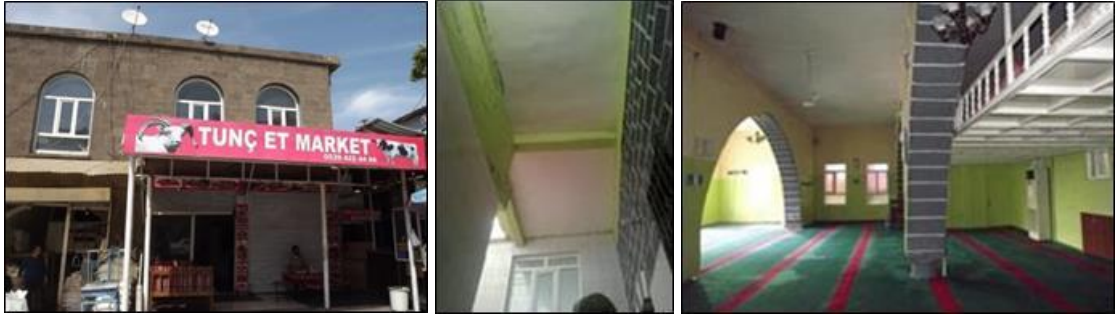
Şekil 4.48. Sin Camideki ara kat ve üst döşemenin betonarme ile kapatılması
