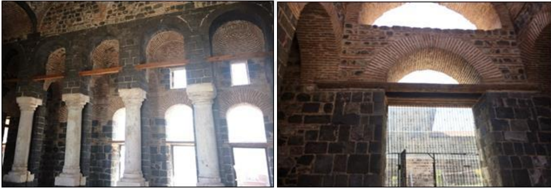
Şekil 3.90. Ahşap gergi çubuk ve hatılların değiştirildiği güçlendirme uygulaması
