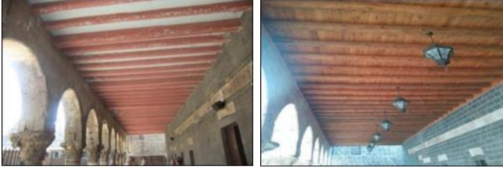
Şekil 4.111.Mesudiye Medresesi revak üst örtüsünün restorasyon öncesi ve sonraki durumu
