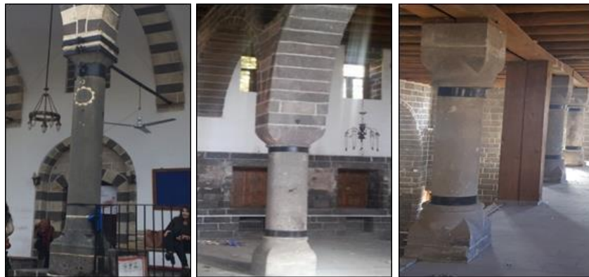
Şekil 3.82. Sütunlarda kullanılan metal gergi bilezikleri
