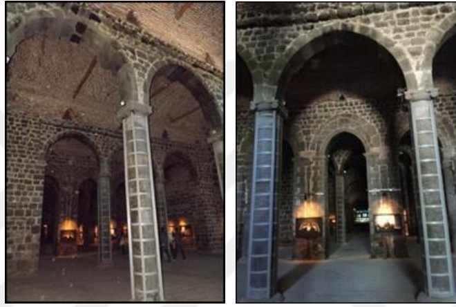
Şekil 4.249. Keçi burcunda sütunlarda metal kenetlerle yapılan güçlendirme uygulaması
