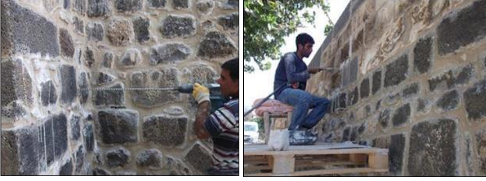
Şekil 3.69. Taşıyıcı duvarlarda delik açılarak yapılan enjeksiyon uygulaması
