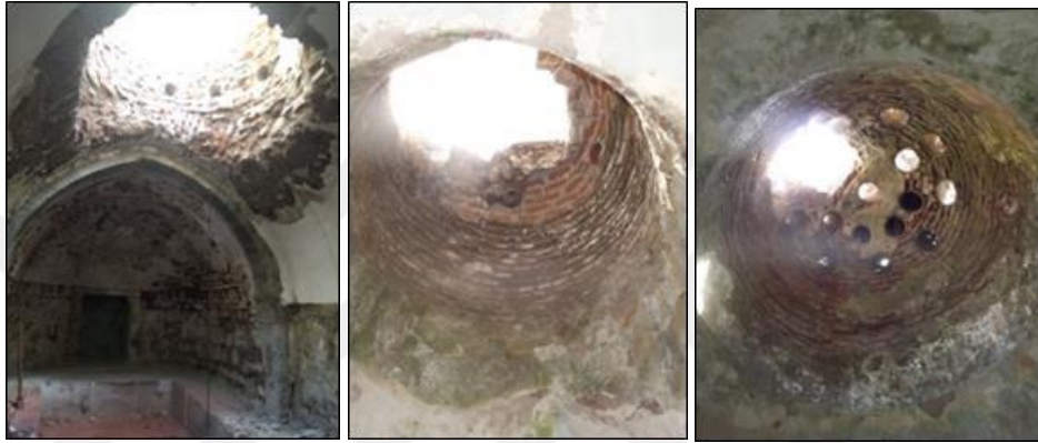
Şekil 4.81. Çardaklı ve Deva Hamamı ılıkılık bölümlerinde fil gözlerindeki malzeme kayıpları
