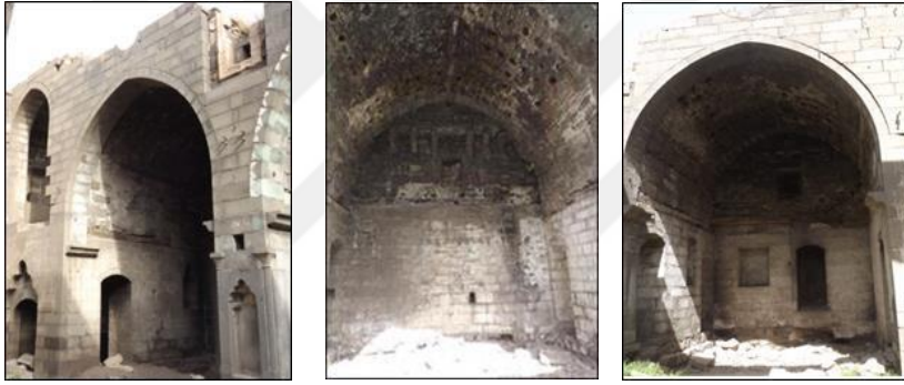
Şekil 4.267. Surp Sargis Kilisesi apsislerinde aşınma ve malzeme kayıpları (Ekim 2017)
