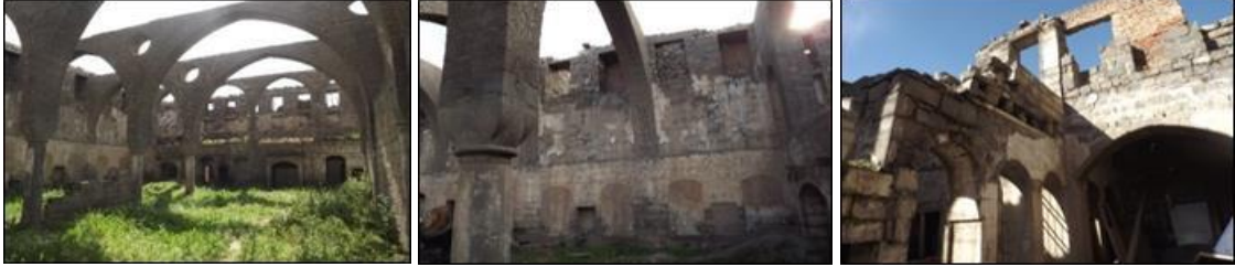
Şekil 4.36. Surp Sargis Kilisesi ile Mar Petyum Kilisesinde doğa koşulları ve yapı elemanı kaybına bağlı oluşan hasarlar
