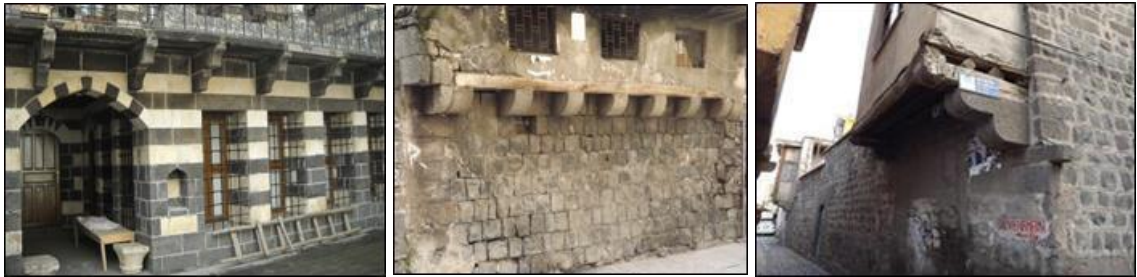
Şekil 3.4. Geleneksel yığma yapılarda kullanılan bingi taşı örnekleri
