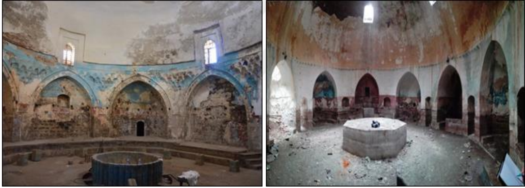
Şekil 4.328.Deva Hamamı soğukluk ve sıcaklık bölümlerindeki kemer ve tonozlar
