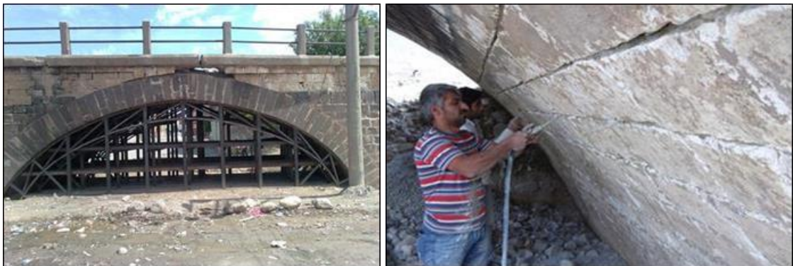
Şekil 3.84. Askıya alınan kemerlerde enjeksiyon uygulaması
