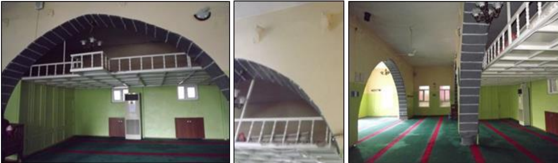
Şekil 4.50. Sin Camideki düşey taşıyıcı elemanı bulunmayan ve sonradan eklenen kadınlar mahfili
