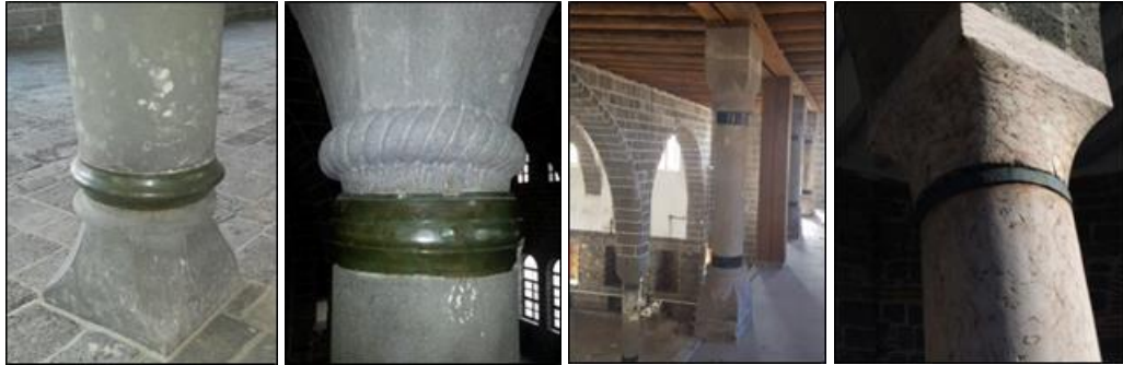
Şekil 3.18. Sütunlarda kullanılan metal bilezik örnekleri
