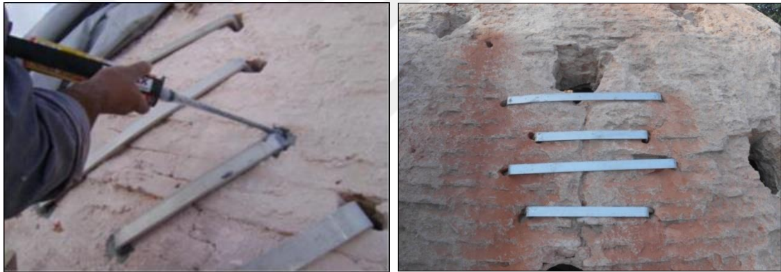
Şekil 3.88. Kubbedeki çatlakların çelik çubuklarla dikilmesi (VBM Arşivi 2015)
