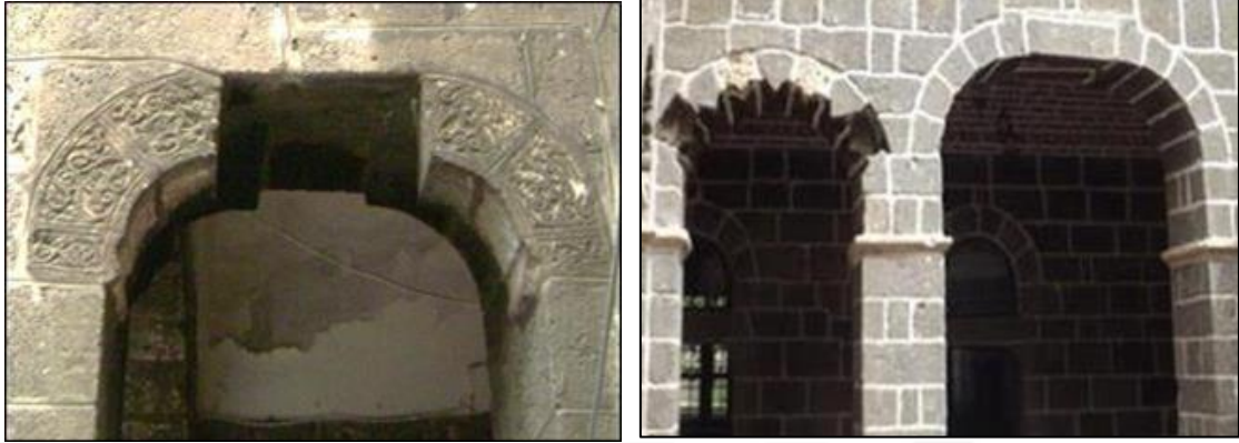
Şekil 4.121. Zinciriye Medresesinde kemerlerdeki kilit ve üzengi taşı kayıpları
