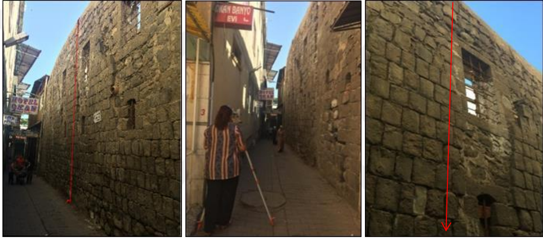
Şekil 4.206.Çifte Han Arman Sokak cephesinde teodolit cihazı ile aks kayması tespit ölçümleri
