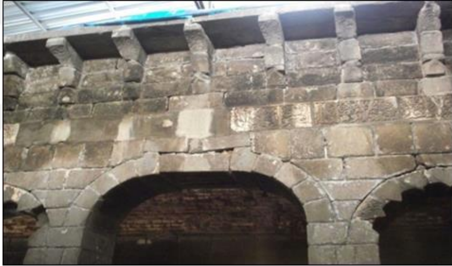
Şekil 4.104. Zinciriye Medresesinde eyvan ayrışma ve kemerdeki kayma hasarı
