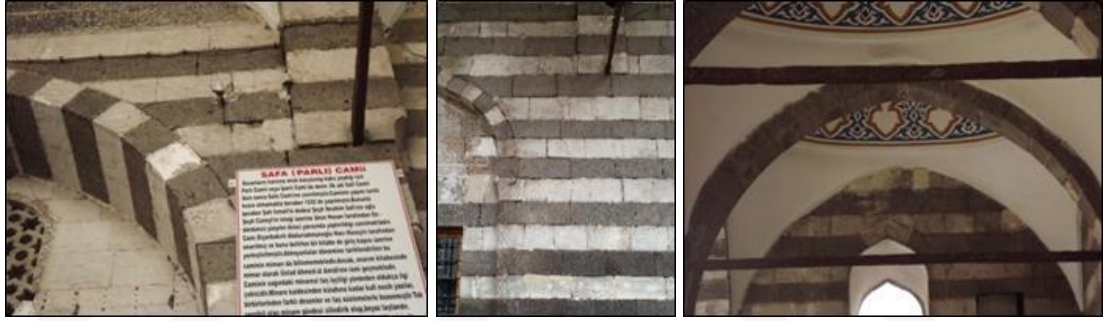
Şekil 4.40. Parlı Safa Camideki gergi çubuklarına bağlı oluşan duvar ve kemerlerde ayrışma hasarları
