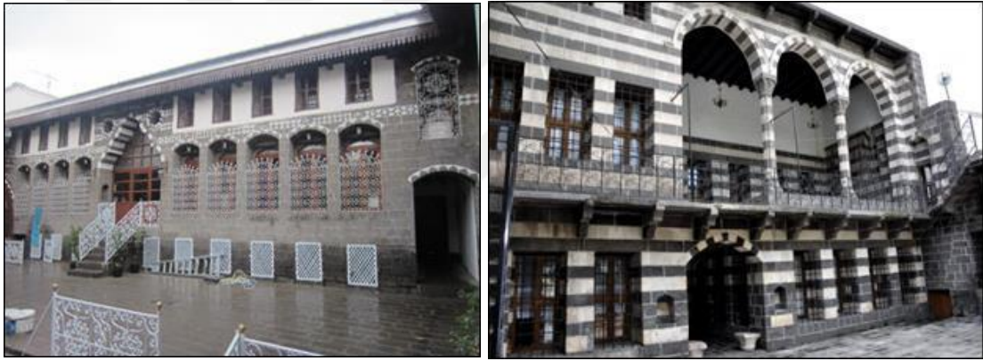
Şekil 4.125. Geleneksel Diyarbakır evleri (Cahit Sıtkı Tarancı Evi ve Behram Paşa Konağı)
