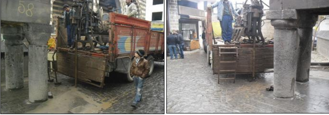
Şekil 4.241. Dört Ayaklı Minarenin zemin tespitinde yapılan sondaj uygulaması(VBM Arşivi)
