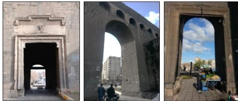
Şekil 4.254. Urfa Kapı sur duvarındaki kuzey, kemerli orta ve güney kapı geçişlerinin sur dışı görünümü
