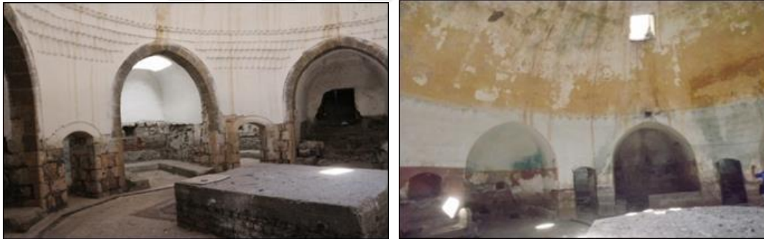
Şekil 4.80. Çardaklı ve Deva Hamamı'ndaki sıvanan kemer ve örgü elemanları
