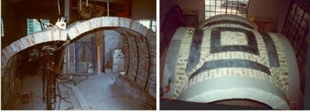
Şekil 3.85. Kemer ve tonozlarda FRP malzemelerle güçlendirilme çalışması (Delta yapı)
