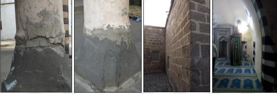
Şekil 4.45. İskender Paşa ve Ali Paşa Camilerinin sütunlarındaki aks kayması hasarları ve Hoca Ahmet (Ayn Minare) Cami dış ve iç duvarlarında oluşan kayma hasarları
