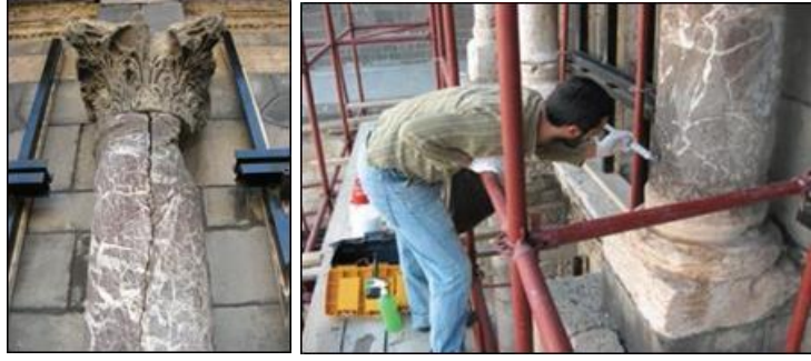
Şekil 4. 246. Ulu Cami'deki sütunlarda kılcal çatlakların enjeksiyon yöntemi ile güçlendirilmesi (Güleç 2007)
