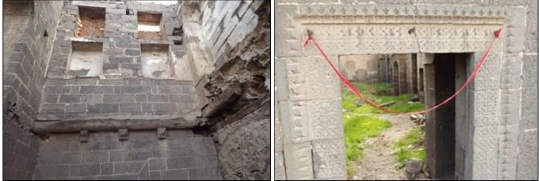
Şekil 4.276. Surp Sargis Kilisesi narteks bölümündeki ahşap hatıl hasarları ile güneybatı giriş lentosundaki çatlak hasarı
