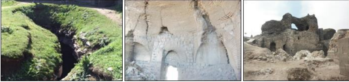
Şekil 4.10. 22-58- 71 numaralı burçların üst örtülerindeki çatlak ve yıkılma hasarları
