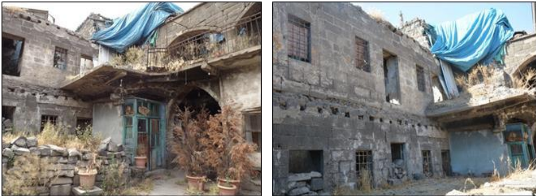
Şekil 4.303. Çifte Han batı cephesi
