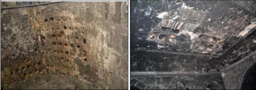
Şekil 4.279. Apsis bölümü ile vaftiz odası tonozlarındaki malzeme kayıpları
