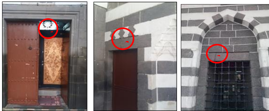
Şekil 4.192.İskender Paşa Cami'de ölçümlerin izlendiği taşıyıcı elemanların konumları (VBM Arşivi 2015)
