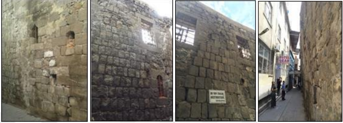
Şekil 4.65.Çifte Han'ın Arman Sokağa bakan doğu cephesi
