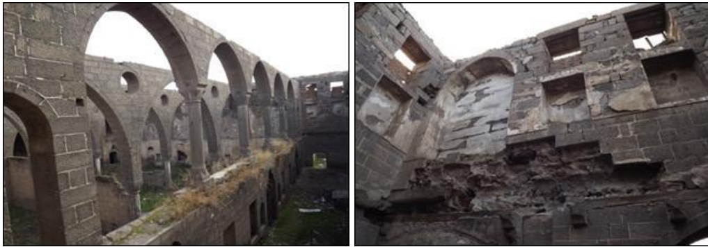
Şekil 4.282. Surp Sargis Kilisesi narteks bölümündeki bitki oluşumları, niteliksiz dolgu ve malzeme kayıpları
