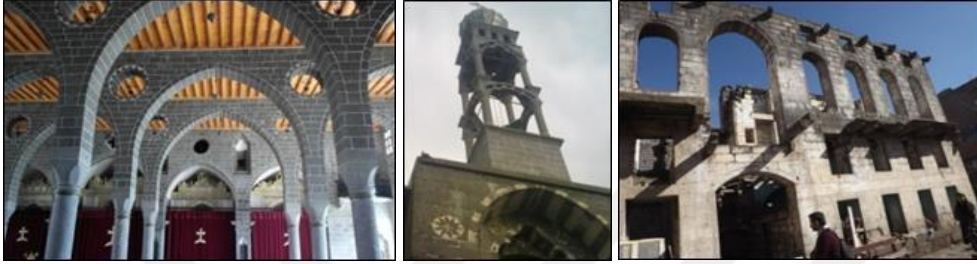
Şekil 4.35.Surp Giragos Kilisesi restorasyon sonrası ibadet alanı çan kulesi ve Mar Petyum Kilisesi Patrikhanesinde doğa koşullarına bağlı oluşan hasarlar
