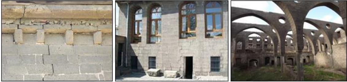
Şekil 4.24.Latin Kilisesi, Meryem Ana Kilisesinde papaz evindeki çatlak ve ayırışma örnekleri ile üst örtüsü tümüyle çöken Surp Sargis Kilisesi
