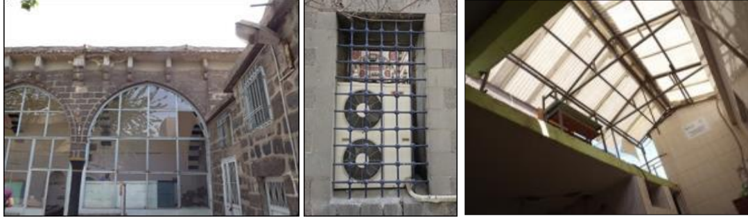
Şekil 4.53. Hoca Ahmet, Nebi ve Sin Camilerinde kullanıcı kaynaklı hatalı uygulamalar
