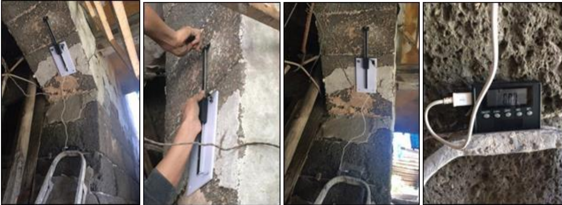
Şekil 4.201. Çifte Han 24 saatlik çatlak değişiminin ölçüldüğü cihazın kemere yerleştirilmesi
