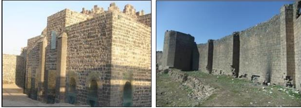
Şekil 3.3. Saint George Kilisesi ve Diyarbakır Surlarındaki payanda örnekleri (2014)
