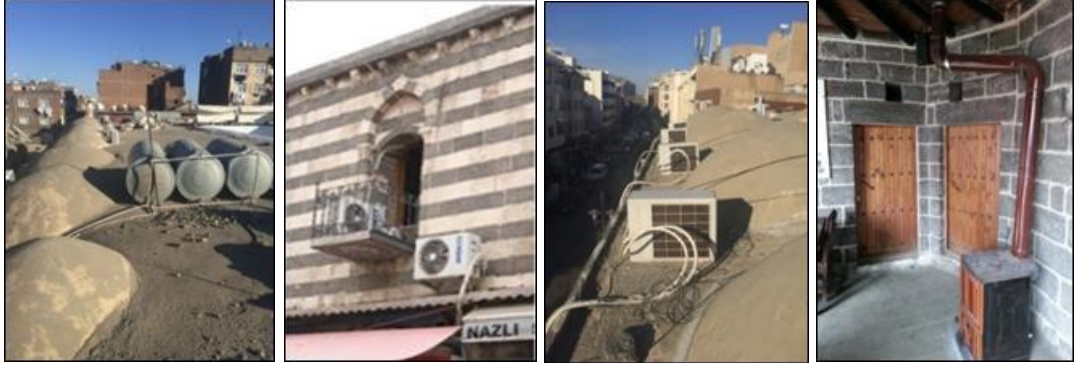
Şekil 4.74. Hasan Paşa ve Sülüklü Han'da kullanıcı kaynaklı aşırı yüklemeye bağlı oluşan ayrışma, çözülme hasarları
