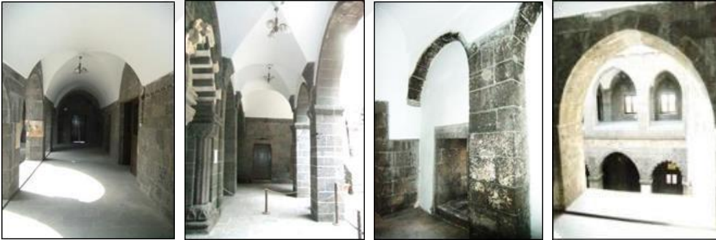
Şekil 4.112.Mesudiye Medresesinde tonozların sıva ve boya ile kapatılması ( VBM Arşivi 2015)
