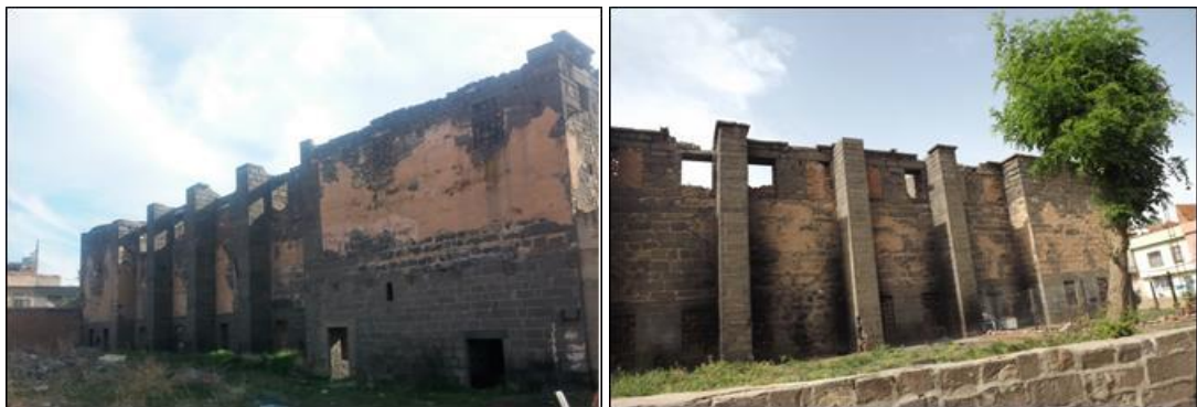
Şekil 4.274. Surp Sargis Kilisesi kuzeybatı ve kuzeydoğu yönünde cephe duvarlarındaki payandalar
