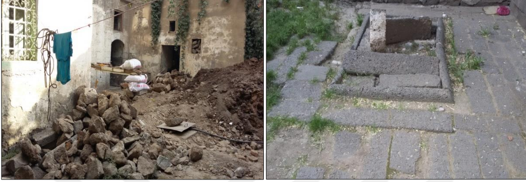
Şekil 4.342. Avlu döşemesinde yapılan kazı nedeniyle oluşan hafriyatlar
