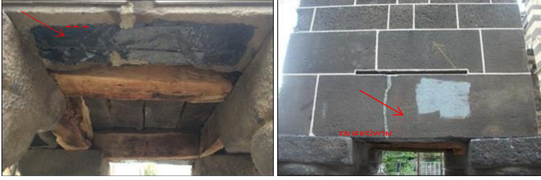
Şekil 3.89. Lento ve hatılarda yapılan enjeksiyon ve FRP ile güçlendirme uygulaması
