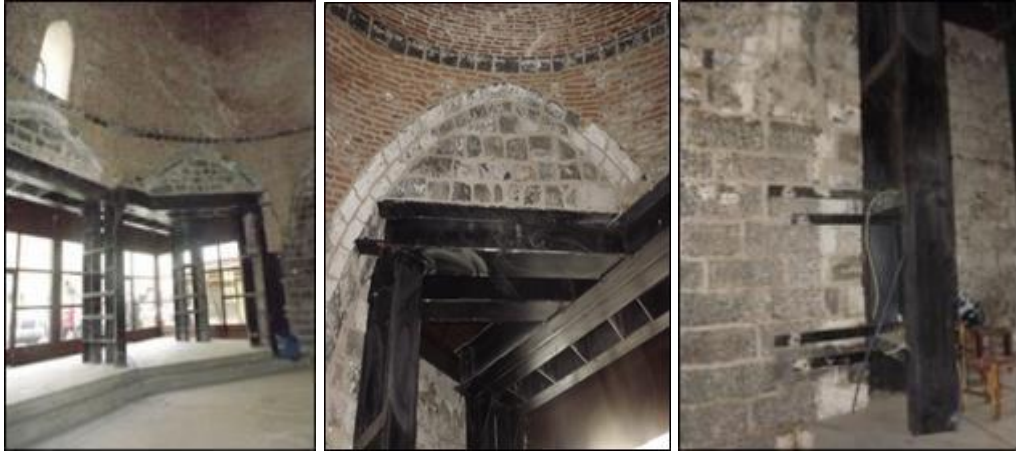
Şekil 4.252. Vahap Ağa Hamamında yapılan güçlendirme uygulaması
