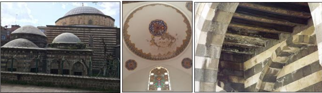
Şekil 4.46. İskender Paşa, Hoca Ahmet ve Şeyh Mutahhar Camilerinde neme bağlı oluşan taşıyıcı sistem hasarları
