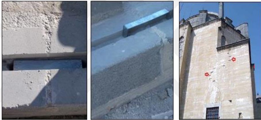
Şekil 3.78. Duvarlarda metal kenetlerle yapılan dikiş örneği (Delta Yapı 2016)
