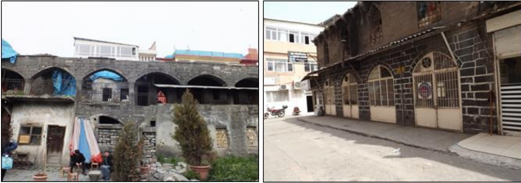
Şekil 4.314.Çifte Han kuzey duvarı iç ve dış yüzeylerindeki metal saçaklar
