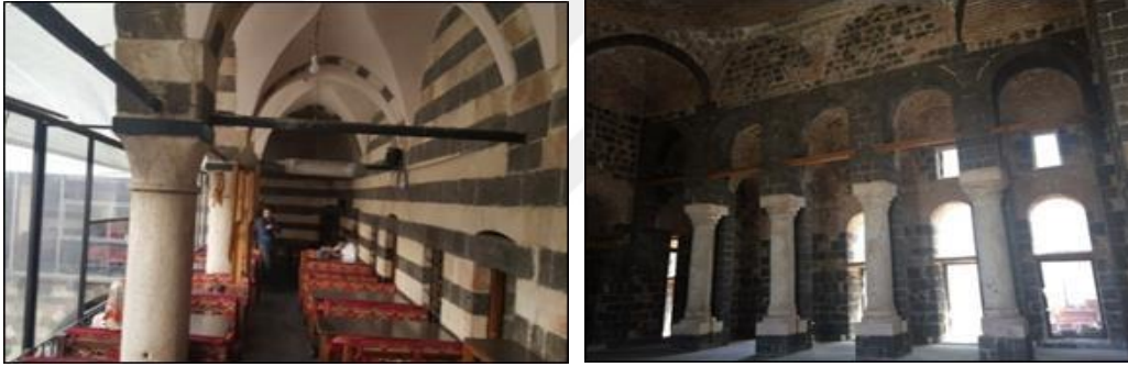
Şekil 3.16. Metal ve ahşap gergi çubukları
