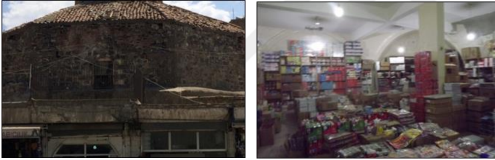
Şekil 4.96. Melik Ahmet Paşa Hamamı yapı eleman kaybıyla duvarda ayrışma ve çatlak hasarları
