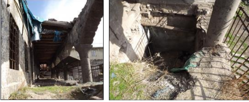
Şekil 4.308. Çifte Han kuzey cephesi birinci katındaki sütunlar
