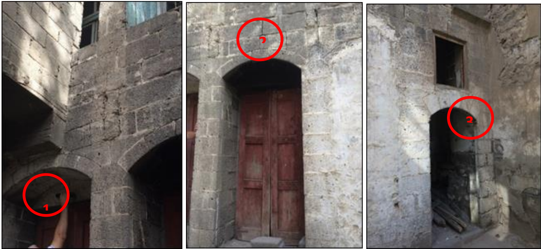
Şekil 4.227. Geleneksel Diyarbakır Evinde ölçüm alınan noktalar
