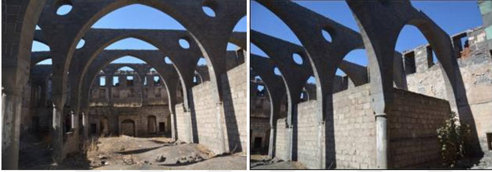
Şekil 4.272. Surp Sargis Kilisesinde sütunlar arasının kapatılması
