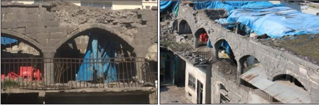
Şekil 3.38. Çifte Han kemerlerinde gergi demirleri ve üst örtünün yok olmasına bağlı oluşan hasarlar
