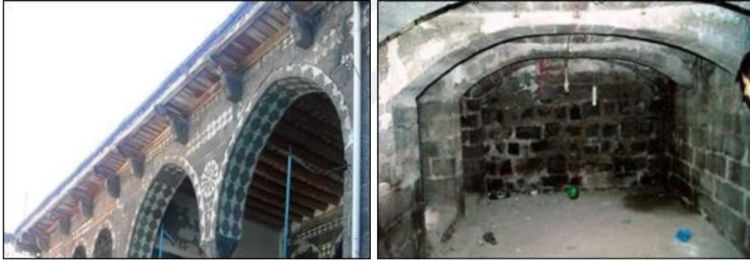
Şekil 4.126. Toprak dam altındaki bingi taşları ile bodrum kattaki taş kemerler
