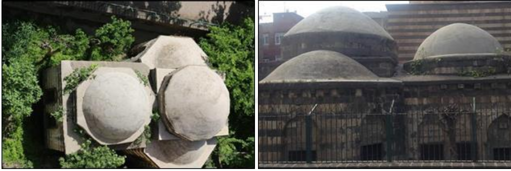
Şekil 4.297.Cami yanındaki türbelerin üst örtüsündeki beton kaplamalar
