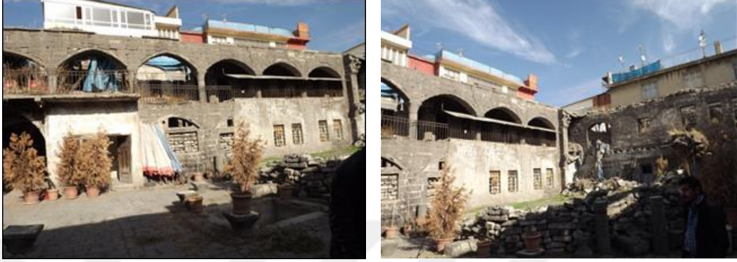
Şekil 4.304. Çifte Han kuzey cephesi zemin katındaki revaklarının doldurulması
