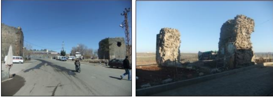
Şekil 4.7. 47'-48, 62-63, numaralı burçlar arasında yok olan sur duvarları
