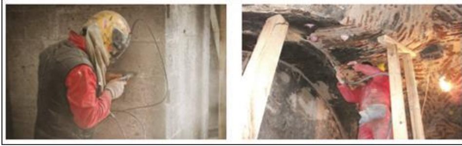
Şekil 4.248. Surp Giragos Kilisesi duvar, tonozlarında enjeksiyonla yapılan güçlendirme uygulaması (Halifeoğlu 2012)
