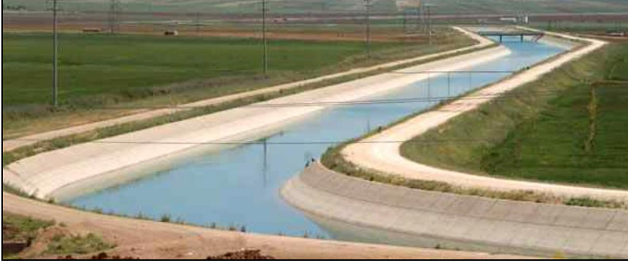
Şekil 3.1. Trapez kesitli açık kanal
