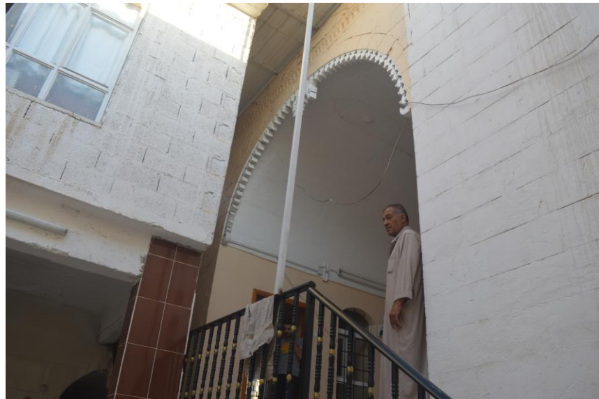
Şekil 4.65. Eyvanın Önüne Eklenen Betonarme Kısım (Melikoğlu 2018)
