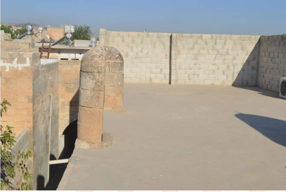
Şekil 4.62. Batı Yönünde Örülen ve Batı Rüzgarını Kesen Parapet Duvarı (Melikoğlu 2018)
