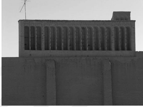
Şekil 2.49. İran'ın Farklı Bölgelerinde Bulunan Tek Yönlü Rüzgâr Yakalayıcı Örnekleri (Bahadori 2014:64)
