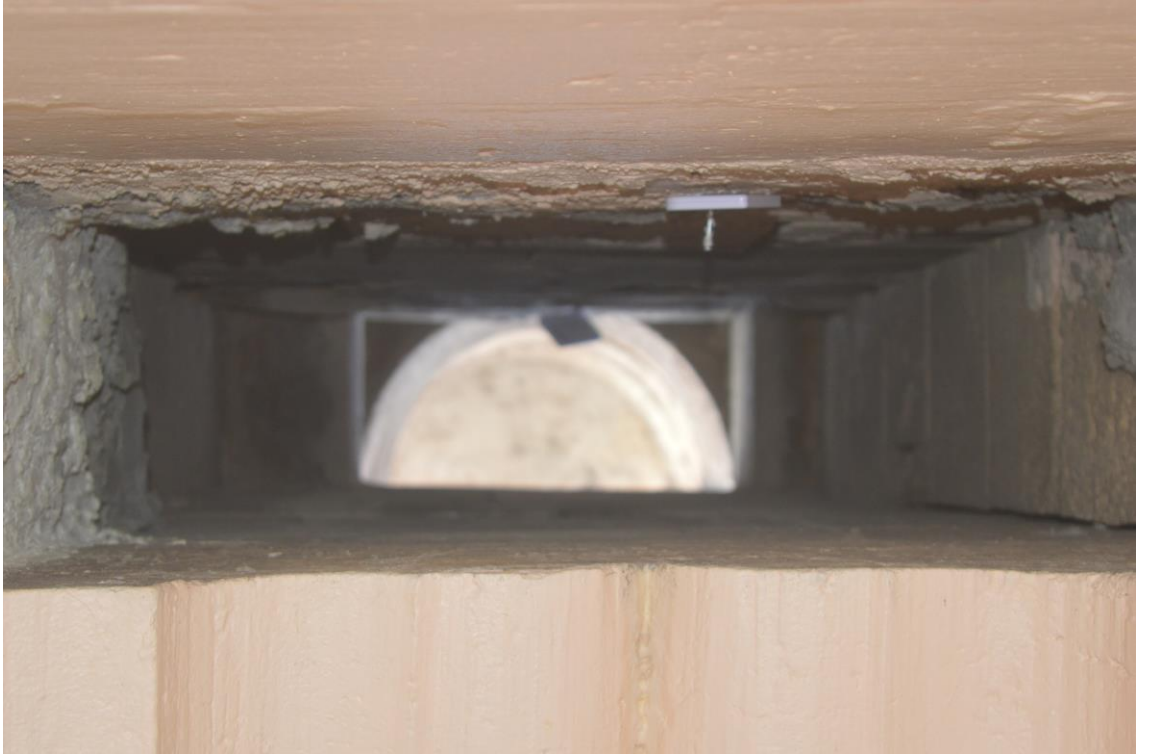
Şekil 4.56. Hava Kanalının Eyvandan (Alttan) Görünümü (Melikoğlu 2018)
