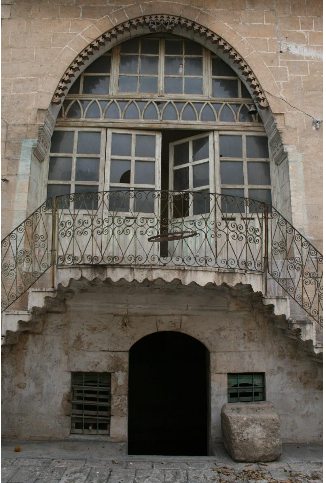
Şekil 4.77. Restorasyon Öncesinde Kapatılan Eyvanın Görünümü (Ş.K.V.K.K.)
