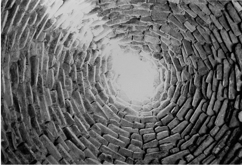
Şekil 2.36. Harran Evlerinde Bulunan Havalandırma Deliği (Özdeniz ve Ark.483 1998)
