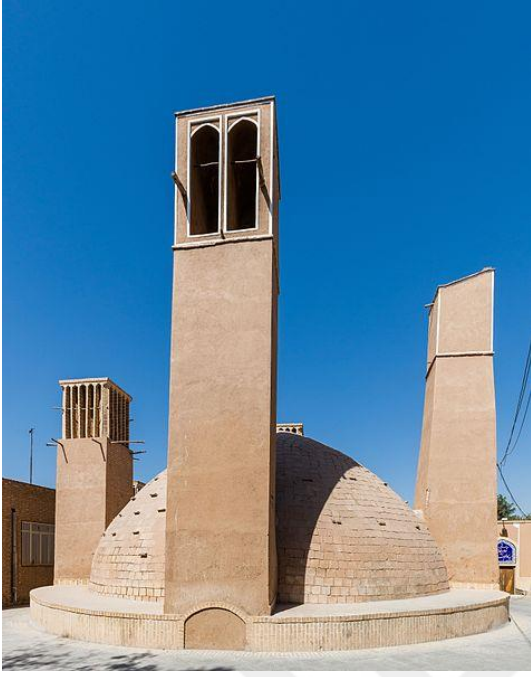
Şekil 2.48. Ab Anbar'da Bulunan Su Sarnıcında Kullanılan Tek Yönlü Rüzgâr Kulesi Örneği Yazd-İran (URL-23)
