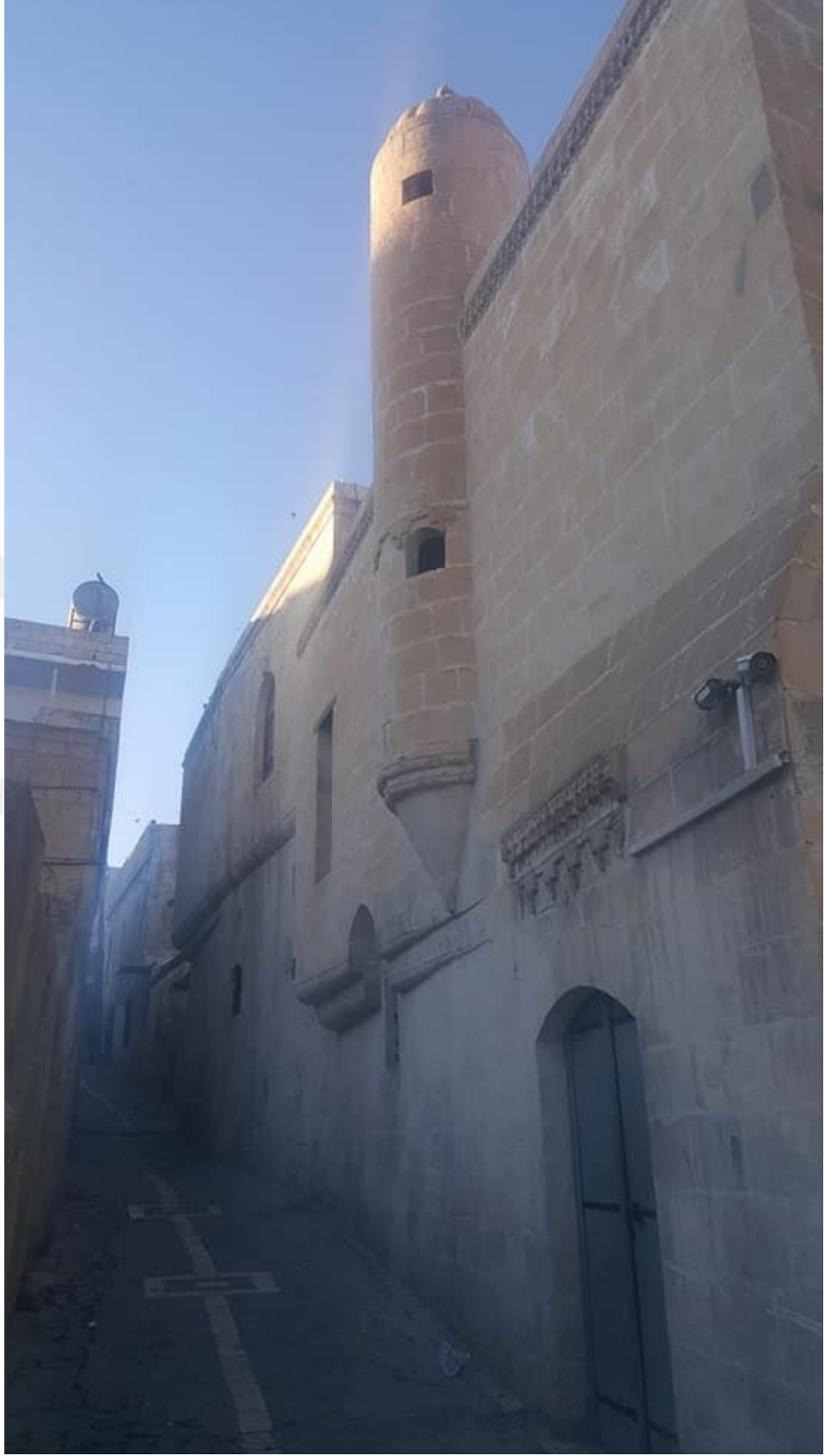
Şekil 4.92. Rüzgar Yakalayıcı Gibi Tasarlanan Merdiven Kovasının Sokak Cephesinden Görünümü (Melikoğlu 2018)
