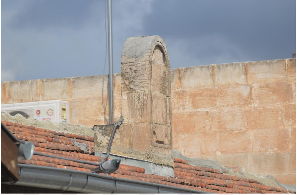
Şekil 4.15. Restorasyon Sonrasında İnşa Edilen Badgel'in Sokak Cephesinden Görünümü (Melikoğlu 2018)
