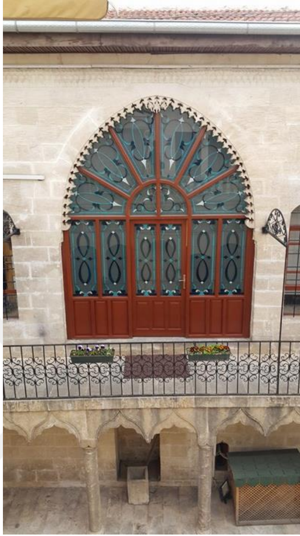
Şekil 4.17. Restorasyon Sonrasında Kapatılan Eyvanın Görünümü (Melikoğlu 2018)
