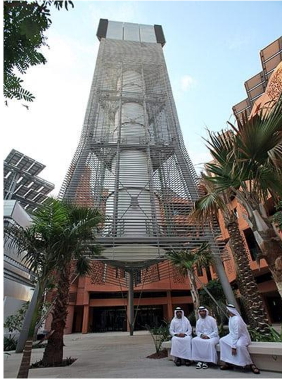
Şekil 2.92. Masdar Enstitüsü'ndeki Rüzgâr Kulesinin Görünümü "Abu Dabi" (URL-39)
