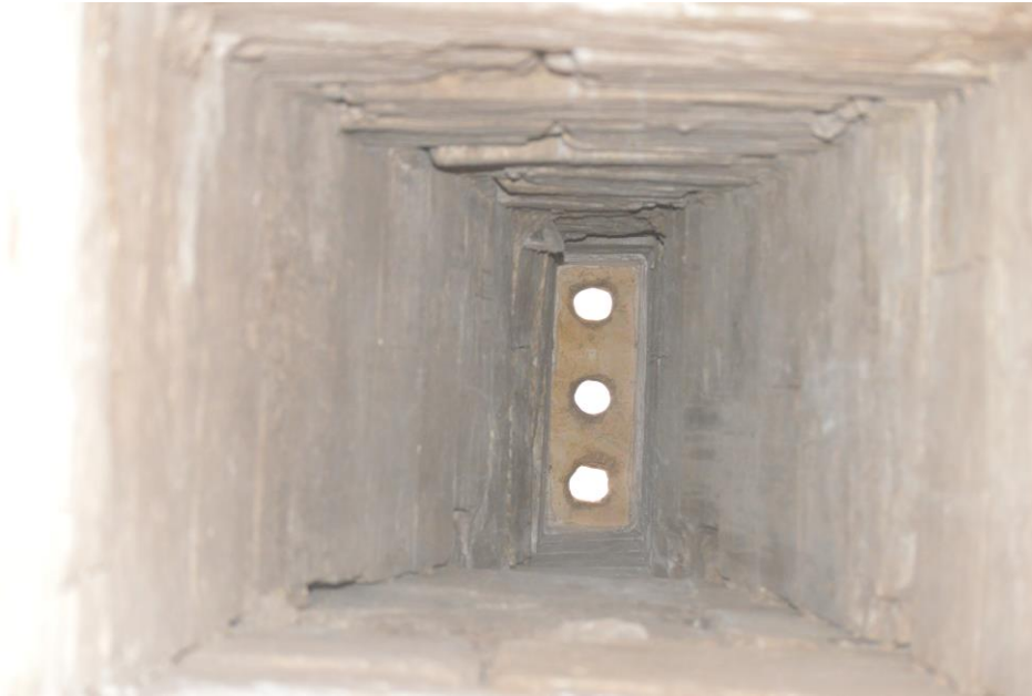
Şekil 4.42. Restorasyon Sonrası Nişi Dama Bağlayan Hava Kanalı'nın Görünümü (Melikoğlu 2018)
