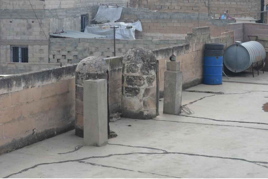
Şekil 4.76. Farklı Müdahalelerle Fonksiyonlarını Yitiren Badgellerin Arka Görünümü (Melikoğlu 2018)
