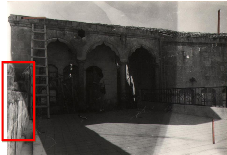
Şekil 4.87. Damda Parapet Duvara Gömülü Olan Badgelin Baş Kısmı (Ş.K.V.K.K. Arşivi)
