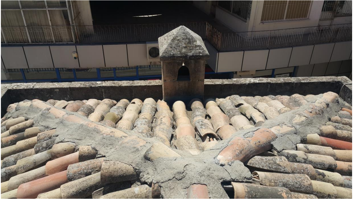
Şekil 4.33. Restorasyon Sonrasında Badgel Yerine Yapılan Baca (Melikoğlu 2018)
