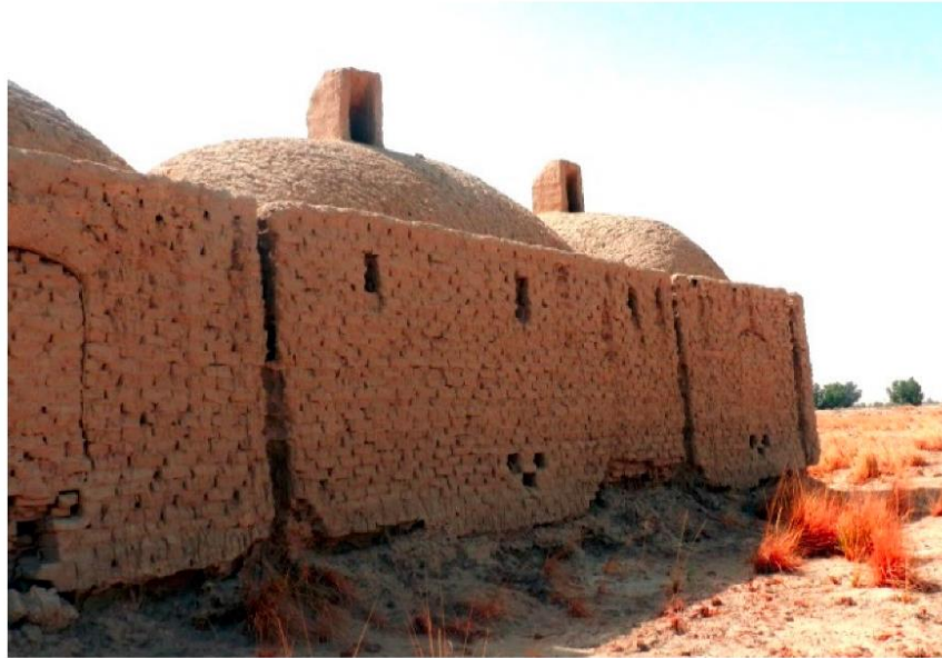
Şekil 2.88. Sistan Vilayetinde Bulunan Rüzgâr Kepçelerinin Binadaki Konumu (Sahebzadeh ve Ark. 2017:22)
