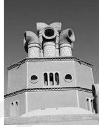
Şekil 2.61. İran'da Bulunan Seid Ali Asghar-e-Razvai Evinde Bulunan Boru Şekindeki Rüzgâr Yakalayıcıları (Bahadori ve Dehghani-sanij 2014:70)
