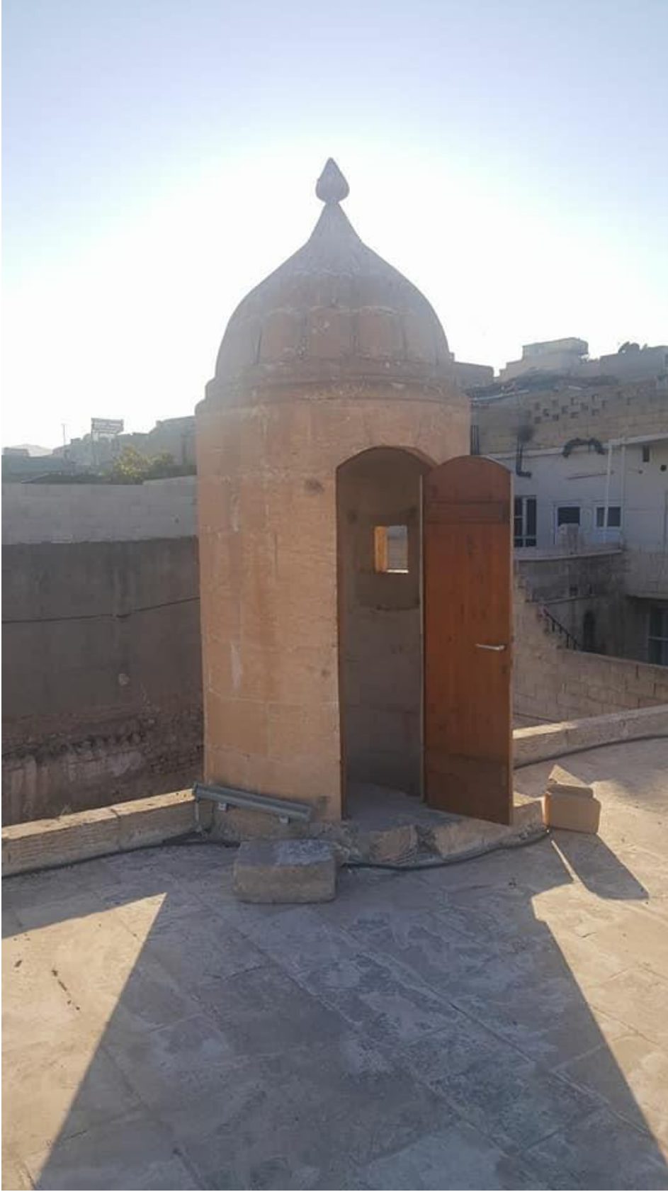
Şekil 4.93. Sıcak Havalarda Kuzeye Bakan Kapısı Açılarak Havalandırma Sağlanan Merdiven Kovanının Damdan Görümü (Melikoğlu 2018)
