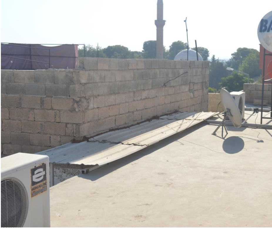
Şekil 4.63. Kuzey Yönünde Örülen ve Kuzey Rüzgarını Kesen Parapet Duvarı (Melikoğlu 2018)
