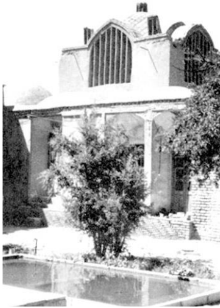
Şekil 2.62. Sirjan'da (İran) Bulunan Rüzgâr Yakalayıcı Örneği (Bahadori ve Dehghani-sanij 2014:77)
