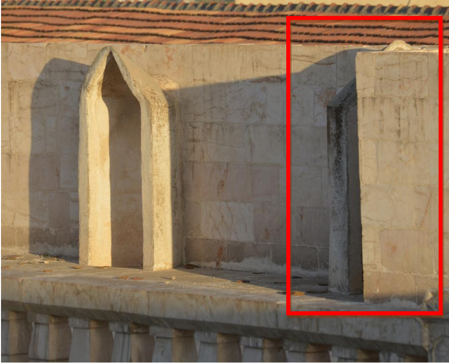
Şekil 4.82. Parapet Duvarla Önü Kapatılan Batıya Yönündeki Badgelin Görünümü (Melikoğlu 2018)
