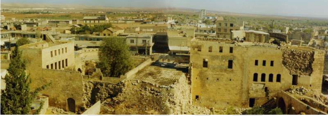
Şekil 4.37. Restorasyon Öncesi Kısmi Yıkılma ve Bozulmaların Görüldüğü Mahmutoğlu Kulesi (Kürkçüoğlu 1990)
