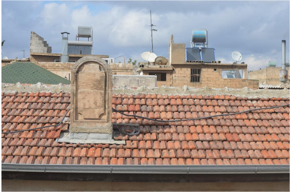
Şekil 4.16. Restorasyon Sonrasında İnşa Edilen Badgel'in Sokak Cephesinden Görünümü (Melikoğlu 2018)
