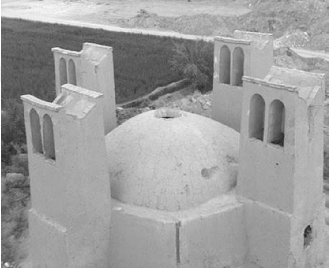
Şekil 2.51. Aub-Anbar'da Dowlat Abbad Garden'da Bulunan İki Yönlü Rüzgâr Kuleleri (Bahadori 2014:65)
