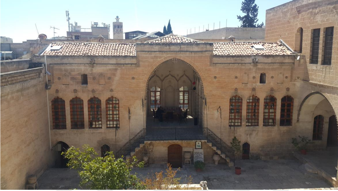
Şekil 4.26. Ş.K.V.K.K. Binasında Haremlik Kısımında Bulunan Üzeri Kıırma Çatı ile Örtülen Bölüm (Melikoğlu 2018)
