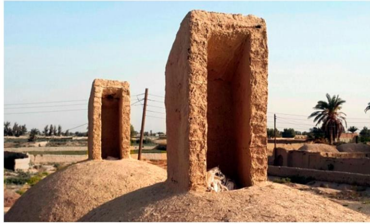
Şekil 2.87. Sistan'da Yaygın Olarak Bulunan ve Afganistan'daki Badkhor ile Şekilsel Benzerlik Gösteren Rüzgâr Kepçeleri (Sahebzadeh ve Ark. 2017:22)
