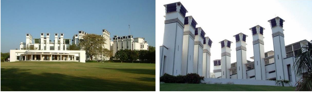
Şekil 2.15. Torrent Araştırma Merkezi Ve Soğutma Kuleleri. (URL-12)
