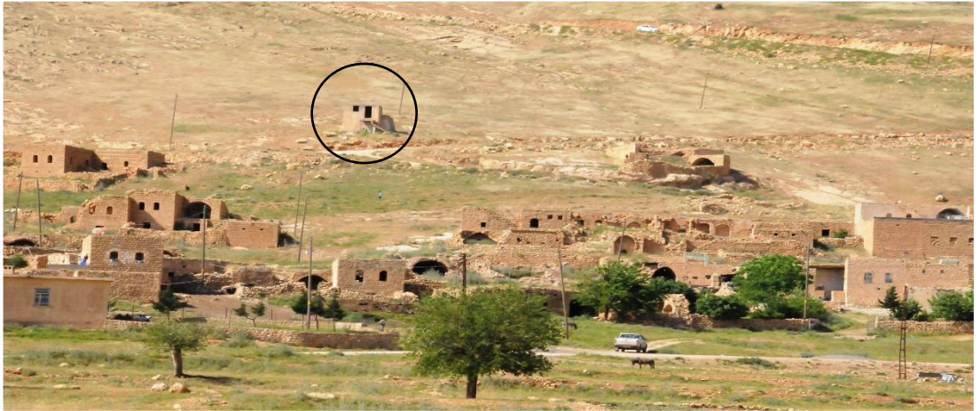
Şekil 5.3: Alımlı Köyü betonarme su deposu ( Ö.Yıldız, 2018 )
