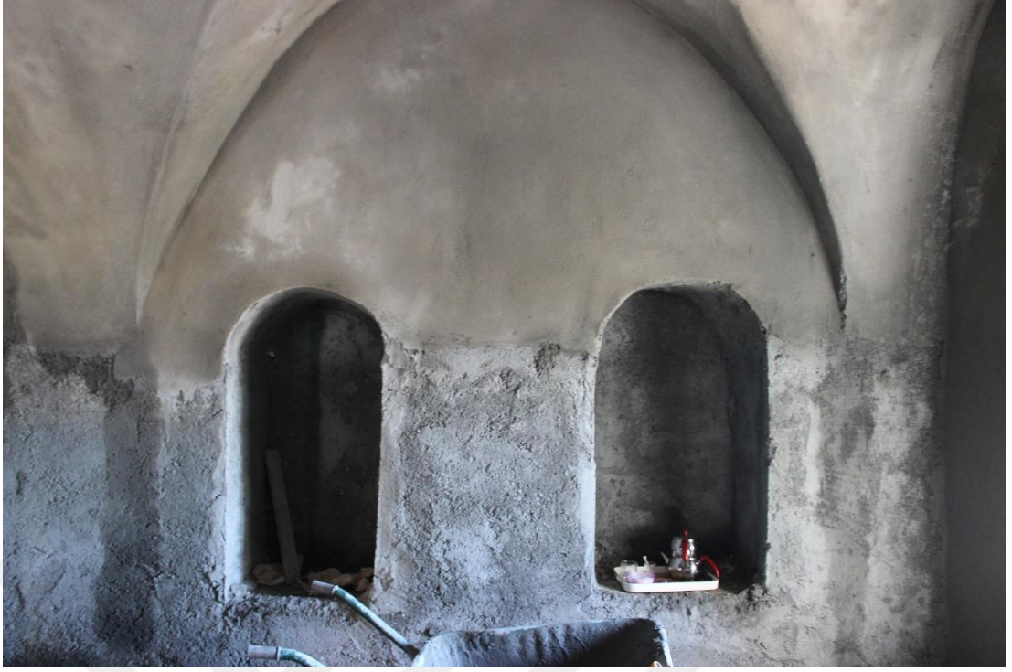
Şekil 5.11: Çimento malzemesi ile müdahale yapılmış duvar (Ö.Yıldız, 2018)
