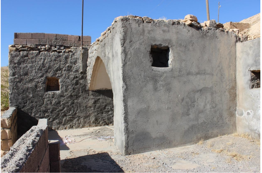
Şekil 5.11: Çimento malzemesi ile müdahale yapılmış duvar (Ö.Yıldız, 2018)
