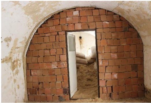
Şekil 6.1- 6.2 :Yapılara eklenen tuğla ve çimento malzeme uygulaması
