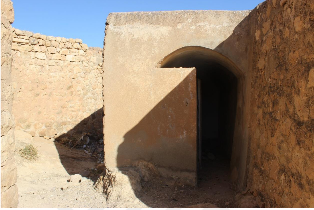
Şekil 5.15: Çimento malzemesi ile eklenti yapılmış yapı (Ö.Yıldız, 2018)
