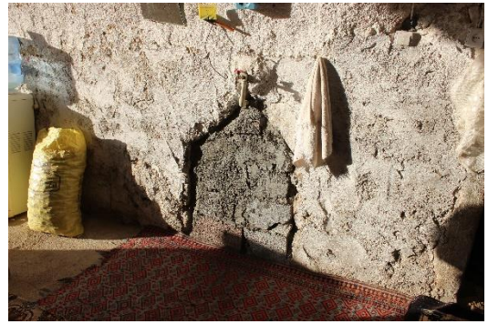
Şekil 6.1- 6.2 :Yapılara eklenen tuğla ve çimento malzeme uygulaması
