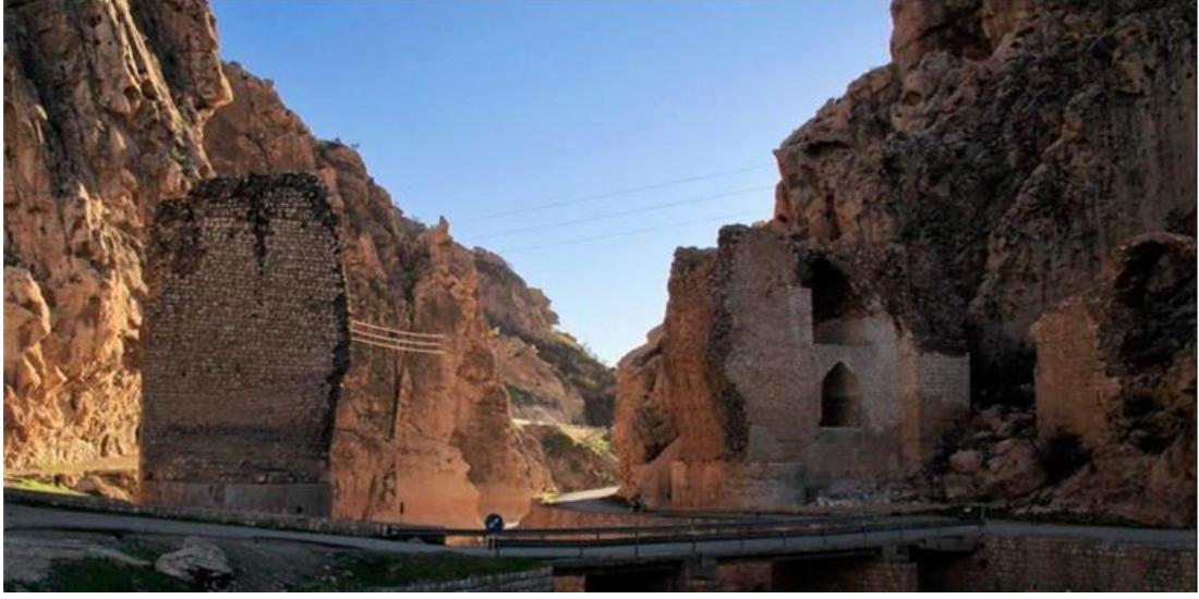
Şekil 10: Kalhur köprüsünün (Pul-i Kalhur) günümüze kadar gelmiş ana kaideleri 395
