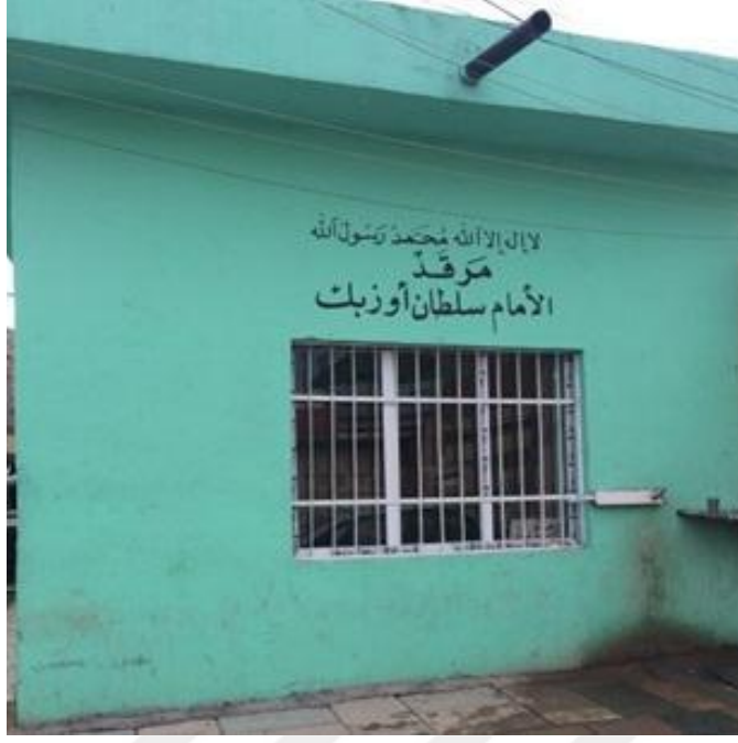
Şekil 3.6 Sultan Özbek Türbesi görüntüsü.
