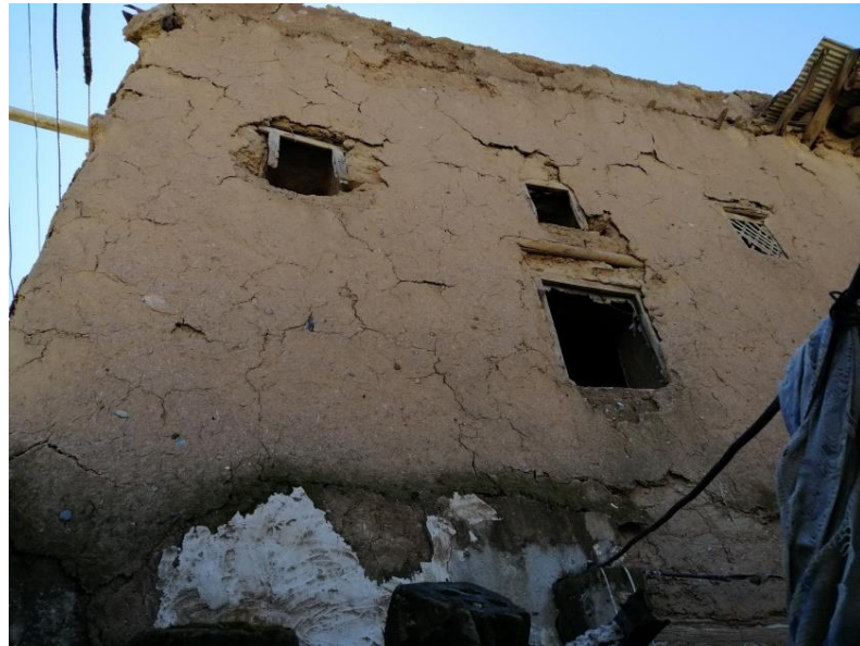
Şekil 4.11 Tahir Çaycı Evi Ön Cephe Görüntüsü.
