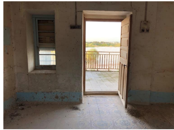
Şekil 4.49. Hacı Osman Oruç Evi avludan dör biriminde balkona bakış fotoğrafı.
