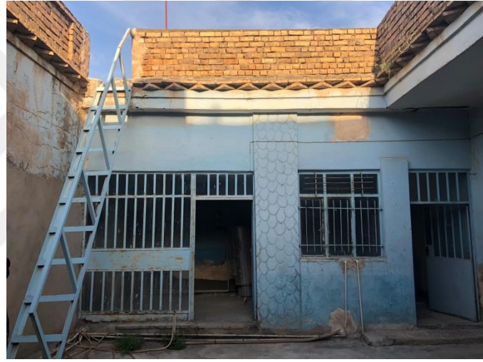
Şekil 4.48 Hacı Osman Oruç Evi avludan mutfak ve hol mekânının fotoğrafı.
