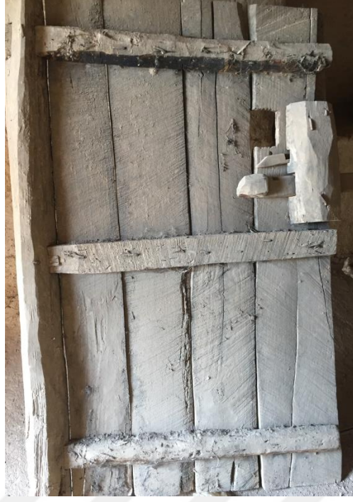
Şekil 4.13 Tahir Çaycı Evi özgün kapı ve kapı detayı.
