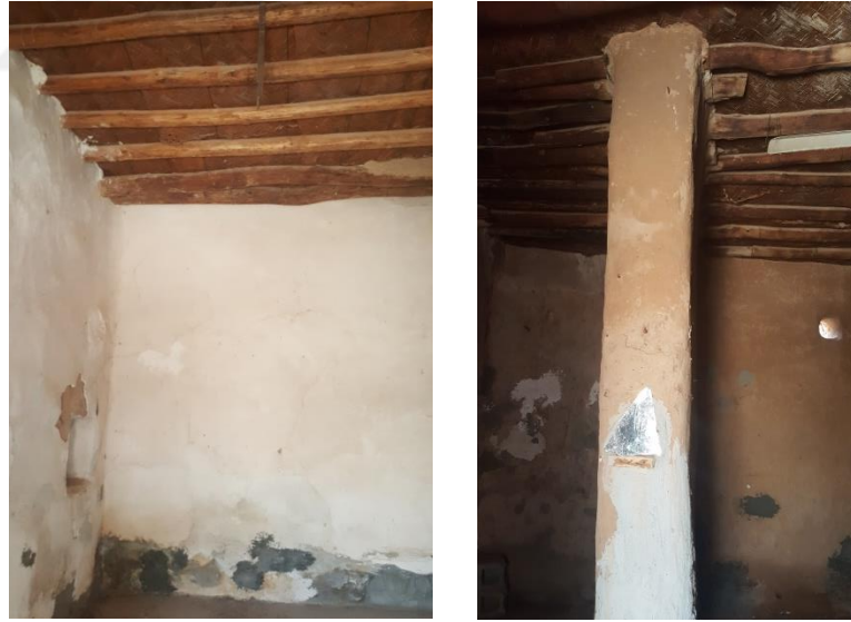
Şekil 4.21 Ahmet Ali Evi solda yangöz tavan örüntüsü görüntüsü ve sağda dör biriminde yer alan dinge görüntüsü.
