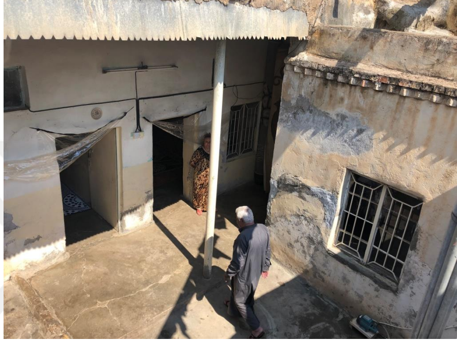
Şekil 4.41 Muhammet Mehdi Evi damdan avluya bakış fotoğrafı.
