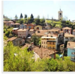
Saat Kulesi Çevresindeki Yapıların Cephe İyileştirme Projesi
