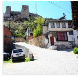
Kale Çevresindeki Yapıların Cephe İyileştirme Projesi
