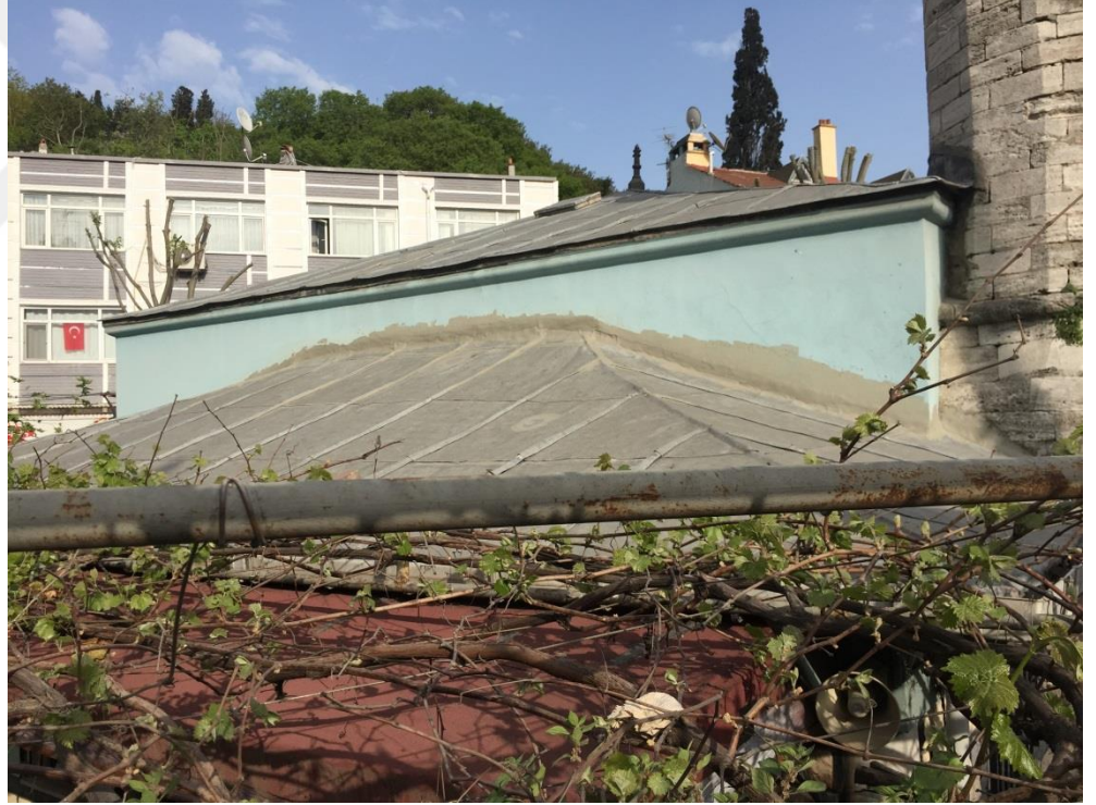
Şekil 51 Harim ve son cemaat birimlerinin mevcut çatı örtüsü
