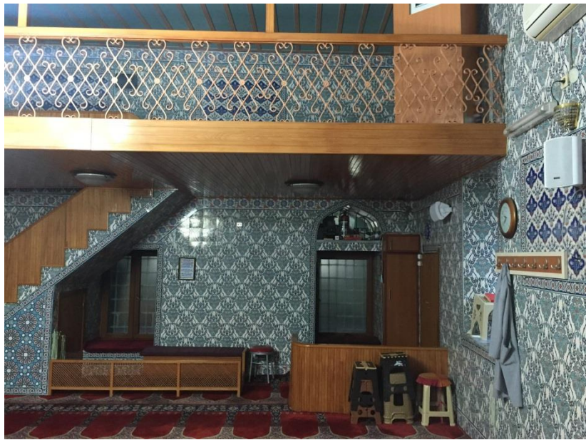
Şekil 49 Mahfil katı döşemesi (M. Ilgaz,2019)
