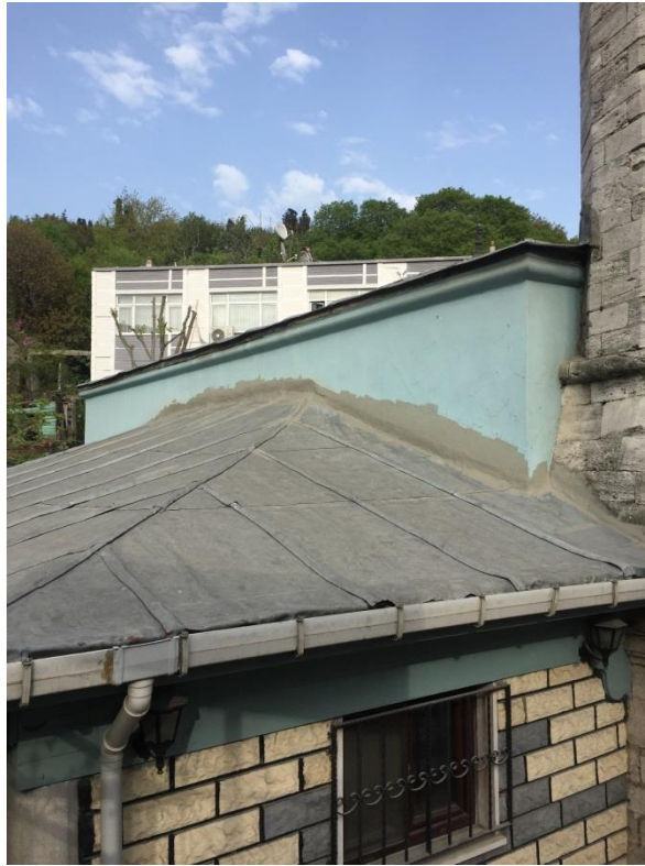
Fotoğraf 39: Çatı örütüsü (M. Ilgaz, 2019)
