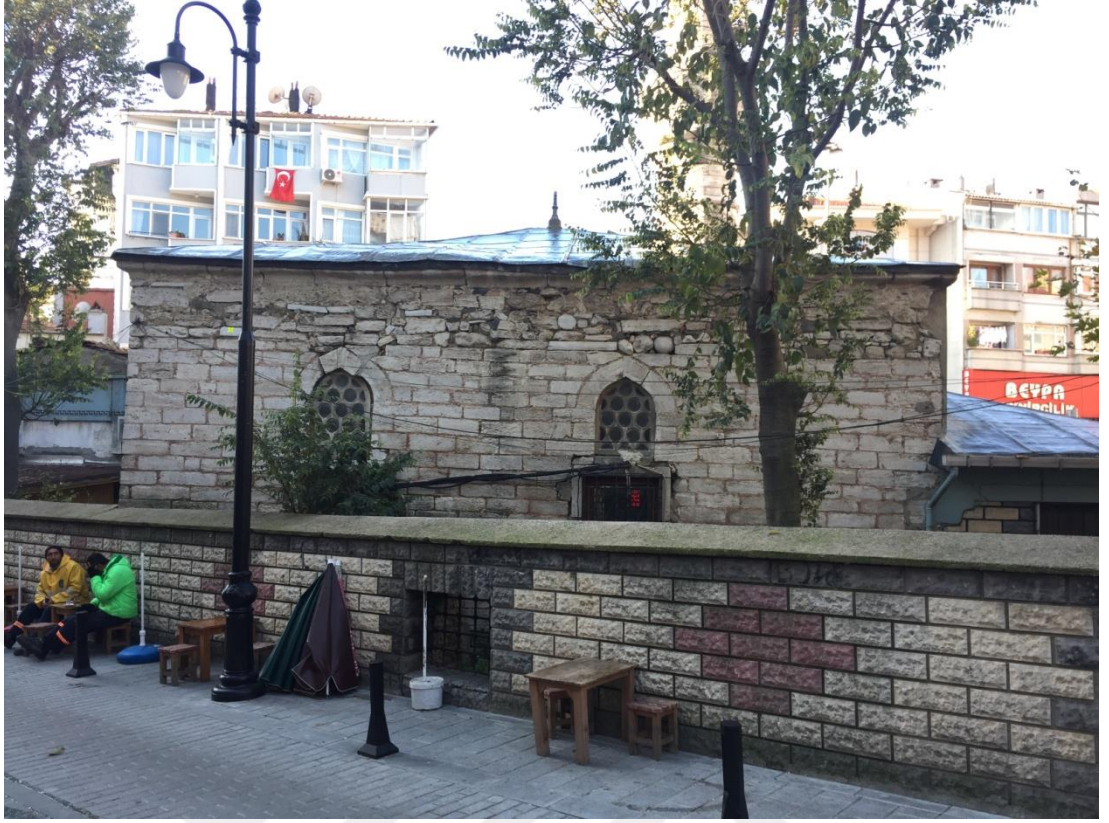
Şekil 38 Kuzeydoğu Cephesi (M. Ilgaz,2018)
