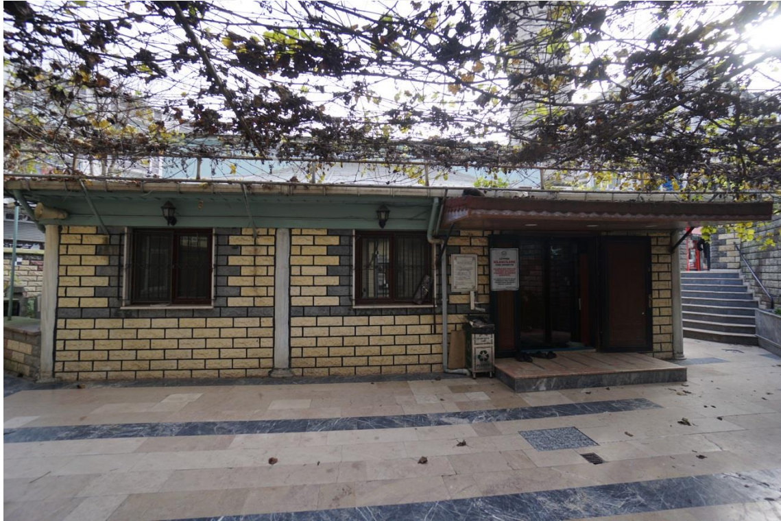
Fotoğraf 11: Son cemaat giriş cephesi (M. Ilgaz, 2019)
