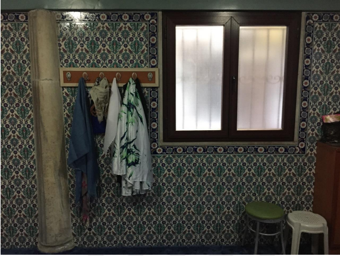
Fotoğraf 26: Kasım Çavuş Camii son cemaat alanı sütun ve pvc pencere (M. Ilgaz, 2019)
