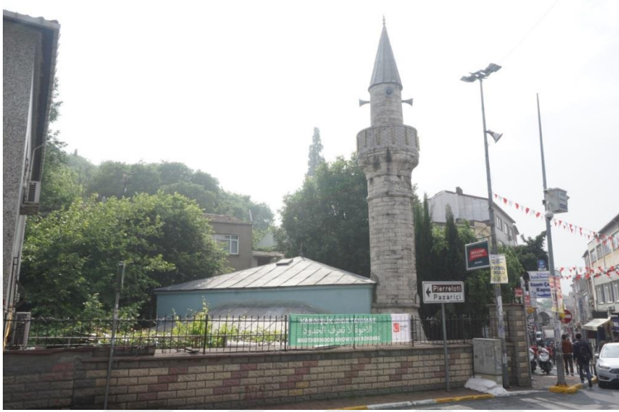
Şekil 46 Kuzeybatı yönünden çevre duvarları görünüşü, (M. Ilgaz,2019)
