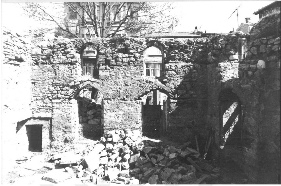
Şekil 61 Çeribaşı Cami, yeniden yapılmadan önce
