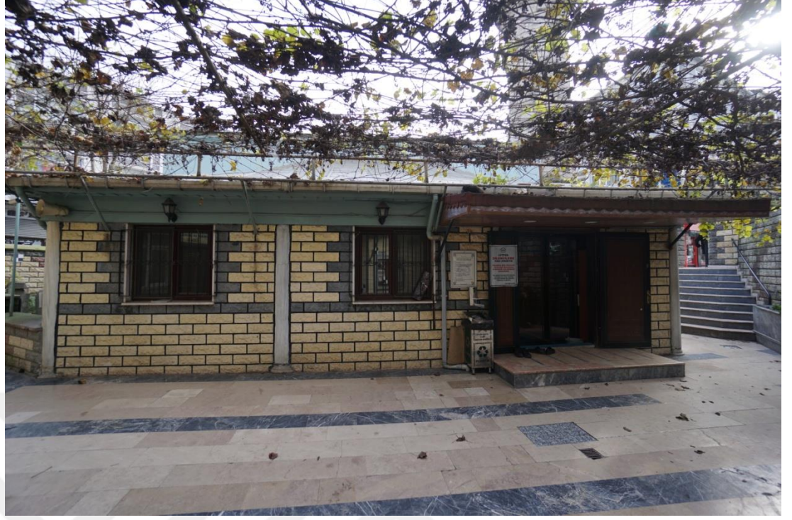
Şekil 34 Kuzeybatı Cephesi (M. Ilgaz,2019)
