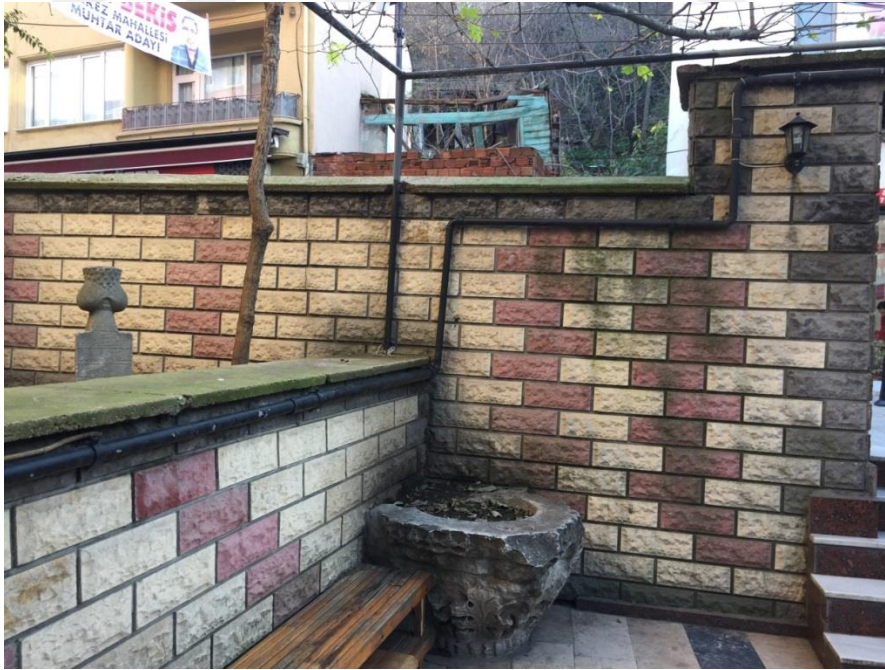
Şekil 47 Kuzeydoğu yönündeki çevre duvarı görünüşü (M. Ilgaz,2019)
