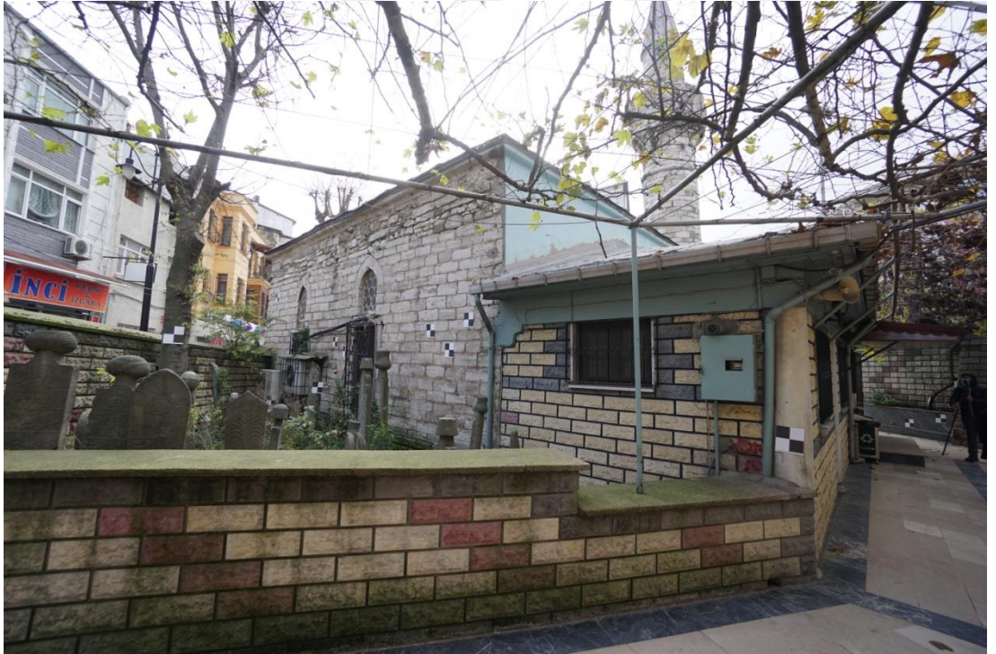
Şekil 39 Kuzeydoğu Cephesi (M. Ilgaz,2018)
