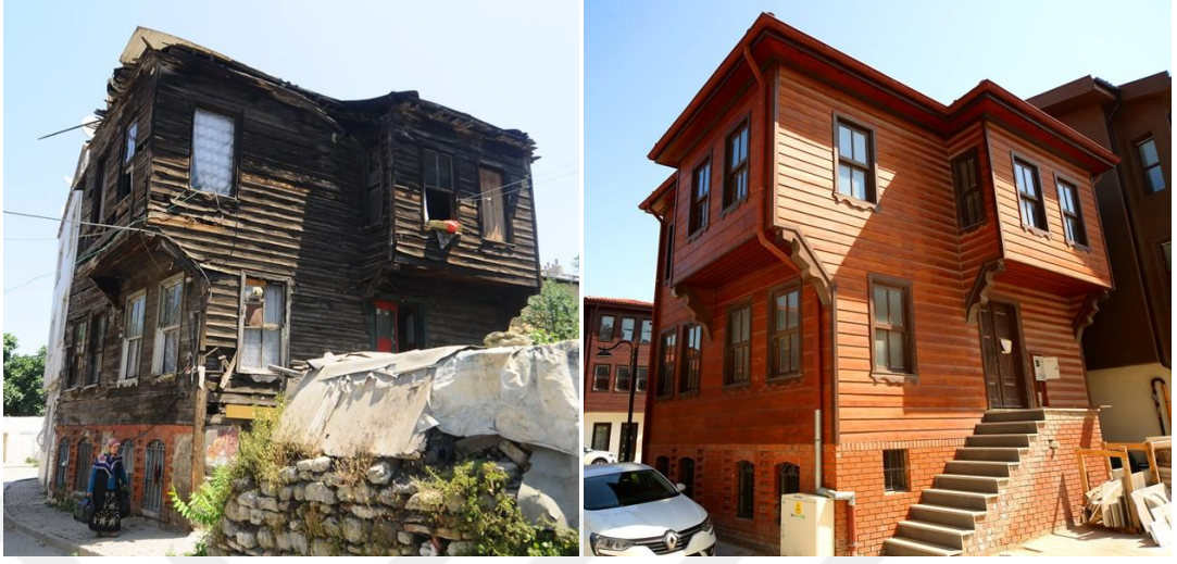
Resim 2.29 Ayvansaray dönüşüm öncesi ve sonrası yapı fotoğrafları (Url-29)
