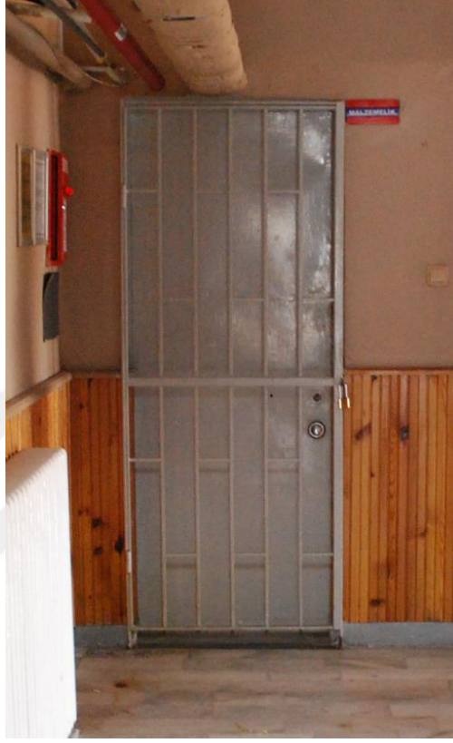
Şekil 3.27 Z12 Malzemelik Giriş Kapısı (2018)
