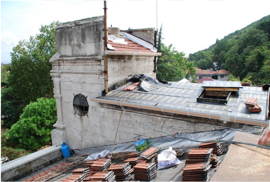
Şekil 3.90 Saat Kulesi Kuzeybatı Cephesi (2018)
