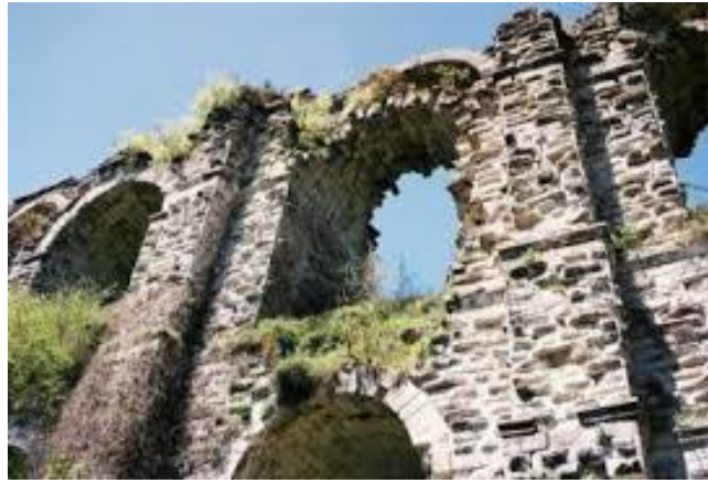
Şekil 2.6 Çatalca Su Yolu Kemer Kalıntısı (Url-4, 2019)
