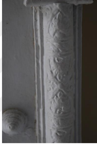
Şekil 3.110 Üst Kat Ana Giriş Kapısı Demir Bini (2018)
