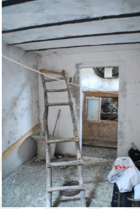
Şekil 3.98 Saat Kulesi Volta Döşemesi (2018)
