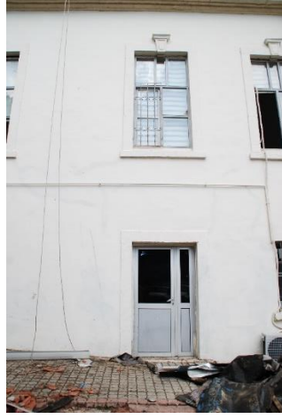
Şekil 3.112 Mutfak Giriş Kapısı (2018)
