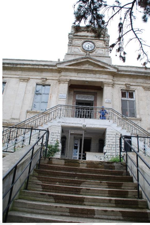
Şekil 3.105 Fetih Caddesi Bahçe Giriş Merdiveni (2018)
