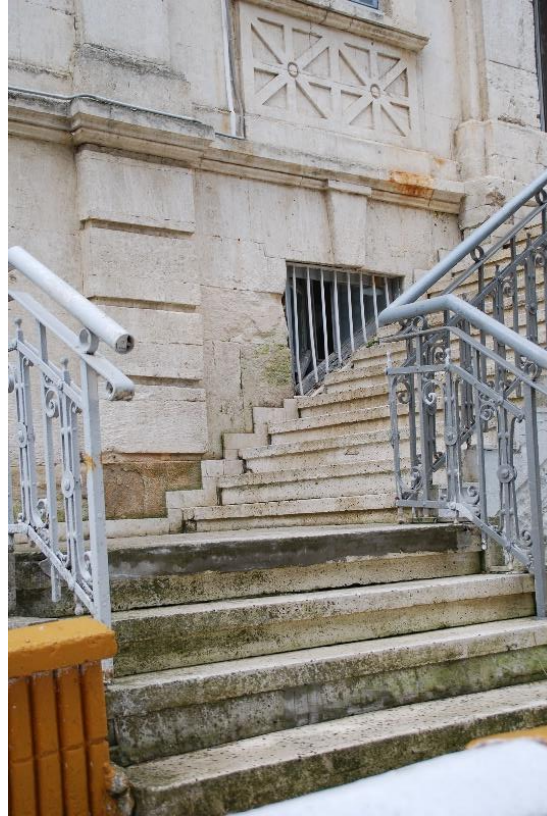
Şekil 3.100 Kuzeydoğu Ana Giriş Cephesi Merdiveni (2018)
