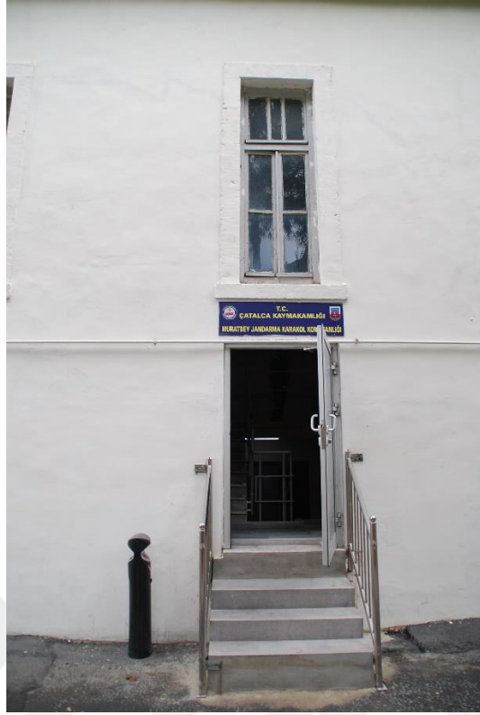
Şekil 3.101 Güneybatı Giriş Merdiveni (2018)
