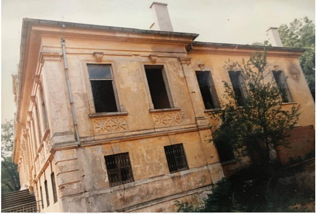
Şekil E.23 Kuzey Batı Cephesi, 1985 (İstanbul 1 Numaralı KVKBK)
