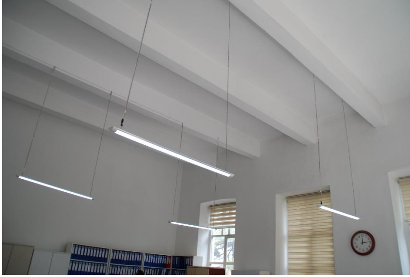
Şekil 3.123 Yapının Betonarme Kirişleri (2018)
