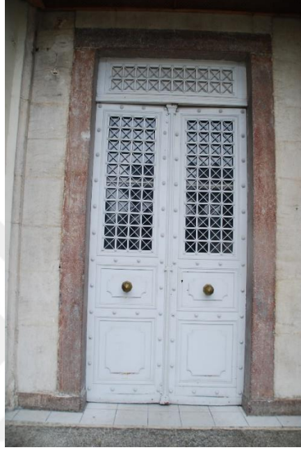
Şekil 3.48 Üst Kat Giriş Kapısı (2018)
