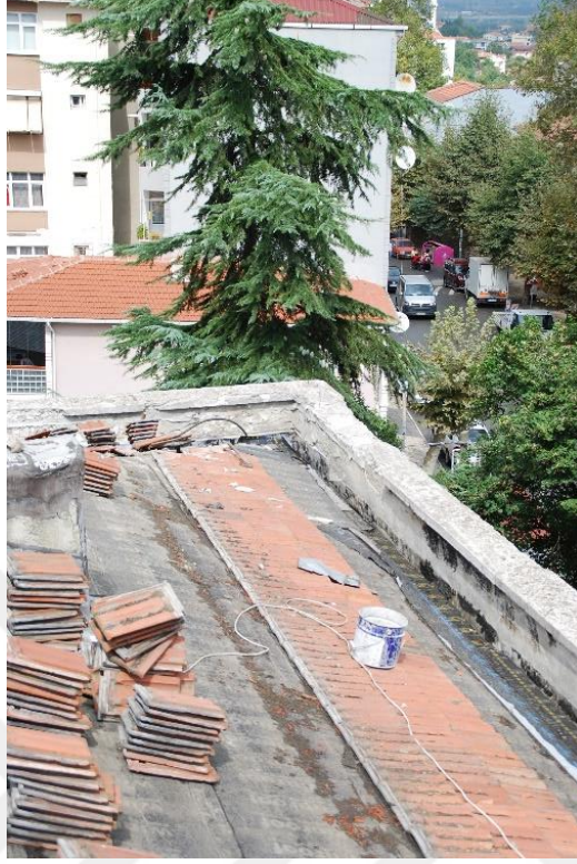
Şekil 3.106 Yapının Çatı Kaplaması ve Parapetleri (2018)
