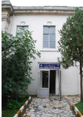
Şekil 3.114 Kuzeybatı Cephesi Rüzgârlık Girişi (2018).
