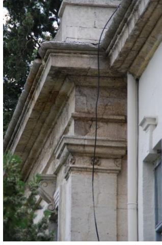
Şekil 3.129 Parça Kopması ve Çatlaklar (2018)
