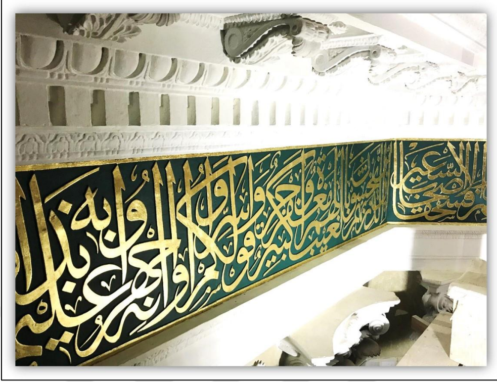
Şekil 19: Sultan II. Mahmud Türbesi, Çemberlitaş (Restorasyon Sonrası) / 2018
