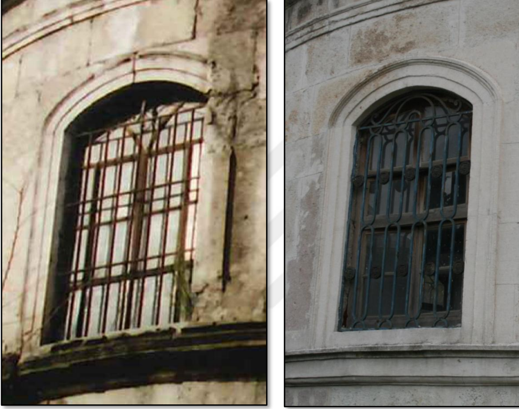
Şekil 49: Üst Pencere Demir Parmaklık - 2001 Restorasyon Öncesi / 2017
