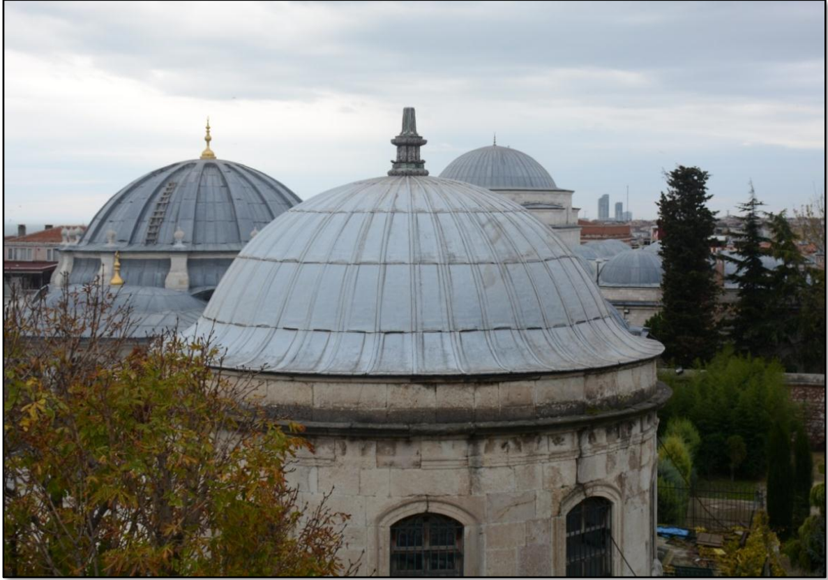
Şekil 46: Kubbe Üzeri Kurşun Kaplama
