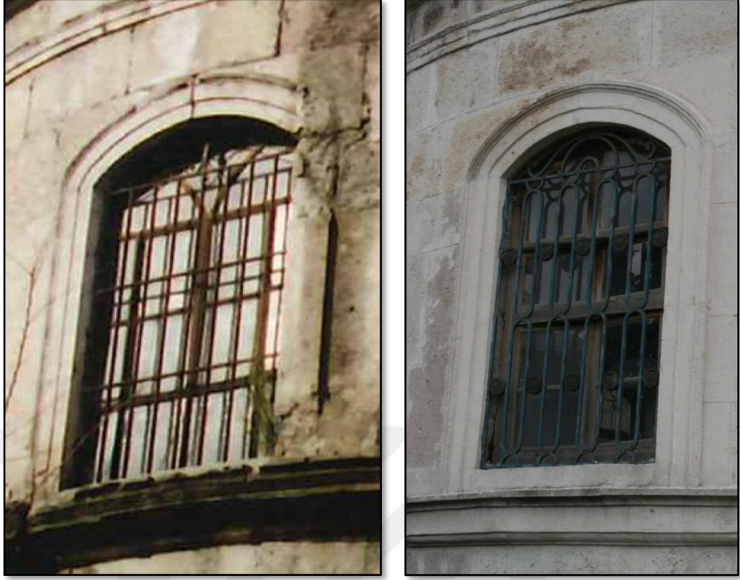
Şekil 134: Üst Pencere Demir Parmaklık - 2001 Restorasyon Öncesi / 2017
