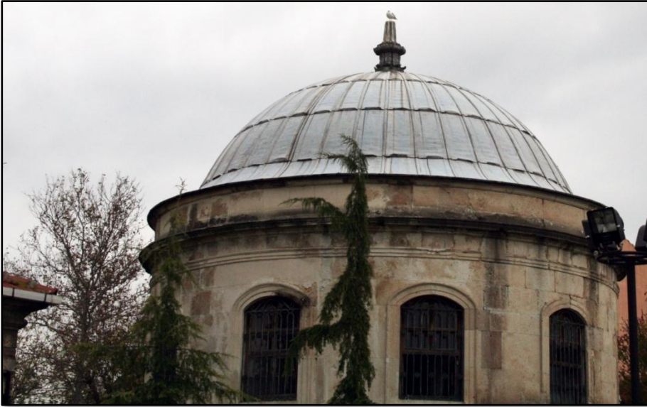
Şekil 116: Üst Örtü Kurşun Kaplama - 2001 Restorasyon Öncesi / 2017
