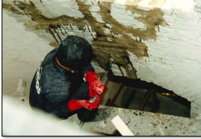
Şekil 112: Epoksi Harçla Çatlak Doldurulması- 2000-2003 Onarım Uygulaması
