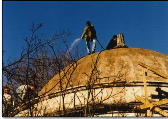
Şekil 117: Kurşun Kaplamamın Yenilenmesi - 2000-2003 Onarım Uygulaması
