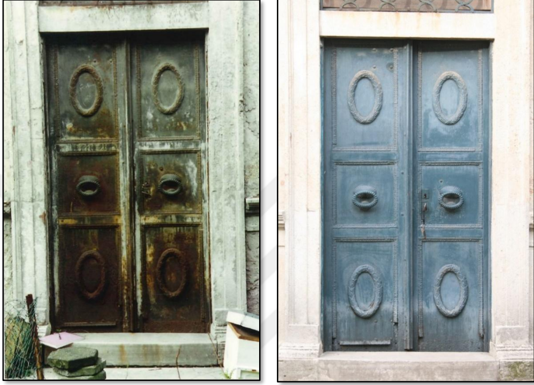
Şekil 104: Giriş Kapısı – 2001 Restorasyon Öncesi / 2017
