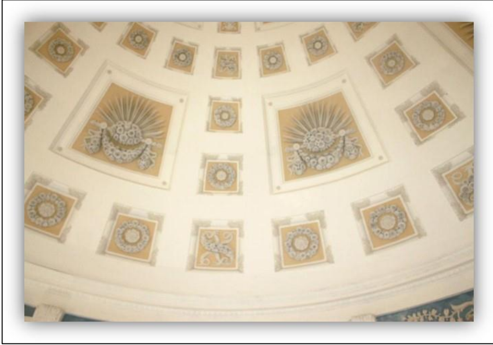
Şekil 18: Sultan II. Mahmud Türbesi, Çemberlitaş (Restorasyon Sonrası) / 2018
