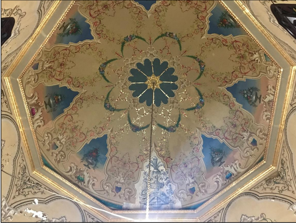
Şekil 23: Sultan Abdülmecid Türbesi tavan görünümü / 2017
