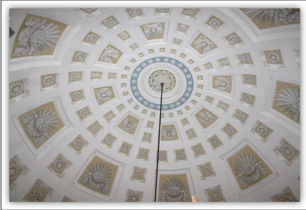
Şekil 12: Sultan II. Mahmud Türbesi, Çemberlitaş (Restorasyon Sonrası) / 2018
