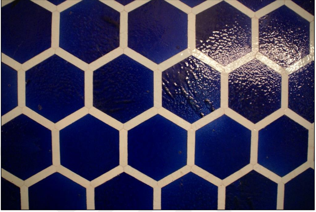
R.13: Bursa Yeşil Camii Doğu Duvarı Çinileri Yakın Çekim
