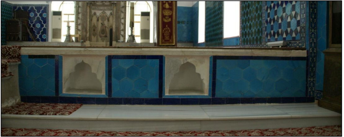
R. 59: Bursa Muradiye Camii Ana Eyvana Çıkış Merdivenlerinin Sağındaki Çiniler
