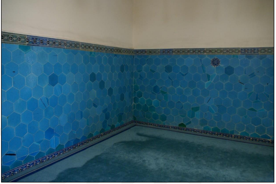
R.38: Bursa Yeşil Camii Alt Kat Girişin Doğu Cephesinde Bulunan Tabhane
