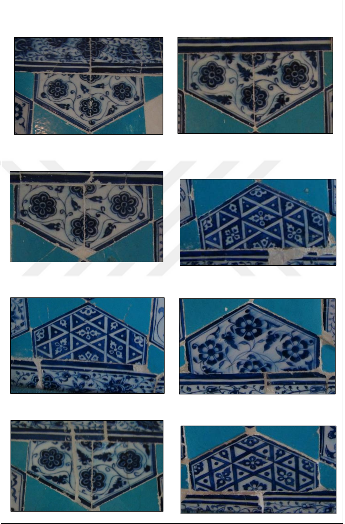
R.117: Doğu Duvarında Köşelerde Bulunan Yarım Altıgenler
