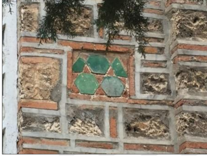
Resim 7: Bursa Orhan Bey Camii Mihrap duvarının Doğusunda Bulunan Pencerenin Sağ Tarafı
