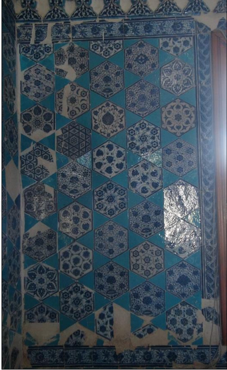
R.131: Mihrap Duvarının Sol Tarafında Bulunan Çini Pano
