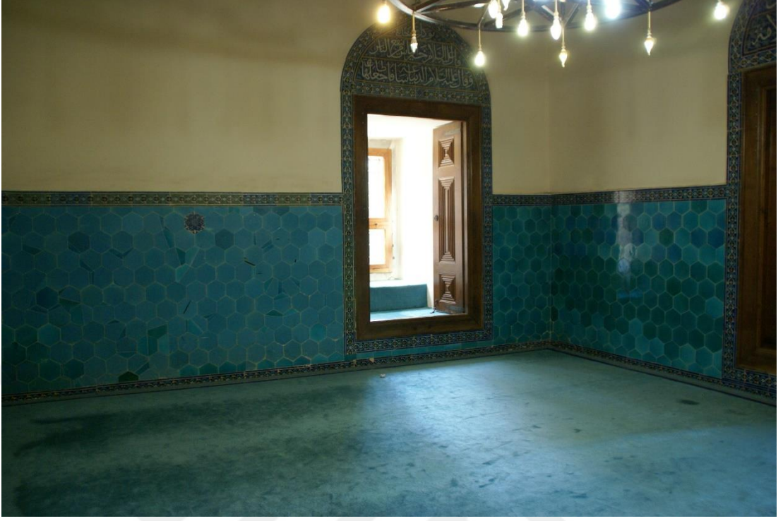
R.: 36 Bursa Yeşil Camii Alt Kat Girişin Doğu Cephesinde Bulunan Tabhane
