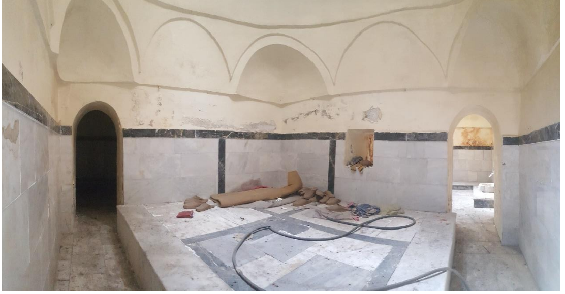
Şekil 40 : Deydinler Köyü Hamamı ılıklık Bölümünün Genel Görünüşü (F. Terzi 2019)
