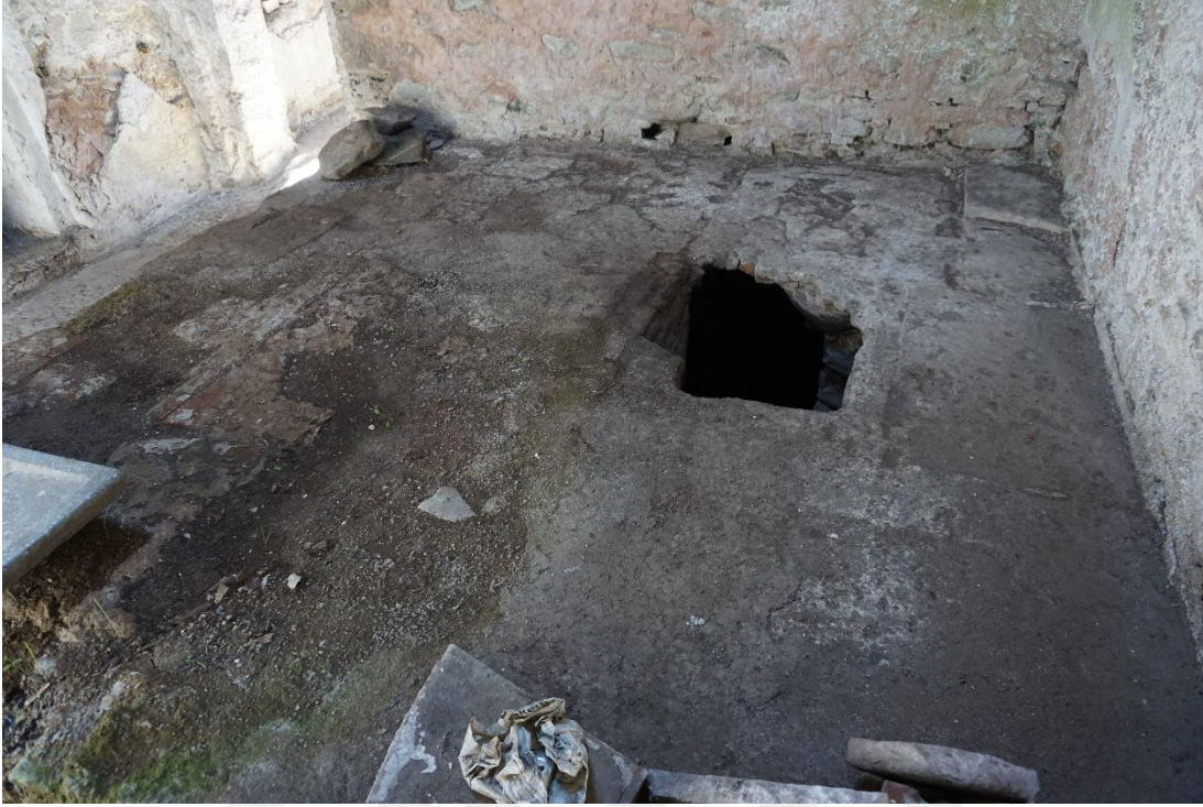
Şekil 7 : Z01 Ilıklık Bölümündeki Göbek Taşının Görünüşü (F. Terzi 2018)
