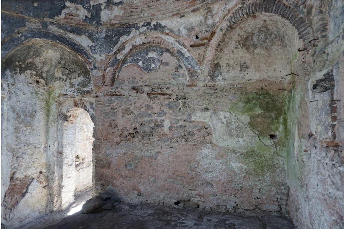
Şekil 9 : Z01 Ihlık B3lümü Güney Duvarının Görünüşü (F. Terzi 2018)
