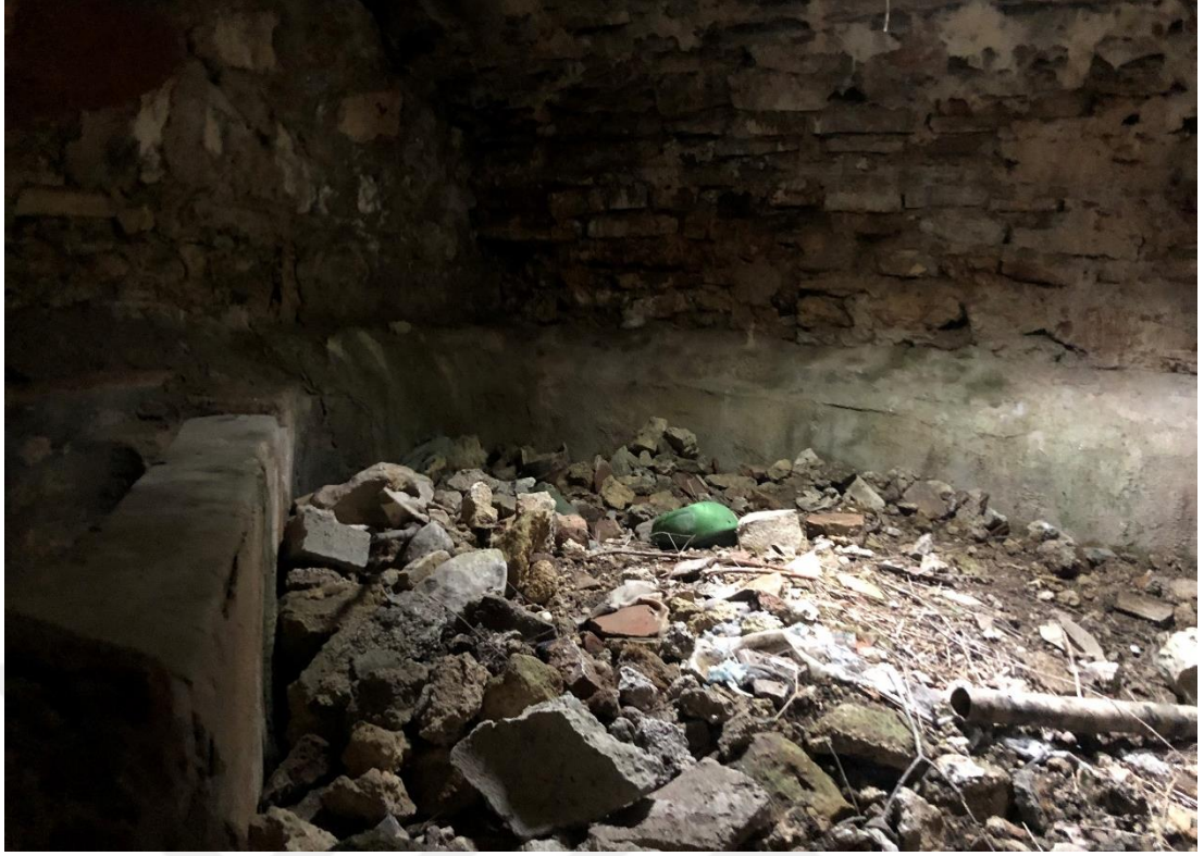
Şekil 76 : İnegöl İlçesi Şipali Köyü Hamamı Sıcak ve Soğuk Su Kısımının Görünüşü (F. Terzi 2019)
