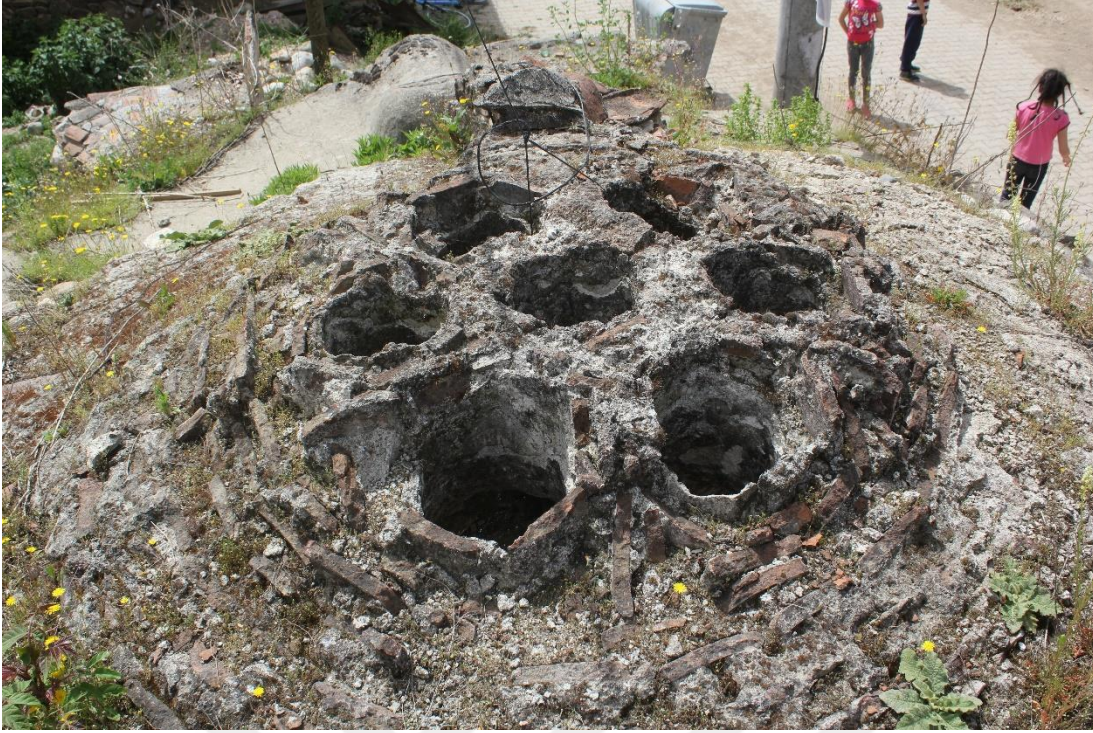
Şekil 75 : İnegöl İlçesi Ortaköy Hamamı Işık Kubbeciğinin Dıştan Görünüşü (F. Terzi 2019)
