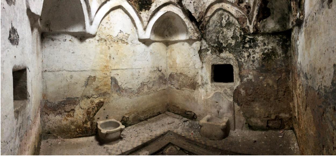
Şekil 42 : Şehitler Köyü Hamamı Sıcaklık Bölümünün Genel Görünüşü (F. Terzi 2019)
