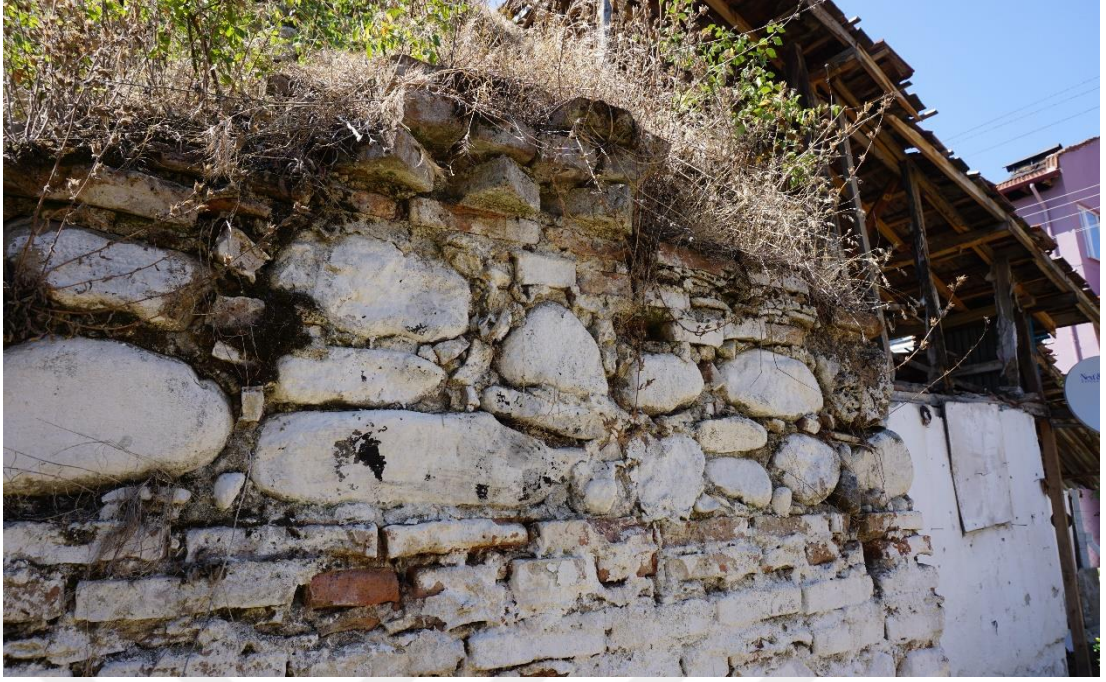
Şekil 29 : Doğu Cephesinde Özgün Kirpi Saçak Kalıntısının Görünüşü (F. Terzi 2018)
