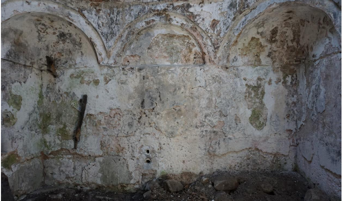
řekil 15 : Z02 Sıcaklık Bölümü Batı Duvarının Görünüřü (F. Terzi 2018)
