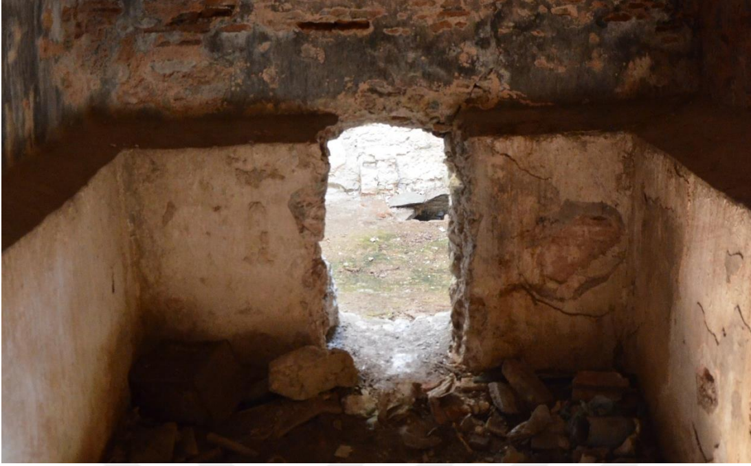
Şekil 47 : Su Deposunun Doğu Duvarındaki Açıklığın Görünüşü (F. Terzi 2018)
