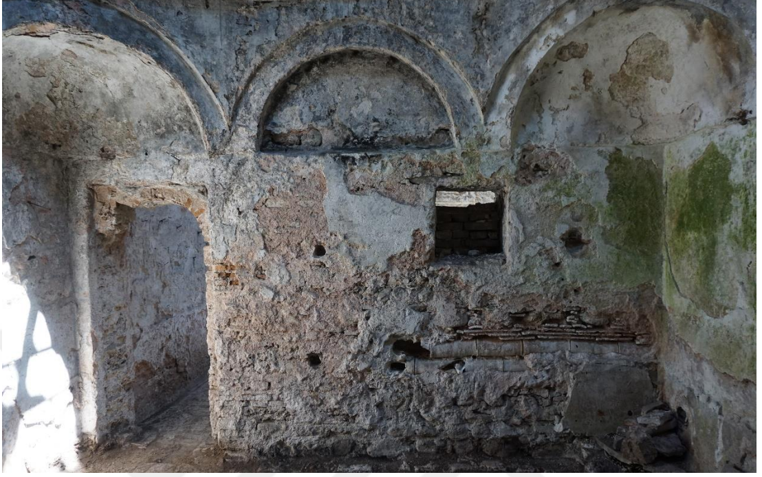
řekil 14 : Z02 Sıcaklık Bölümü Dođu Duvarının Görünüřü (F. Terzi 2018)
