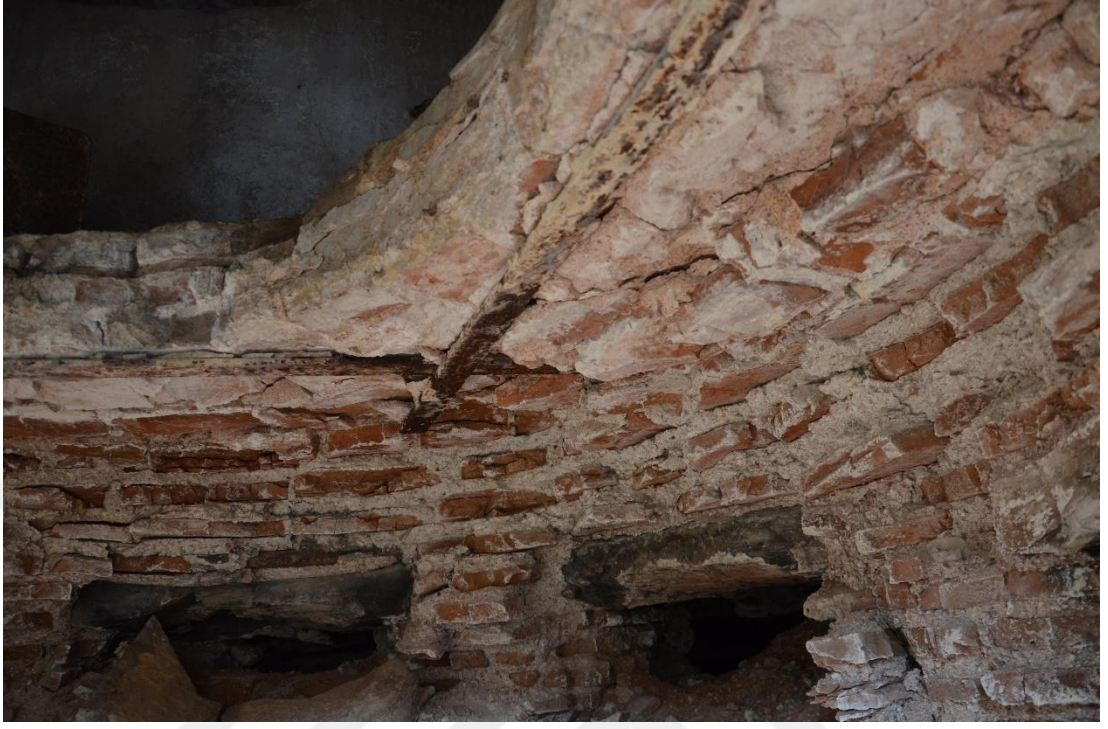
Şekil 50 : Külhan Bölümündeki Kanalların Görünüşü (F. Terzi 2018)
