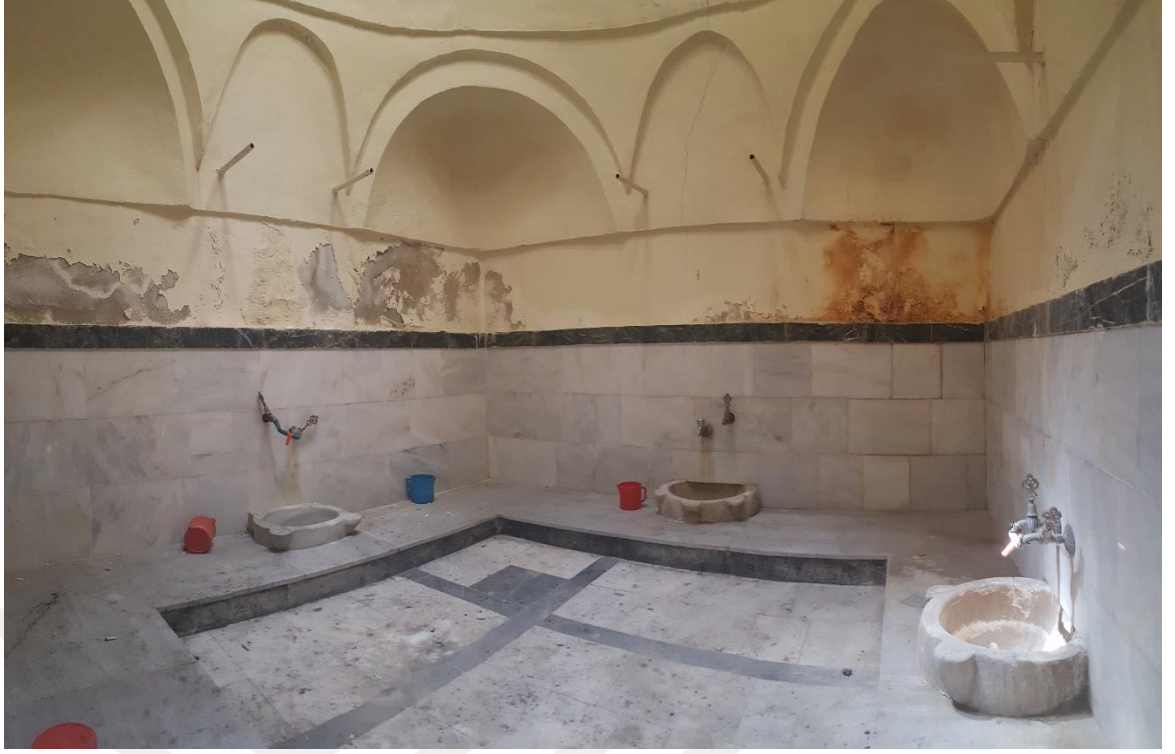
Şekil 43 : Deydinler Köyü Hamamı Sıcaklık Bölümünün Genel Görünüşü (F. Terzi 2019)
