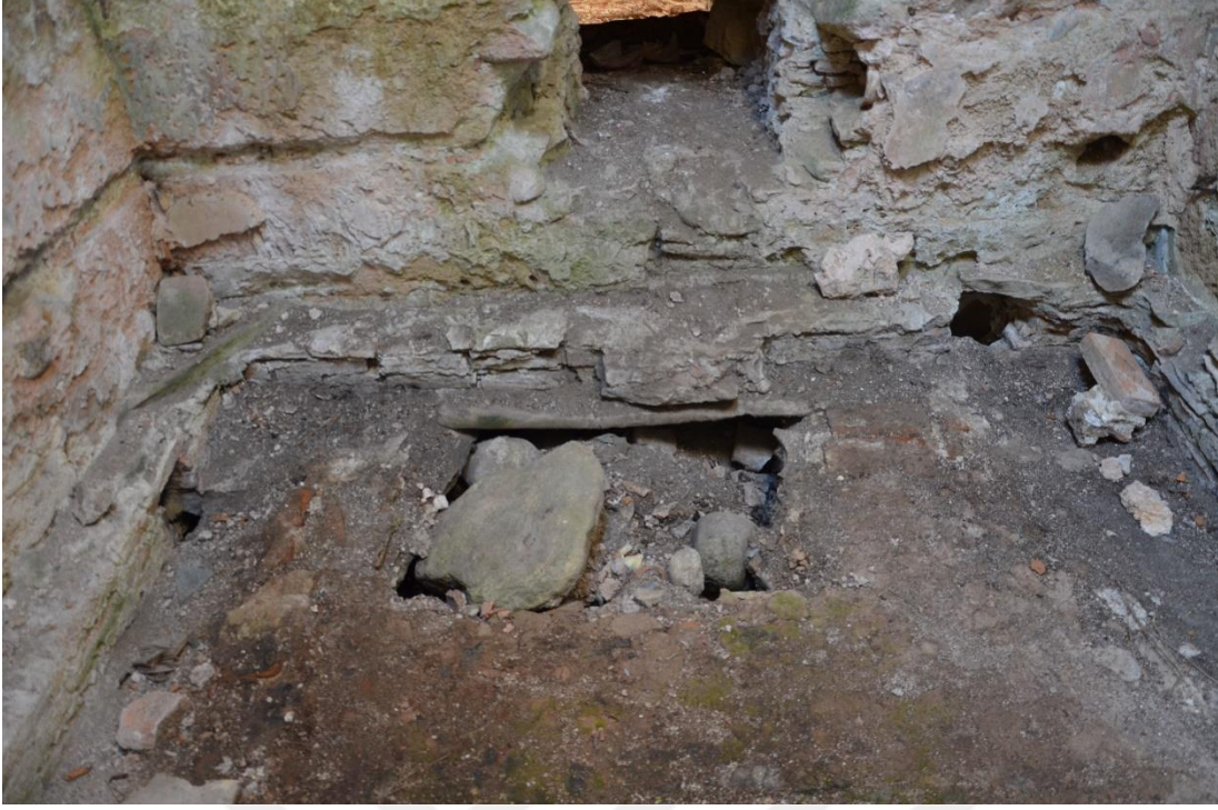
Şekil 44 : Halvet Bölümündeki Seki Ve Kurna Yeri İzlerinin Görünüşü (F. Terzi 2018)
