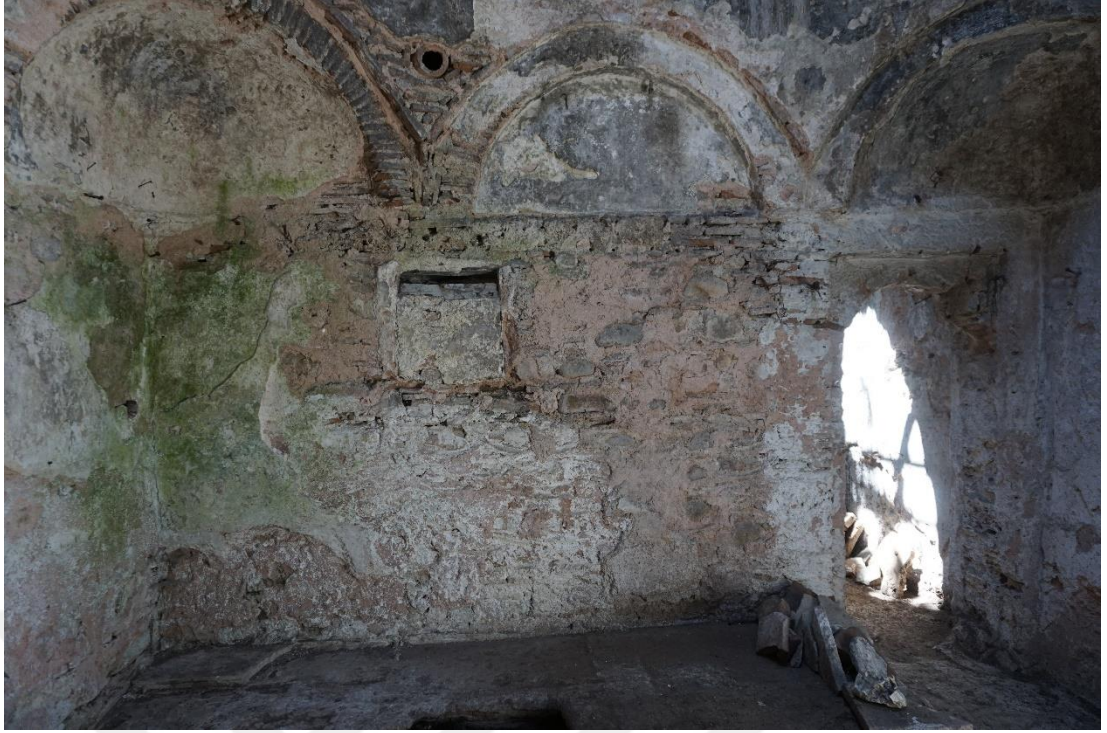
Şekil 8 : Z01 Ihlık B3lümü Batı Duvarının Görünüşü (F. Terzi 2018)
