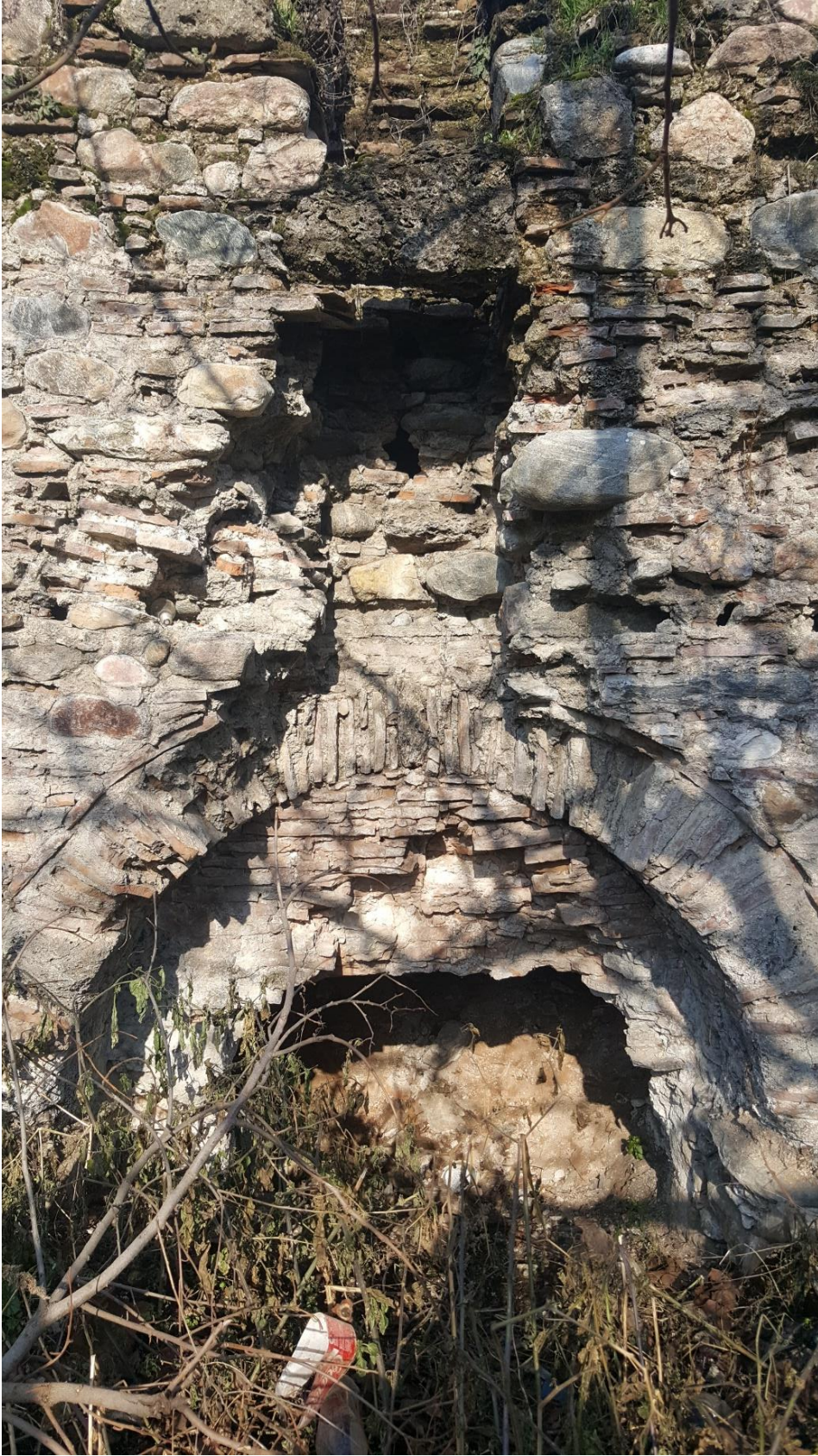
Şekil 34 : Güney Cephesinde Bulunan Külhan Girişinin Görüntüsü (F. Terzi 2018)
