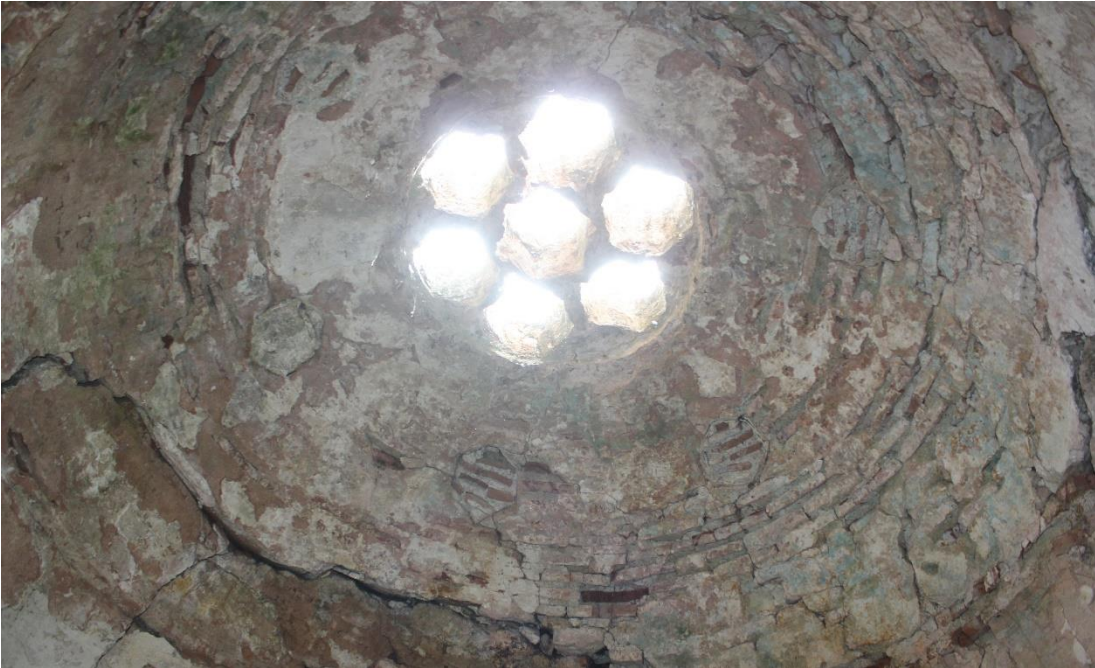
Şekil 72 : İnegöl İlçesi Kulaca Köyü Hamamı Işık Kubbeciğinin İçten Görünüşü (F. Terzi 2019)
