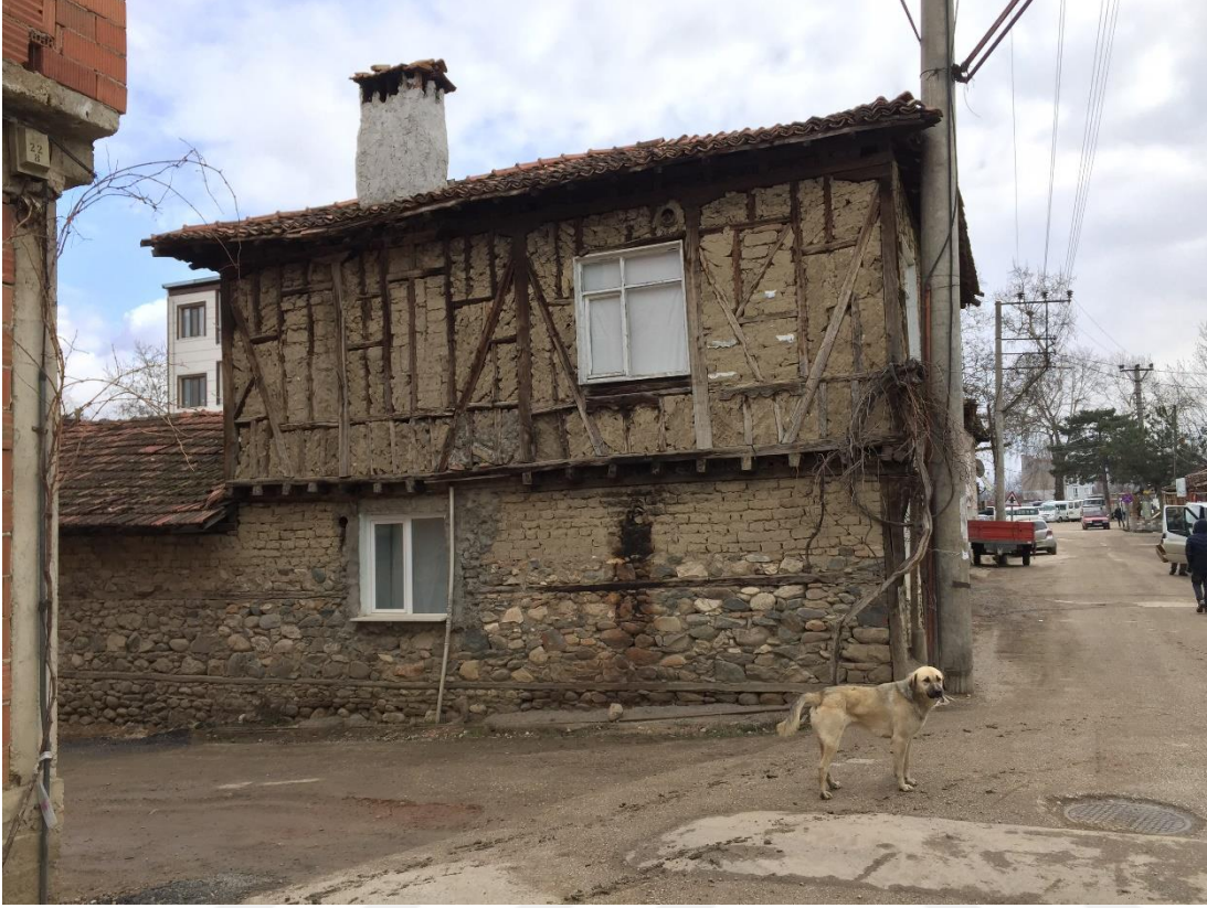
Şekil 1 : Cerrah Köy Evi Görünüşü (F. Terzi 2019)
