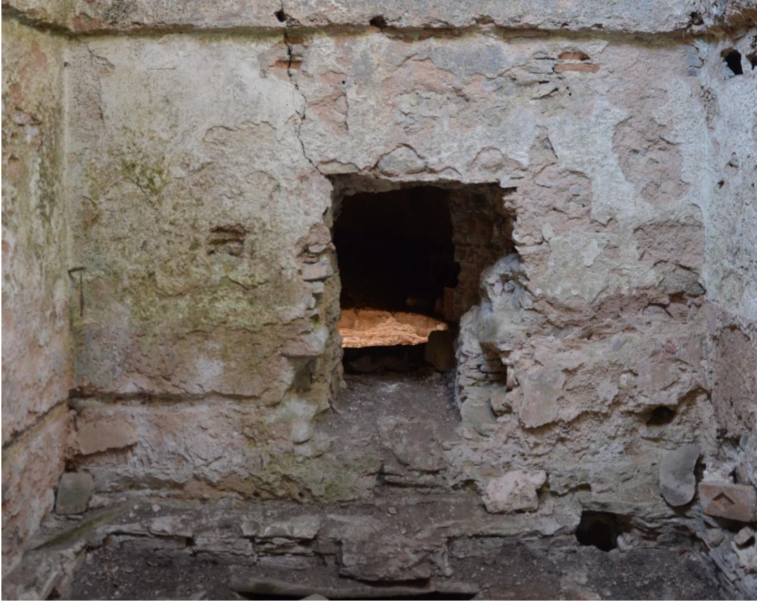
Şekil 22 : Z04 Halvetin Batı Duvarındaki Açıklığın Görünüşü (F. Terzi 2018)
