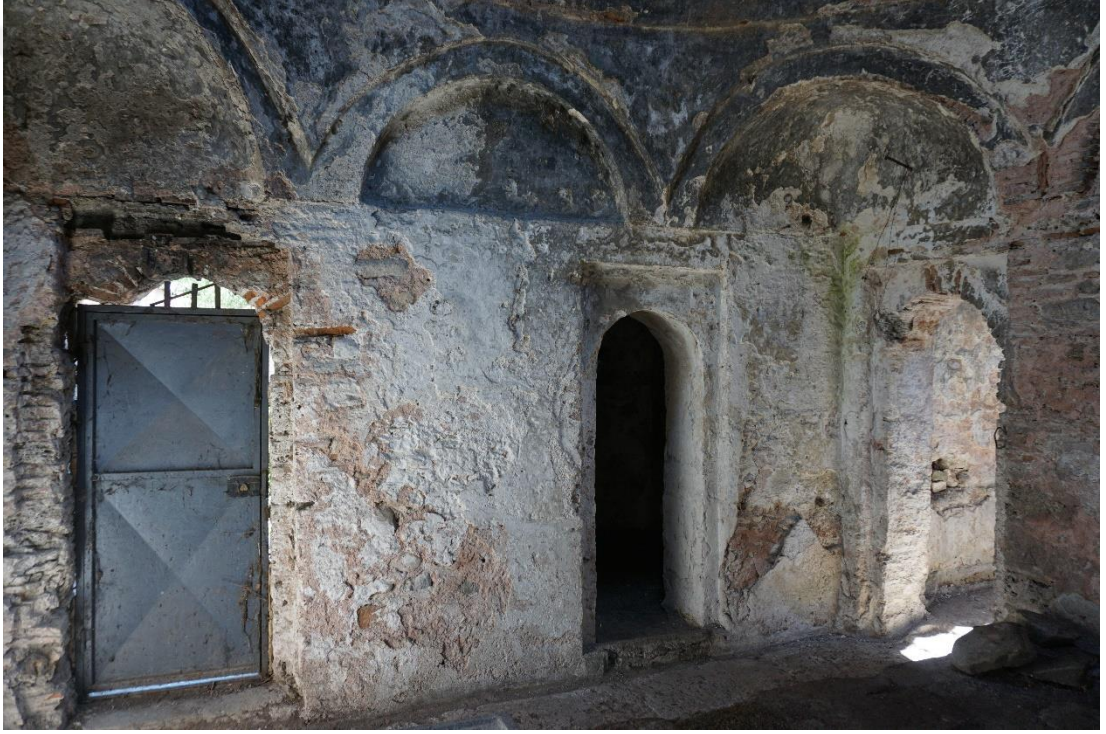
Şekil 6 : Z01 ılıklık Bölümü Doğu Duvarının Görünüşü (F. Terzi 2018)
