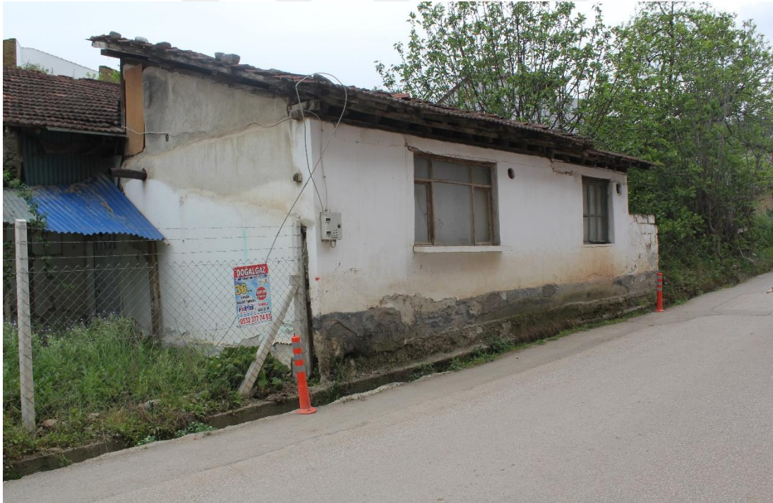
Şekil 38 : Cerrah Köyü Hamamı Kuzey Cephesinin Görünüşü (F. Terzi 2018)
