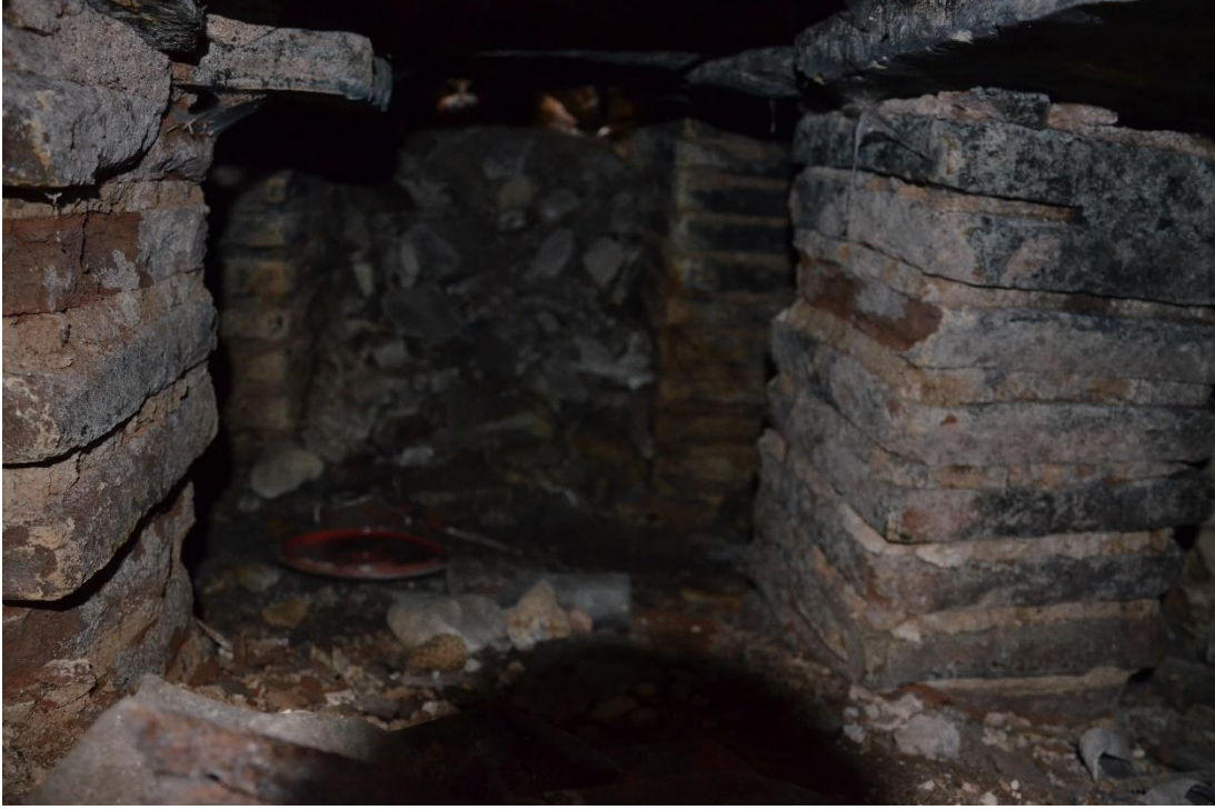
Şekil 52 : Halvetin Alt Kısımındaki Cehennemlik Bölümünün Genel Görünüşü (F. Terzi 2018)
