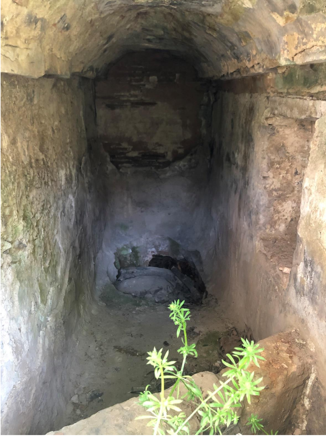
Şekil 77 : İnegöl İlçesi Sungurpaşa Köyü Hamamı Sıcak ve Soğuk Su Kısımının Görünüşü (F. Terzi 2019)
