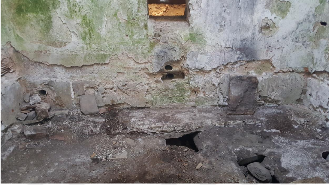
Şekil 41 : Sıcaklık Bölümündeki Seki Ve Kurna Yeri İzlerinin Görünüşü (F. Terzi 2018)
