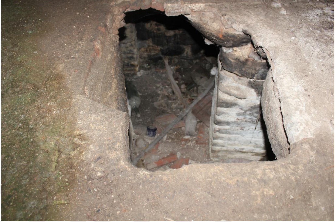
Şekil 53 : Göbek Taşının Alt Kısımındaki Cehennemlik Bölümünün Görünüşü (F. Terzi 2018)
