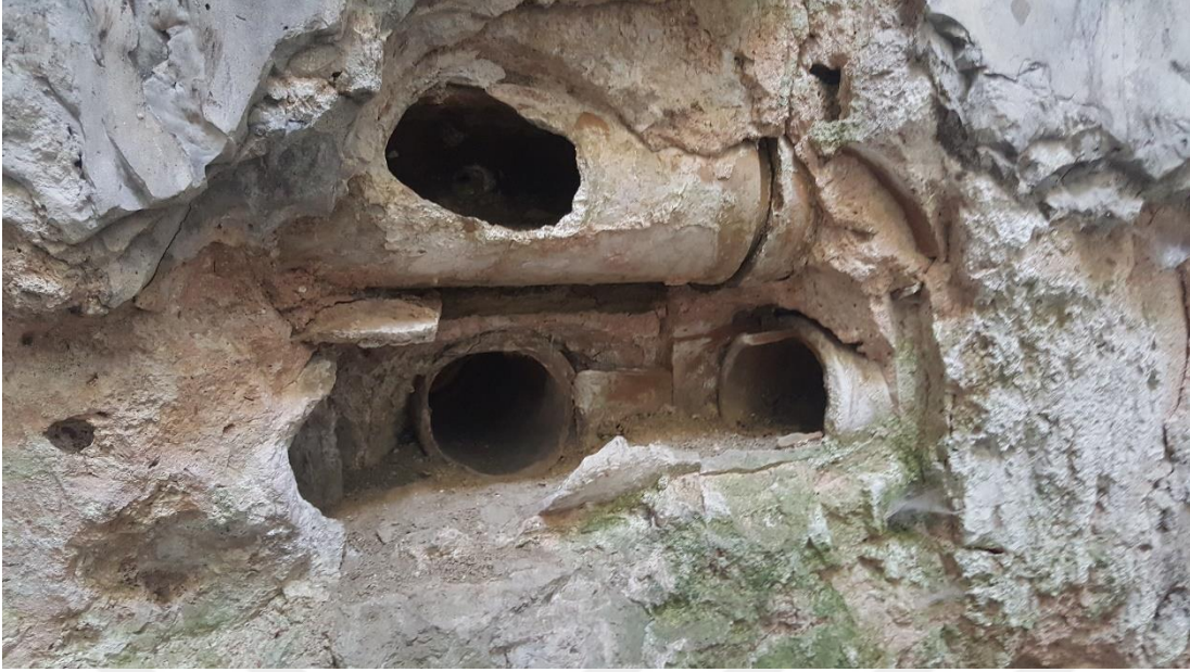
Şekil 12 : Z02 Sıcaklığın Güney Duvarındaki Su Künklerinin Görünüşü (F. Terzi 2018)
