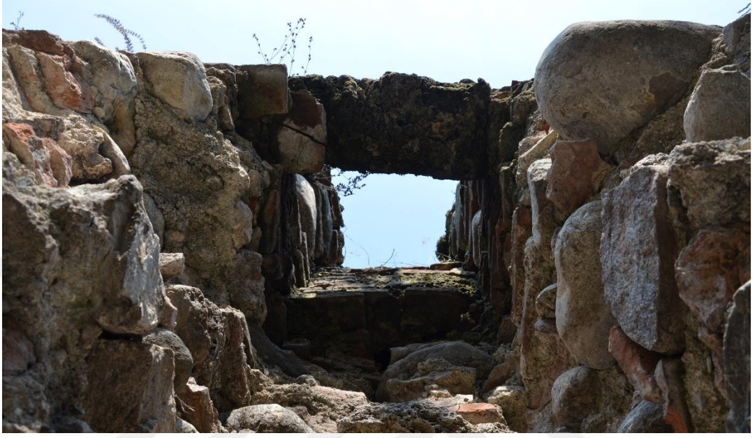
Şekil 33 : Güney Cephesinde Bulunan Baca Boşluğunun Görünüşü (F. Terzi 2018)
