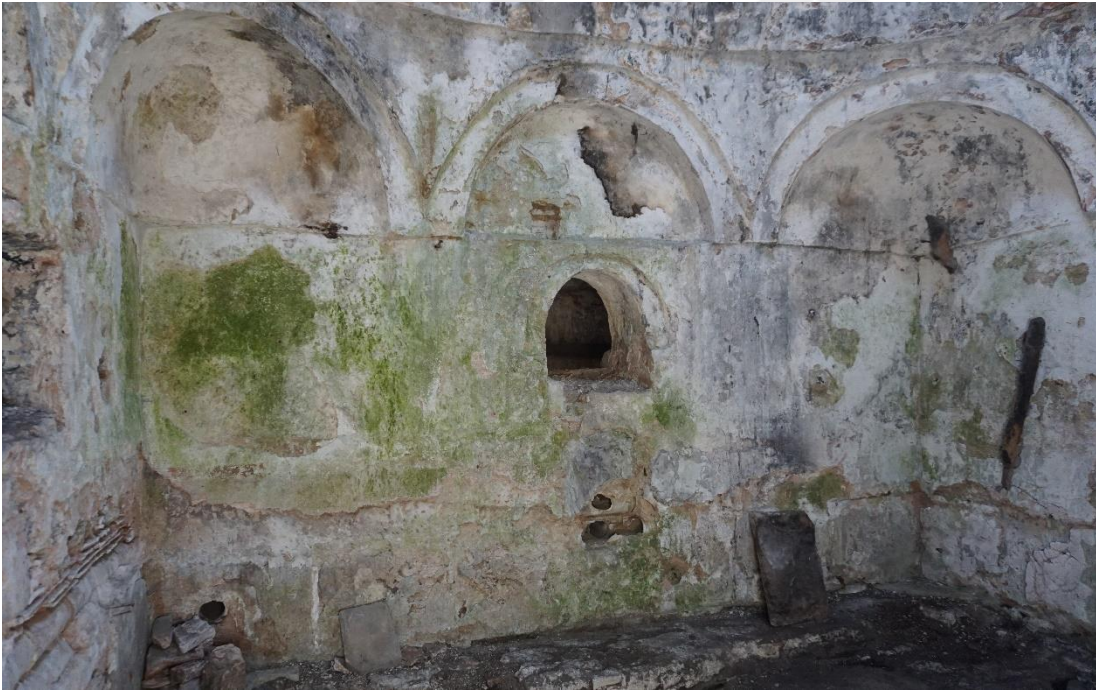
Şekil 13 : Z02 Sıcaklık Bölümü Güney Duvarının Görünüşü (F. Terzi 2018)
