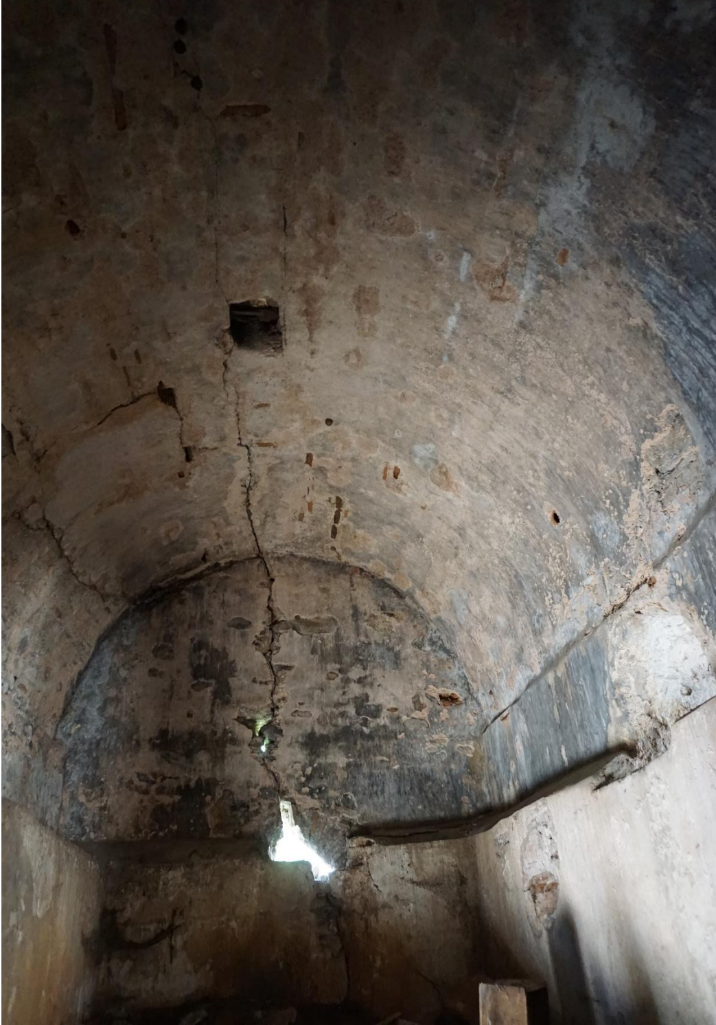
Şekil 18 : Z03 Su Deposu Bölümü Tonzunun Görünüşü (F. Terzi 2018)
