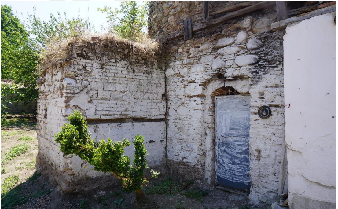
Şekil 30 : Doğu Cephesinde Hatıl Boşluklarının Görünüşü (F. Terzi 2018)
